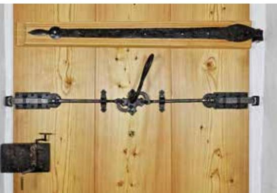
Durch die Drehvorrichtung des Sicherheitsverschlusses wird der Anpressdruck der Tür zusätzlich verstärkt.
