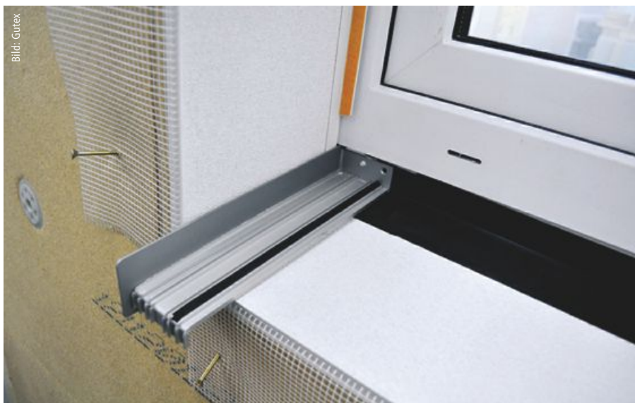
Bild 9: Nach Anbringen des Dichtbandes wird das Bordprofil mit Dichtkleber eingesetzt und am Fenster verschraubt. Die Fensterbank kann hier nach den Putzarbeiten eingesetzt werden.
