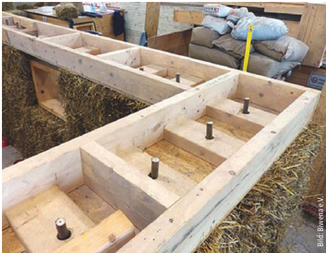
Der Ringanker mit Pins in den Strohballen sorgt in der lasttragenden Bauweise für Stabilität und gleichmäßige Lastabtragung.
