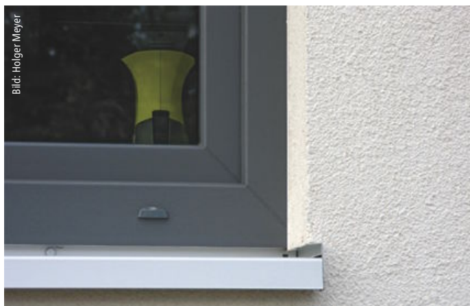
Bild 5: Fensterbank mit Endstück WDVS. Das Endstück greift in das WDVS ein, die Breite beträgt ca. 18–22 mm.
