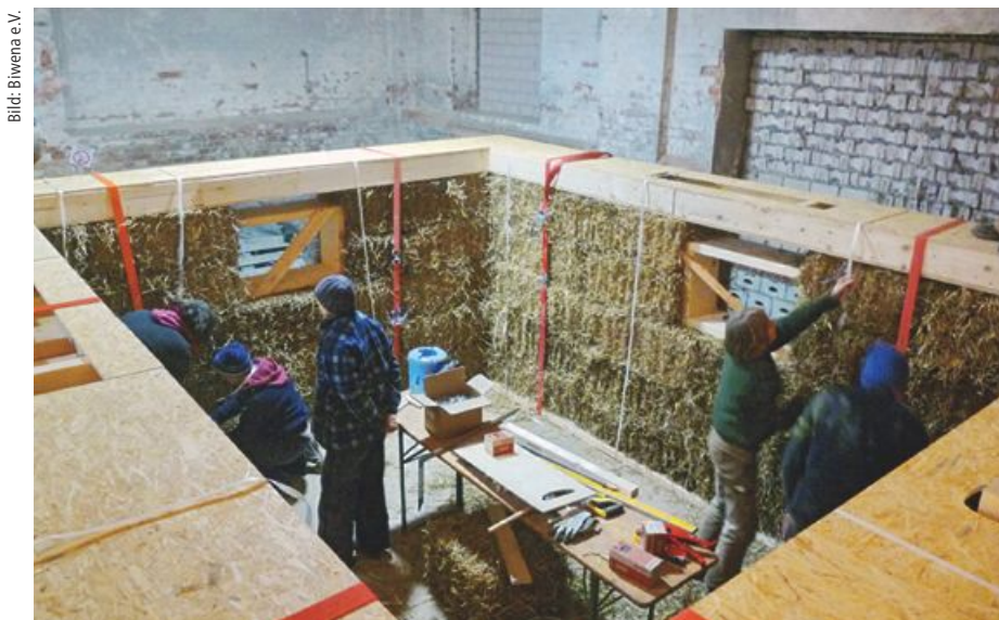
Ein eingeschossiges lasttragendes Gebäude mit Kleinballen wird im Rahmen eines Weiterbildungsworkshops für die Fachkraft Strohballenbau in Verden gebaut.
