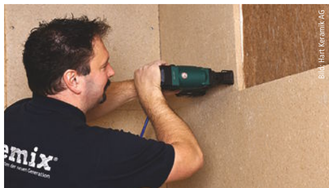
Die Befestigung erfolgt durch Schrauben mit Tellerkopf oder Halteteller, alternativ auch mit Breitrückenklammern.
