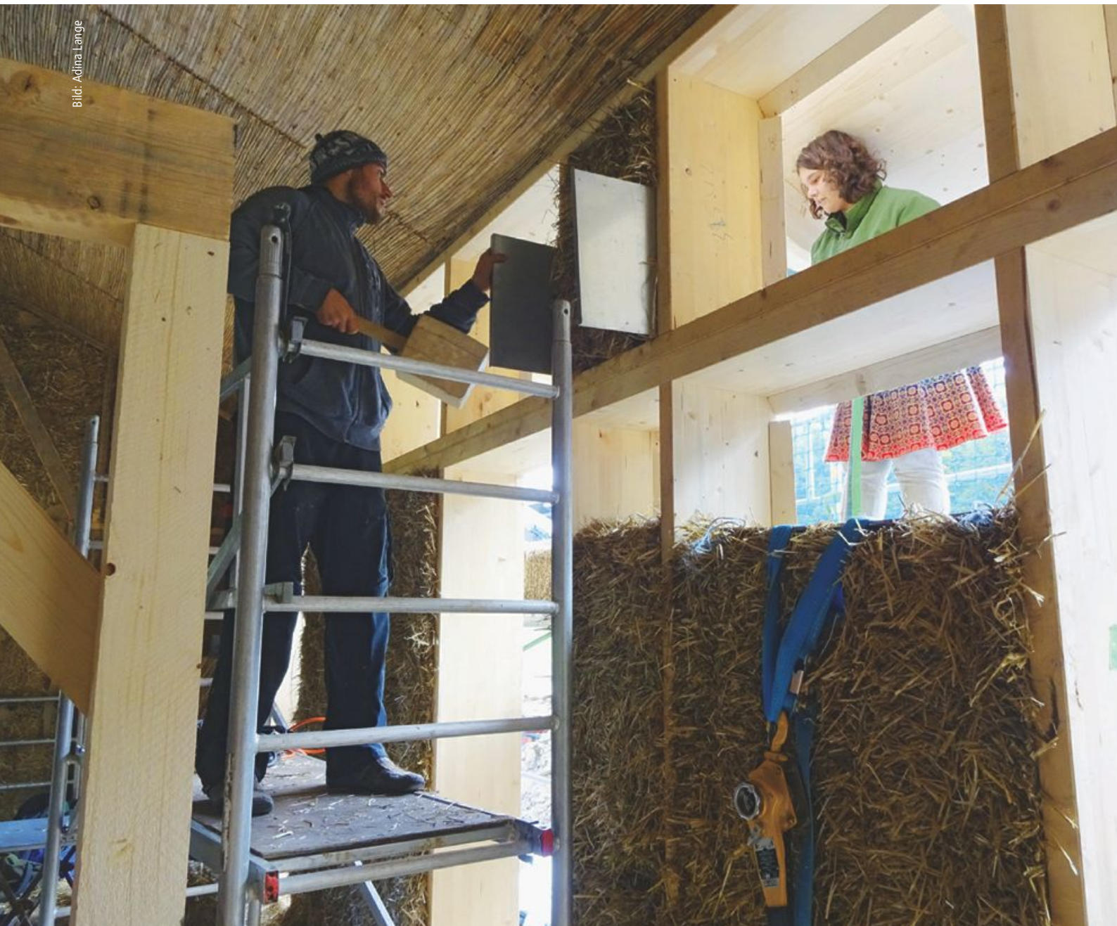
Oben: Einbau durch Rutschbleche und mit großem Holzhammer, unten: Gefach mit Brett auf Ballen und eingehängtem Kettenzug inklusive Bändern, um die Dämmung zu komprimieren und direkt den letzten Ballen einzusetzen
