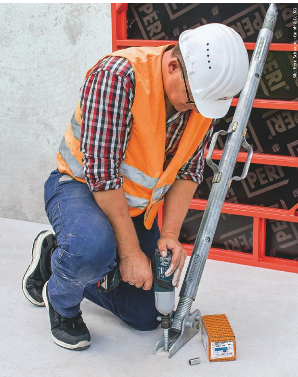
Die Europäische Technische Bewertung oder die bauaufsichtliche Zulassung regelt, wofür die Betonschraube eingesetzt werden darf. Mit der abgebildeten Schraube dürfen beispielsweise die temporären Befestigungen von Baustelleneinrichtungen verankert werden.
