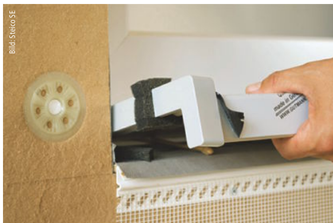
Bild 6: Die seitliche Fuge zwischen Gleitabschlussprofil der Fensterbank und Rohbaulaibung wird mit einem Komprimband (Beanspruchungsgruppe BG1) abgedichtet.
