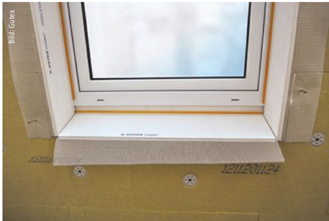
Bild 8: System aus kaschierten Laibungsplatten und Dämmkeil unter der Fensterbank. Sämtliche Fugen sind mit Dichtkleber zu verschließen.
