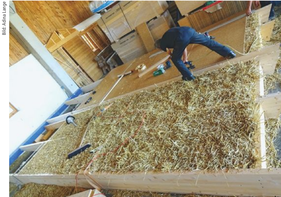
Vorgefertigtes Dachelement mit OSSB-Platten („Oriented Structural Straw Board“, Bauplatte aus Weizenstroh). Spannungsurte verhindern ein „Bauchen“ der Sparren.
