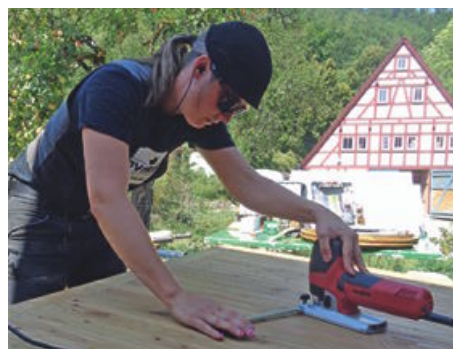
Die runden Fensterausschnitte der Türen wurden mit einer Stichsäge von Mafell und dem Kreisschneideanschlag gesägt.
