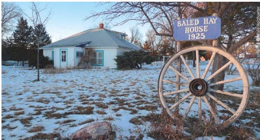
Das Baled Hay House von Martin Monhart wurde 1925 mit Heuballen und lasttragend in Arthur, Nebraska, gebaut.
