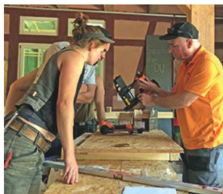
Als Beplankung wählten die Handwerksleute OSB-Platten, die sie mit Hilfe von KMR Naglern befestigten.
