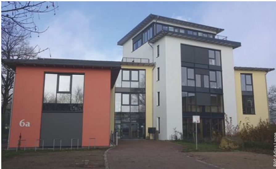
Das Norddeutsche Zentrum für Nachhaltiges Bauen (NZNB) in Verden bei Bremen wurde vor wenigen Jahren in Strohballenbauweise erstellt. Die Entwurfsverfasser waren Architekten für Nachhaltiges Bauen: Thomas Isselhard, Dirk Scharmer und Frido Elbers.
