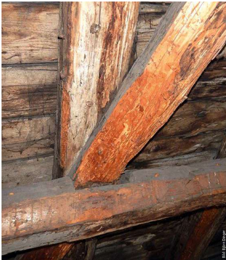
Bild 4: Abgebeilte Schadensbereiche und Bohrlöcher im horizontalen Riegel, die auf eine Holzschutzmittelbehandlung hindeuten.
