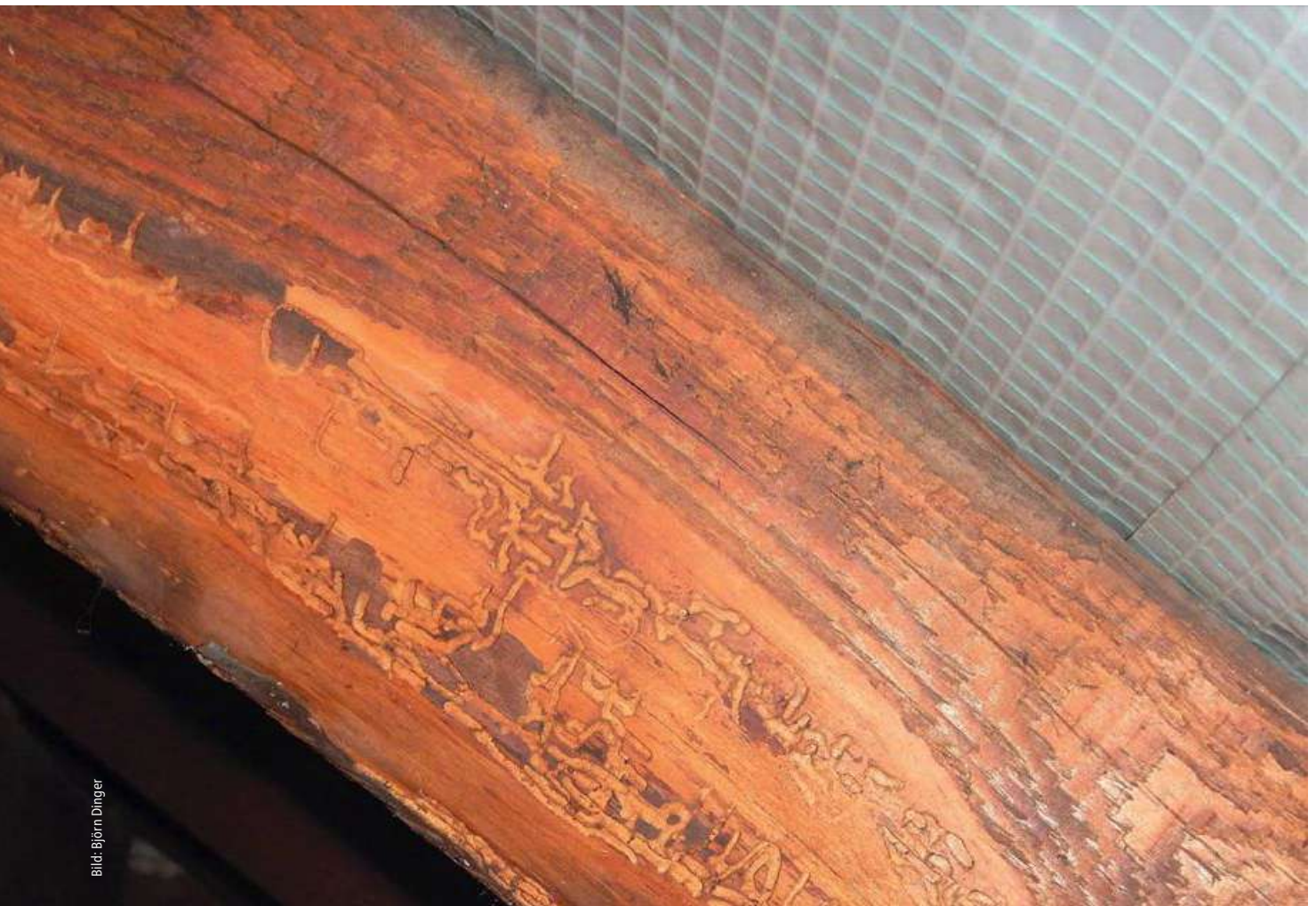
Bild 1: Fraßgänge von Frischholzinsekten an einer Sparrenoberfläche
