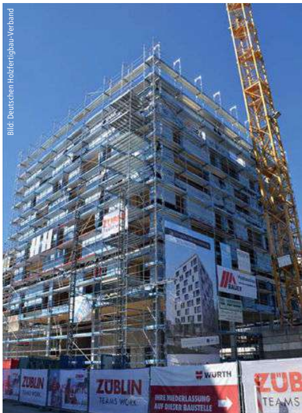
Derzeit noch eine Baustelle ...
