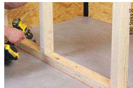
Bild 6: Zur Schallentkopplung ist die Schwelle aus Furnierschichtholz mit einem Akustik-Dämmstreifen aus Holzfasern unterlegt.
