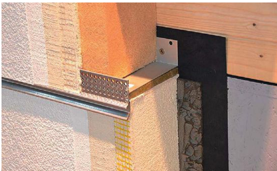
Bild 12: Eine Sockelschiene schützt vor Quetschalten oder Rissen.
