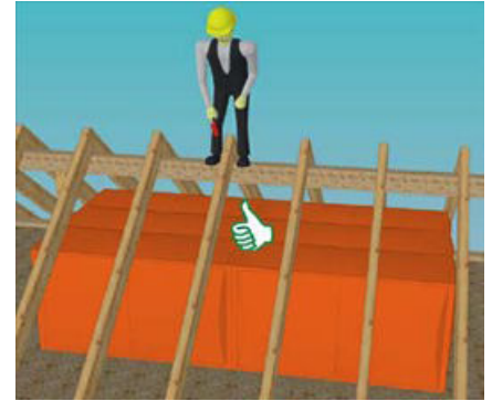
13 | Mit Safety Fall Bags können Arbeitsplätze bis in 4,10 m Höhe über dem Boden abgesichert werden. Mit einer zweiten Lage sogar bis 5,20 m. Sie sind ideal bei kurzzeitigen Tätigkeiten einsetzbar, in denen sich andere Maßnahmen nur schlecht umsetzen ließen.
