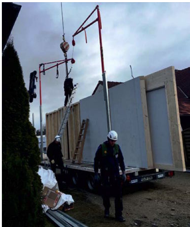
6 | Ein für viele Zimmerer sicher gewöhnungsbedürftiges Foto. Hier ist der Anschläger über an zwei schwenkbaren Galgen angebrachte HSGs gesichert. Diese befinden sich in optimaler Position oberhalb des zu Sichernden. Zwei Galgen wurden gewählt, um dem Anschläger viel Bewegungsfreiheit ohne das Risiko eines Pendelsturzes zu geben. Entfernt er sich von einem Anschlagpunkt, wird er im Falle eines Absturzes sicher vom anderen HSG gehalten.
