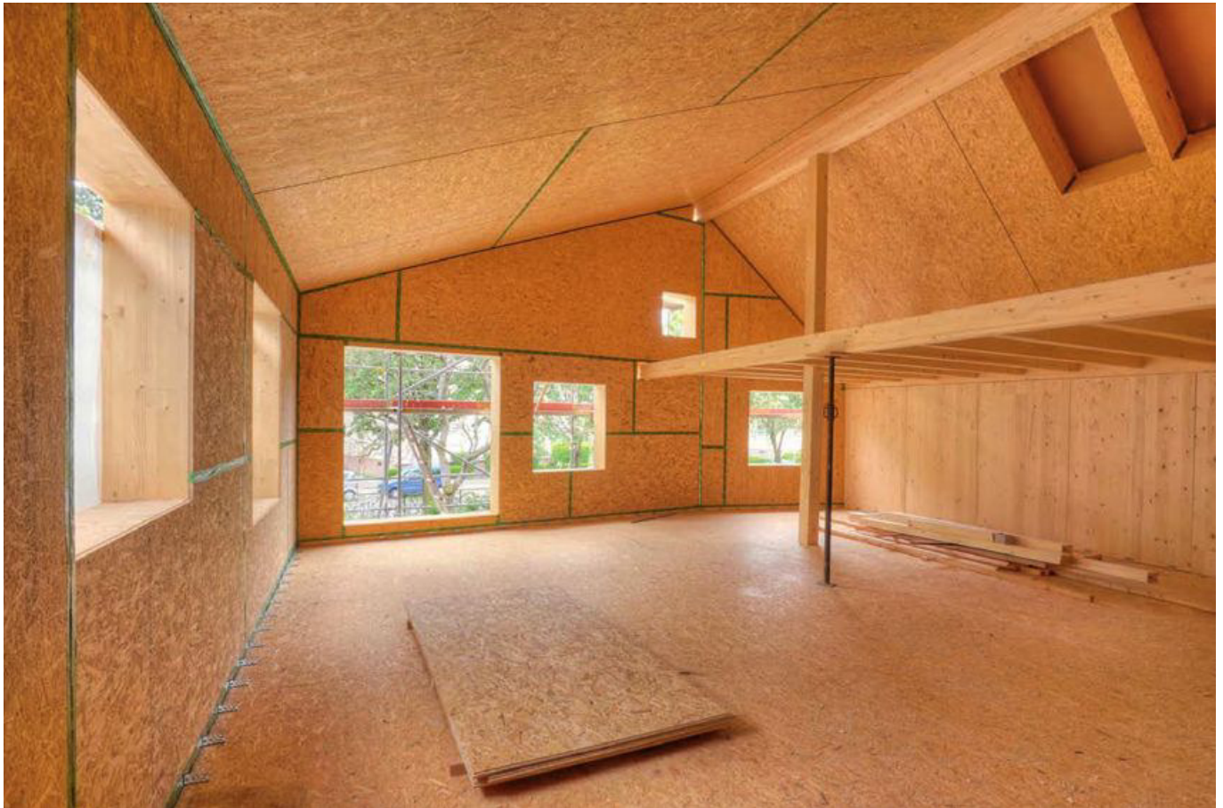
OSB-Platten werden bei Wand-, Decken- und Dachelementen häufig als raumseitige Beplankung eingesetzt. Die Stöße werden raumseitig luftdicht abgeklebt.
