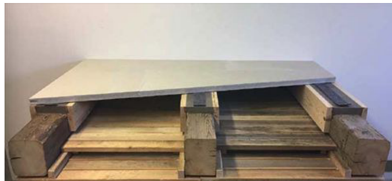
Der Fußboden wird mit dem Polymervergussystem in Kombination mit Gipsfaserdeckenplatten bis zur Oberseite der ertüchtigten Deckenbalken ausgebaut.
