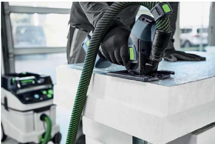
Wie hier beim Schneiden des kaschierten EPS-Dämmstoffs, kann für sauberes und gesundes Arbeiten über den Absaugadapter ein Absaugmobil angeschlossen werden.
