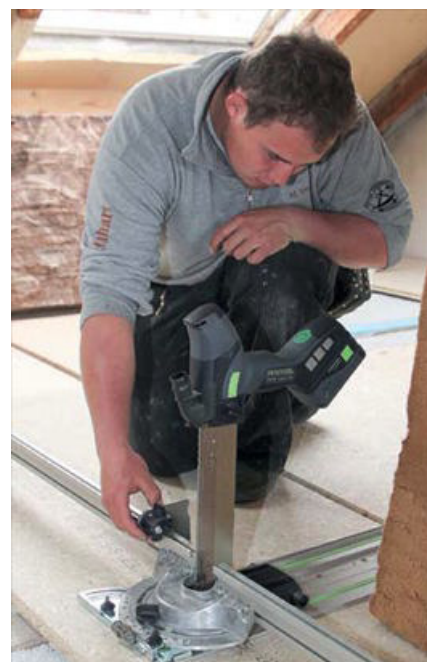
Geht extrem schnell: Maße abnehmen, auf die Skale mit dem Winkelanschlag übertragen, sägen und fertig.
