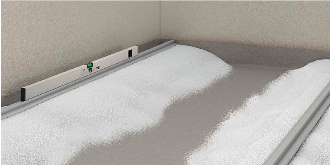
Bei Höhen bis zu 100 mm kann eine nichtgebundene Ausgleichsschüttung zum Einsatz kommen. Zunächst werden mit ihr Dämme angelegt und eine Niveauschiene darauf ausgerichtet.
