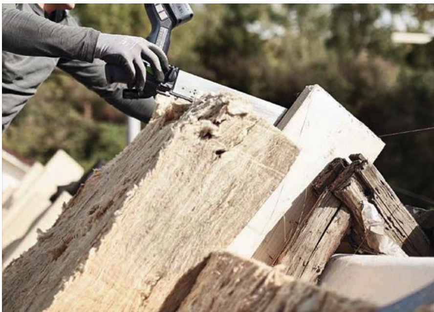
„Wir verwenden die Säge vorwiegend in der Montage auf der Baustelle“, erläutert Andreas Jakob. „Wir rollen die Dämmplatten aus – direkt auf den Sparren und nutzen die Sparren als Schnittführung.“
