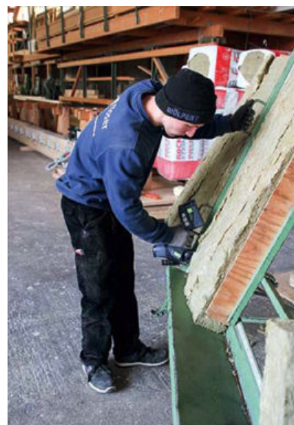
Holzbau Moser verwendet die neue Säge auch bei der Dämmung von Holzständerwänden. Für den körperschonenden Zuschnitt im Stehen verwendet Moser ein Schneidgestell.
