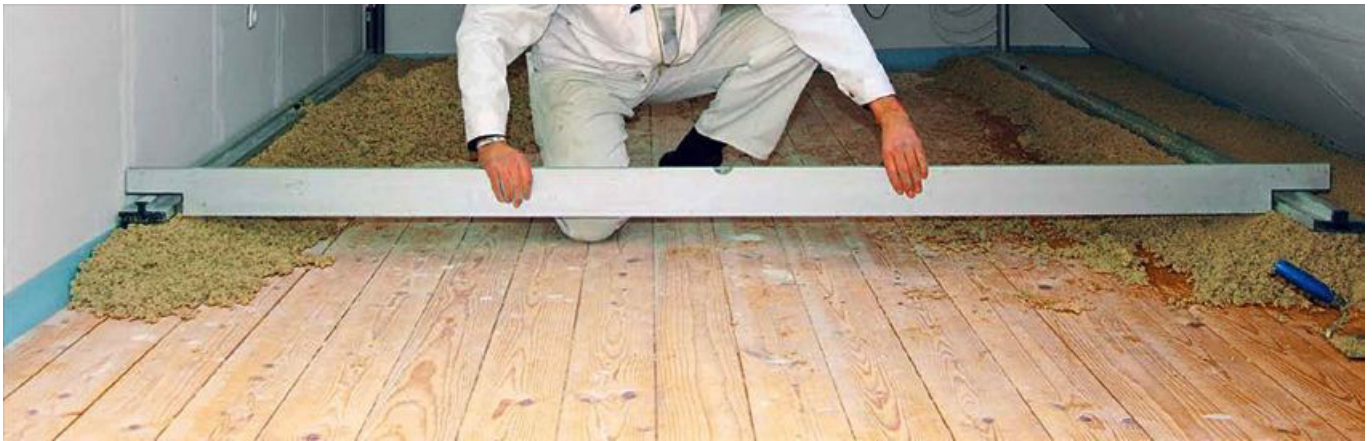
Sobald die Dämme angetrocknet sind, wird die gebundene Schüttung zwischen die Dämme ausgebracht und abgezogen.
