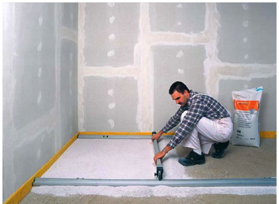
Im nächsten Schritt kann die Schüttung zwischen den beiden Dämmen eingebracht und auf das genaue Maß abgezogen werden.
