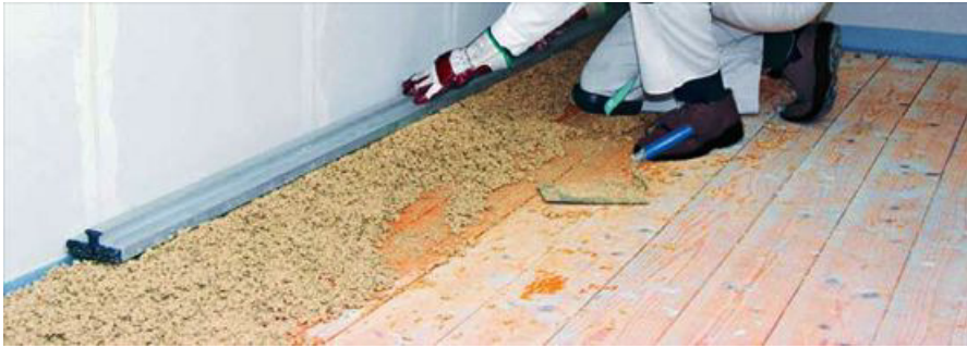
Die gebundene Schüttung eignet sich, um sehr große Unebenheiten, bis zu 2.000 mm, auszugleichen. Auch bei ihrer Verarbeitung werden zunächst Dämme in der vorgesehenen Höhe angelegt.
