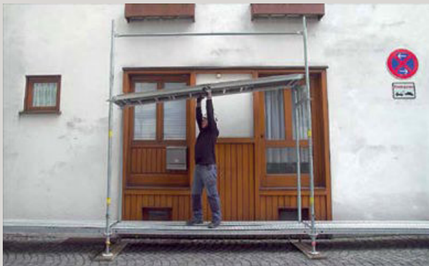
5 | Danach wird der selbstsichernde Belag für die zweite Gerüstlage eingehoben ...
