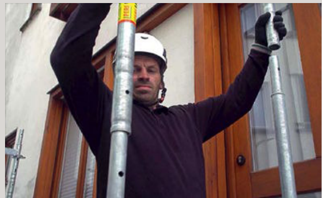
4 | ... bevor dieser auf den rechten Basisrahmen aufgesetzt wird.
