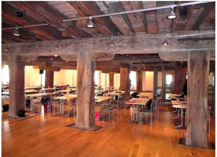
5 | Die hölzerne Tragkonstruktion verblieb – richtig nachgewiesen – unbekleidet in einer mehrgeschossigen Versammlungsstätte.
