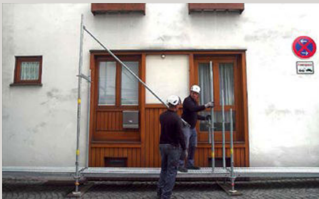
3 | ... wird dessen anderes Ende am Rahmen gegenüber befestigt, ...
