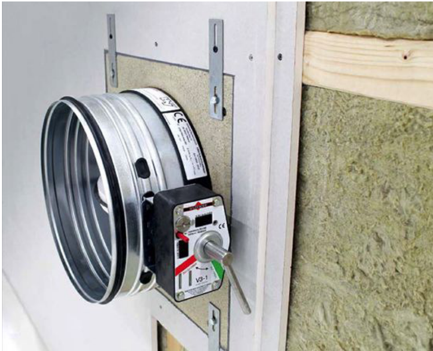
Speziell darauf geprüfte Brandschutzklappen lassen sich in Holzrahmenwänden verbauen, ohne die Laibung in der Einbauöffnung mit Gipsplatten verkleiden zu müssen.
