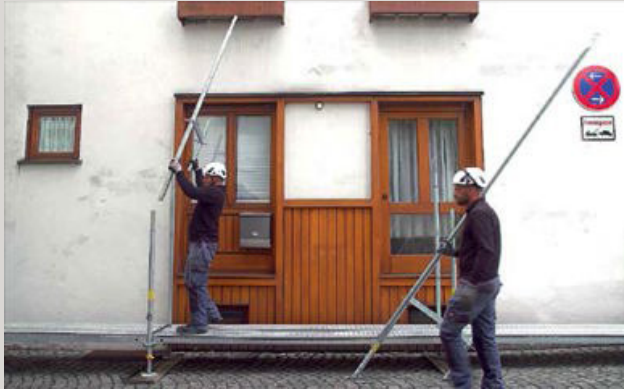
1 | Zuerst wird der Rahmen auf den offenen Basisrahmen der untersten Gerüstlage aufgesetzt.
