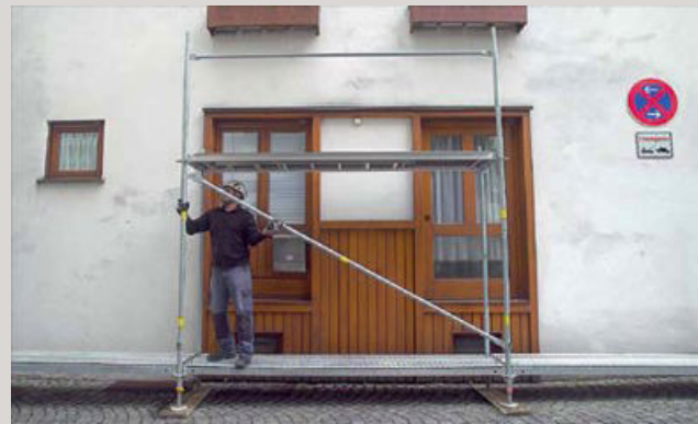
6 | ... und anschließend die Längsdiagonale beidseitig befestigt. Der geforderte Seitenschutz ist damit schon vor Betreten der neuen Gerüstlage vollständig vorhanden.
