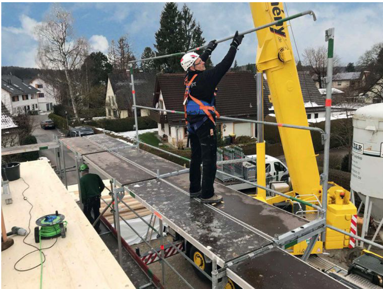
Beim Aufbau eines Gerüsts schützt die persönliche Schutzausrüstung vor Absturz und der Helm vor herabfallenden Gegenständen.
