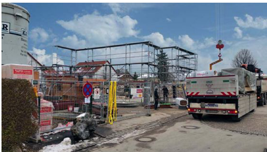
Erst wird das Gerüst aufgestellt. Dann kann mit dem Richten des Holzhauses begonnen werden.
