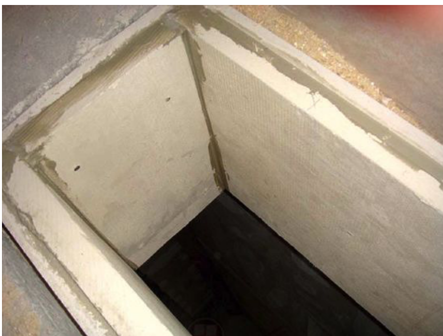
4 | Abschottung in einer bestehenden Holzbalkendecke
