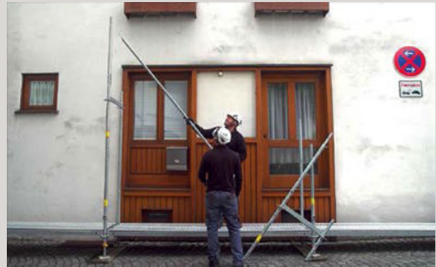
2 | Nach dem Einhängen des Geländerholms links oben ...
