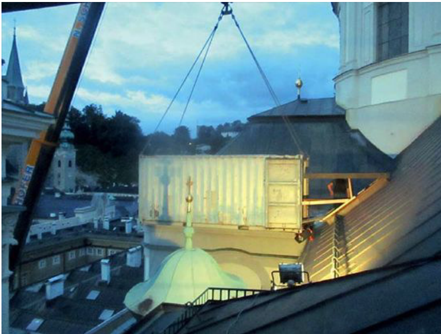
Oben wurde das Material ausgeladen und durch eine Dachluke nach innen geschafft. Der Weg führte über zwei gegen Abrutschen gesicherte Gerüstbohlen. Eine beiseitige Brettumwehrung schützte vor Absturz.
