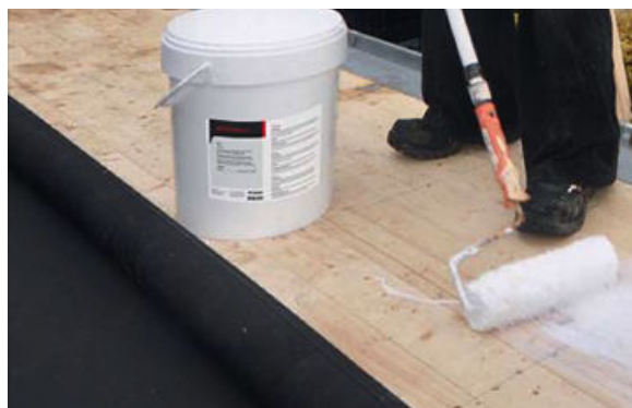
Das Abdichten einer Fläche von 100 m 2 ist unter optimalen Bedingungen in etwa drei Stunden möglich.
