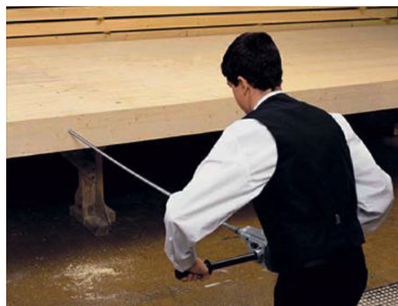
Auch bis zu 3 m lange Gewindestangen mit Holzgewinde wurden neu ins Portfolio aufgenommen. Diese können als Querzugverstärkung im Holz dienen.
