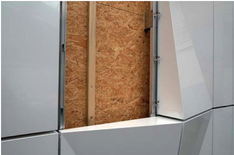
Mit Aluminiumverbundplatten lassen sich vorgehängte hinterlüftete Fassaden herstellen. Dabei sind auch dreidimensionale Formgebungen möglich.
