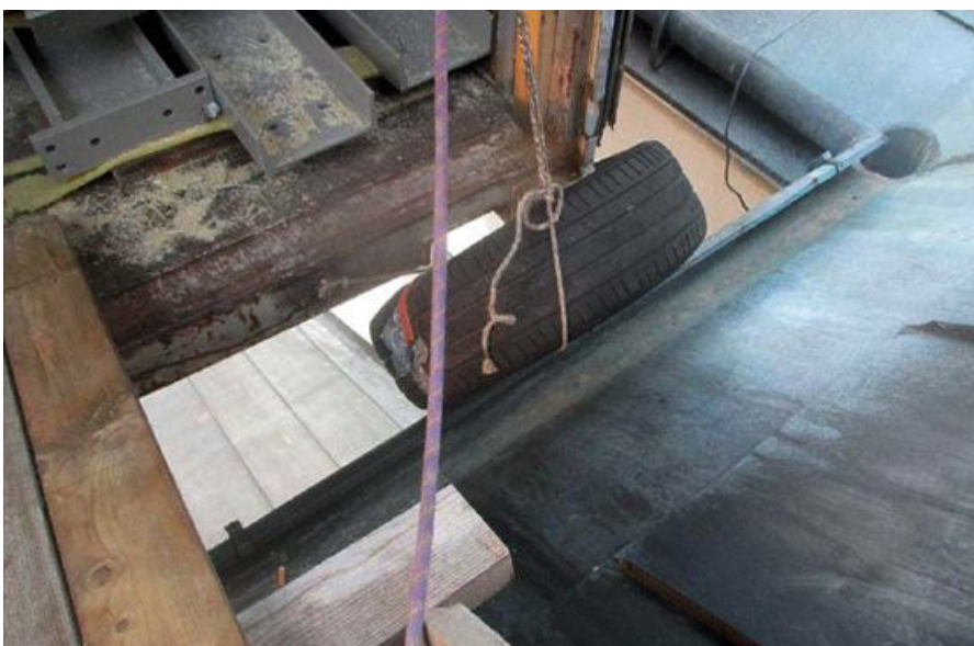
Dank der Autoreifen konnte der Container an der Dachfläche weich andocken, so dass er nicht während des Entladens hin- und herschwang.
