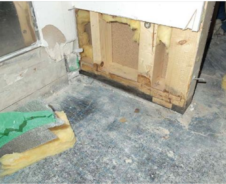
Nachdem der Fußbodenaufbau bis zur Bodenplatte zurückgebaut worden war, wurden auch die Innenwände im unteren Bereich freigelegt.
