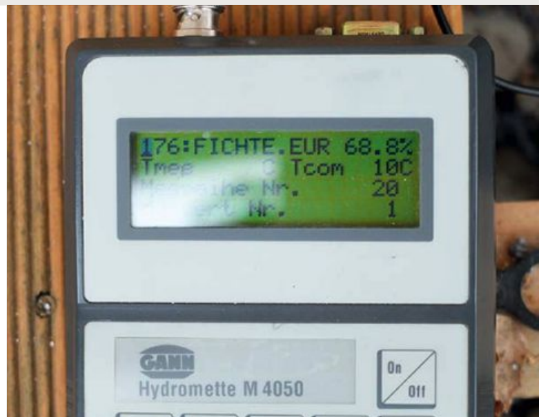
Dort wies die Schwelle eine Holzfeuchte von 68,8 % auf.
