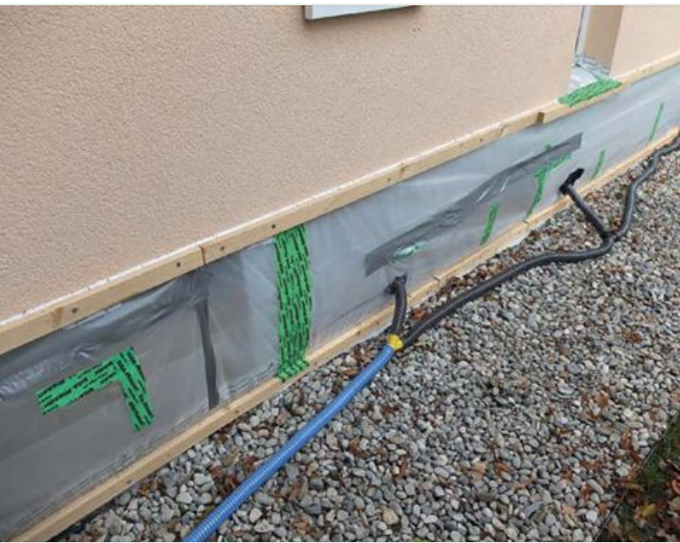
Zunächst ließ der Fertighaushersteller den Sockelbereich der gesamten Nordaußenwand zum Zweck der Trocknung mit Heißluft durchblasen.
