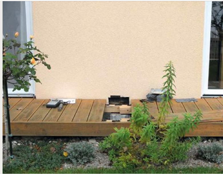
Aufgrund großer Zweifel an der Darstellung des Fertighausherstellers öffnete der vom Bauherrn beauftragte Sachverständige zur Probe den Sockel an der Außenwand Süd (Wohnzimmer).
