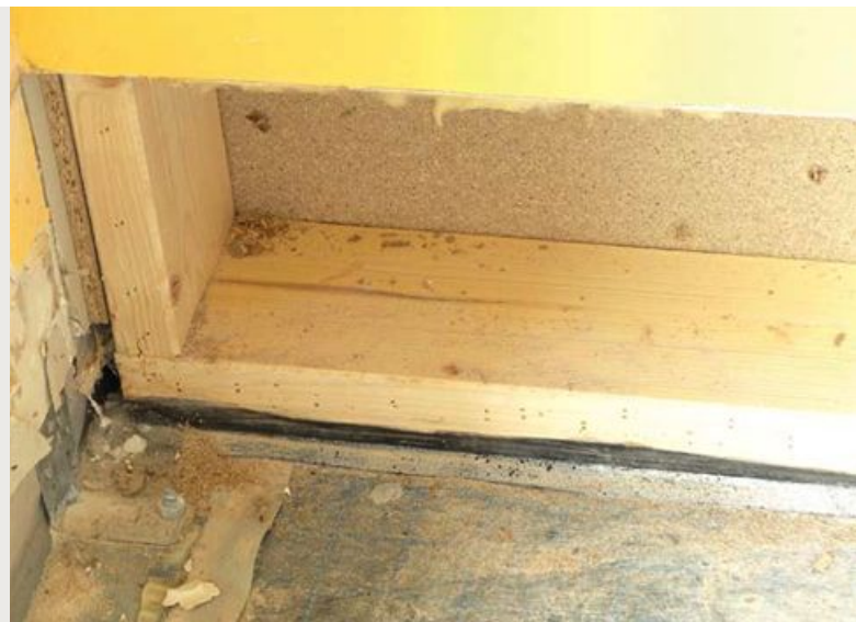
Bei einigen Holzriegelteilen reichte es aus, diese mit einer Rundtopfbürste von dunklen Verfärbungen zu reinigen, das Holz war in seiner Substanz noch nicht geschädigt.
