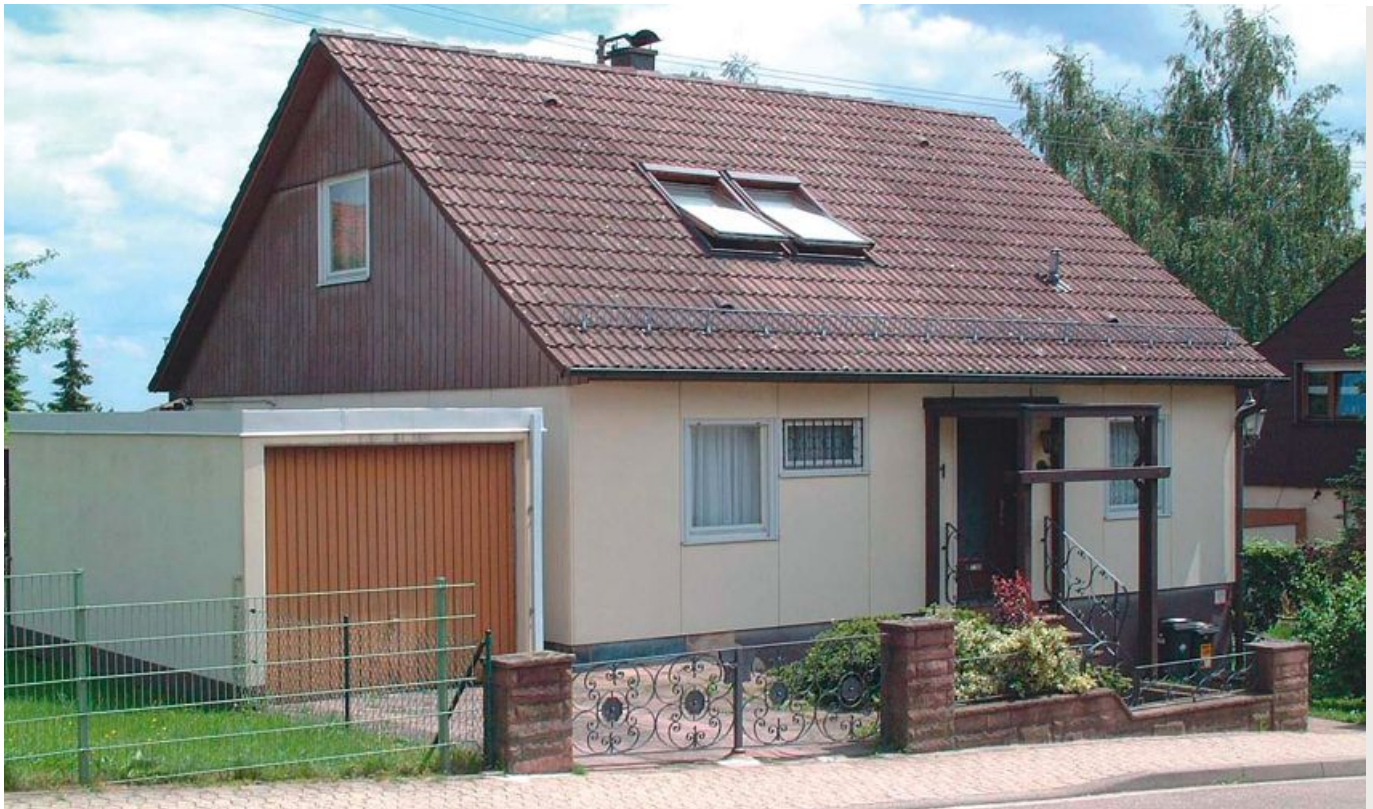
Typisches Fertighaus der älteren Generation mit hinterlüfteter Putzfassade auf Asbestzementplatten und sichtbaren Fugen zwischen den Platten.
