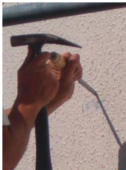
Wichtig ist, dass die Asbestzementplatten möglichst wenig beschädigt werden. Daher müssen zunächst die Montageschrauben vorsichtig freigelegt werden.
