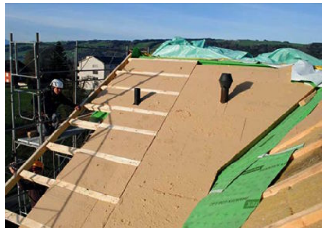
Zentraler Bestandteil des Konstruktionsaufbaus ist die diffusionsoffene Luftdichtbahn, die flächig oberhalb des Sparrens verlegt wird statt, wie zuvor üblich, schlaufenförmig im „Berg-und-Tal-Verfahren“. Den Abschluss der Konstruktion bilden diffusionsoffene Holzfaserdämmplatten.
