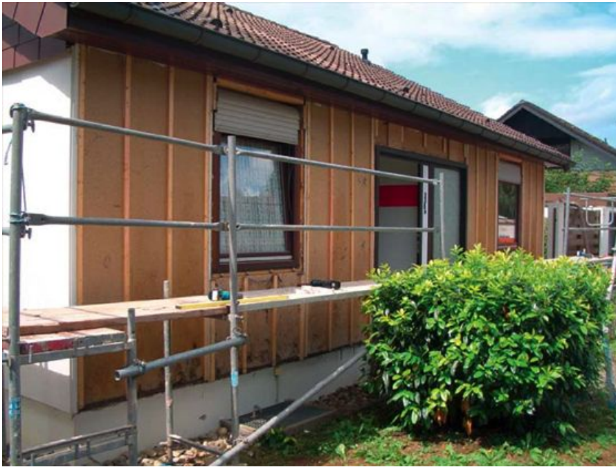
Als Außenbeplankung kamen vielfach V100G-Platten zum Einsatz. Sie sind mit Fungiziden ausgestattet. Das „G“ steht für eine Verwendbarkeit auch an Orten, wo eine hohe Luftfeuchtigkeit zu erwarten ist.
