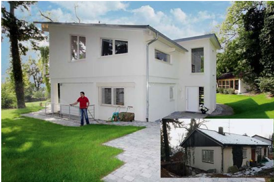
10 | Bestandsgebäude und Aufstockung wirken hier wie aus einem Guss. Der Außenwandübergang zu der Fassadenbekleidung der Aufstockung (hinterlüftete Putzträgerplatten) zeichnet sich als feine Linie ab (Übergangsprofil in der Putzfassade).
