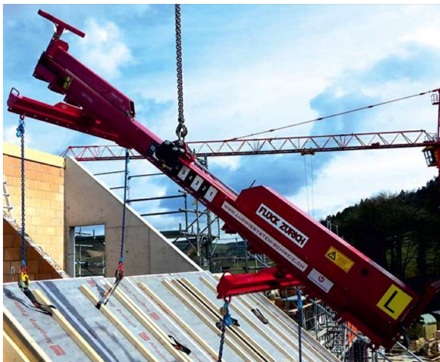
15 | Die Funktraverse Simia Spreader ermöglicht das Anschlagen von Dachelementen in Dachneigung. Eine Skala an der Seite ermöglicht das erneute Anfahren bestimmter Neigungen nach der Aufnahme waagrecht transportierter Lasten. Die hier ebenfalls eingesetzten Funkhaken Ludwig Hook dürfen erst gelöst werden, wenn das Dachelement an die Pfetten angeschlossen ist.
