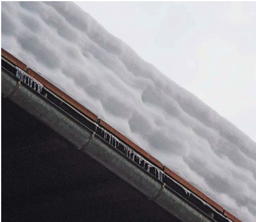
Bei Dächern mit Dachneigungen ab 60° wird davon ausgegangen, dass kein Schnee mehr auf der Dachfläche liegen bleibt.
