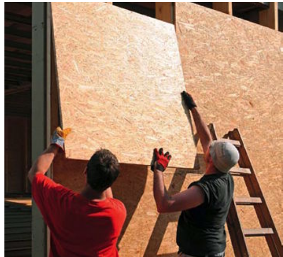
Die Ausführung OSB/4 soll sich durch eine geringere Dickenquellung und erhöhte Festigkeits- und Steifigkeitseigenschaften auszeichnen.
