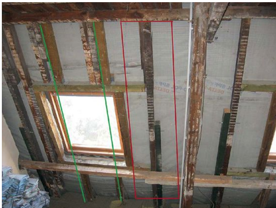
Die Lasteinzugsbreite von einem Feldsparren läuft, ohne Auswechslung, von Feldmitte bis zu Feldmitte.
