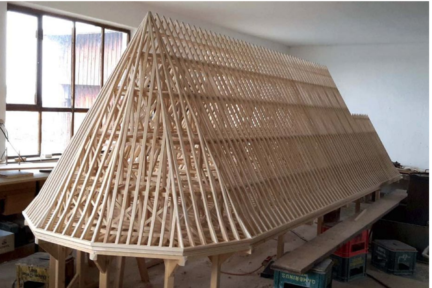
Das Modell: Josef Hauer baute den Dachstuhl im Maßstab 1:15 mit allen Holzverbindungen originalgetreu nach.
