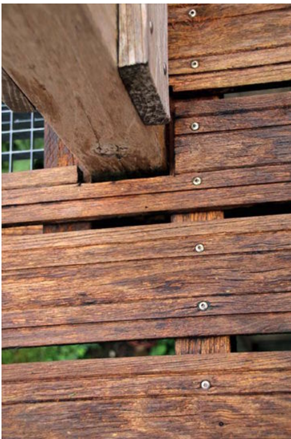
8 | Nach der Reinigung und der Lasur lassen die Bodenbretter wieder ihre Maserung sehen. Außer der Verschmutzung und Vergrauung war an ihnen nichts auszusetzen.
