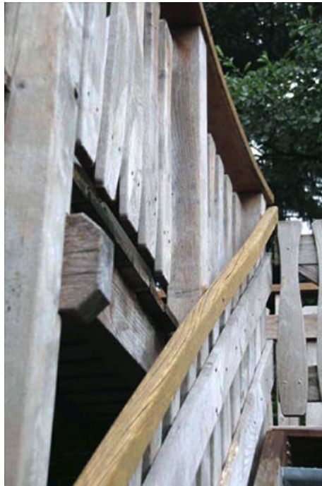
3 | Die längeren Handläufe haben sich dort, wo der Faserverlauf krumm ist, verzogen.
