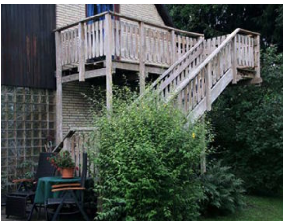
9 | Die UV-bedingte Vergrauung kann wie eine edle Patina wirken. Natürlich ist das Geschmacksache. Schädlich für das Holz ist sie keinesfalls.
