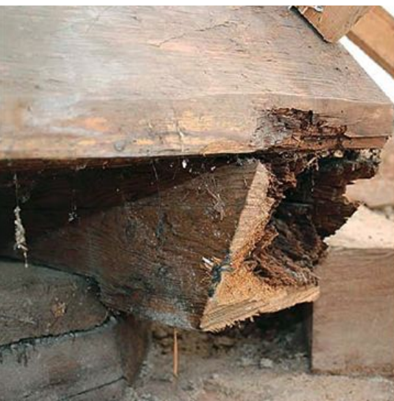
Der Balkenkopf weist im eingemauerten Bereich Schäden auf (linkes Bild). In 5-cm-Schritten vom geschädigten Kopfende kann mit Bohrwiderstandsmessungen der Übergang vom geschädigten zum intaktem Holz bestimmt werden. Im Bohrprofil ist der Schaden (rote Markierung) deutlich zu erkennen.
