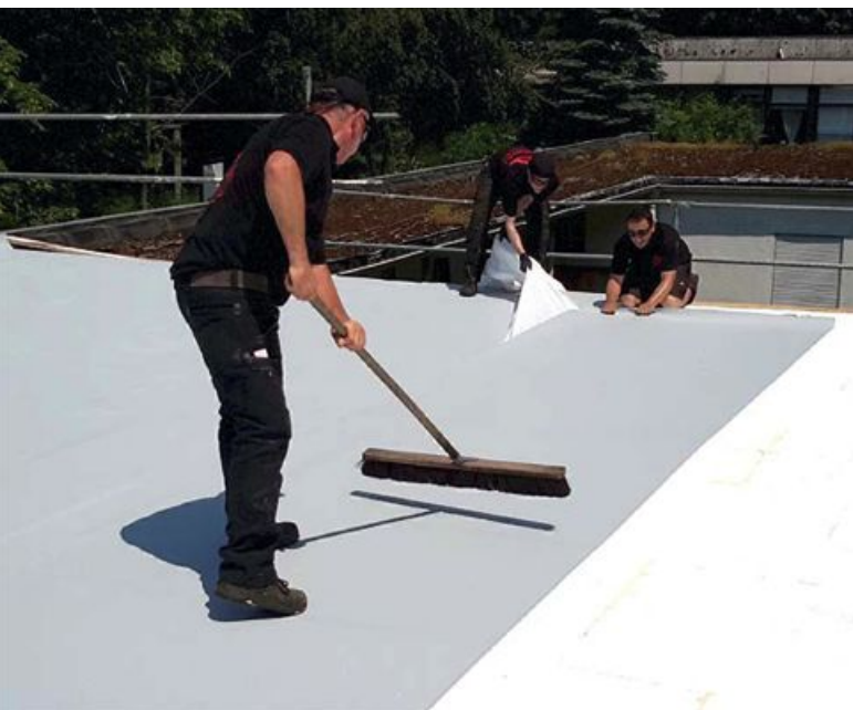
Die selbstklebende Abdichtungsbahn soll hoch temperatur- und witterungsbeständig, ozon- und UV-stabil sein.
