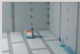
1 | Tiefgrund im angrenzenden Wandbereich ...
