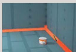
5 | Dichtband direkt nach dem Eindrücken mit Flüssigfolie überstreichen.
