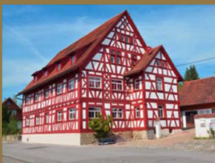
Foto: Holzbau Schmäh
