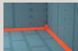
4 | In die feuchte Flüssigfolie Dichtband eindrücken.
