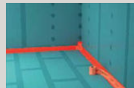
4 | In die feuchte Flüssigfolie Dichtband eindrücken.
