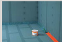
3 | Flüssigfolie in den Ecken auftragen.
