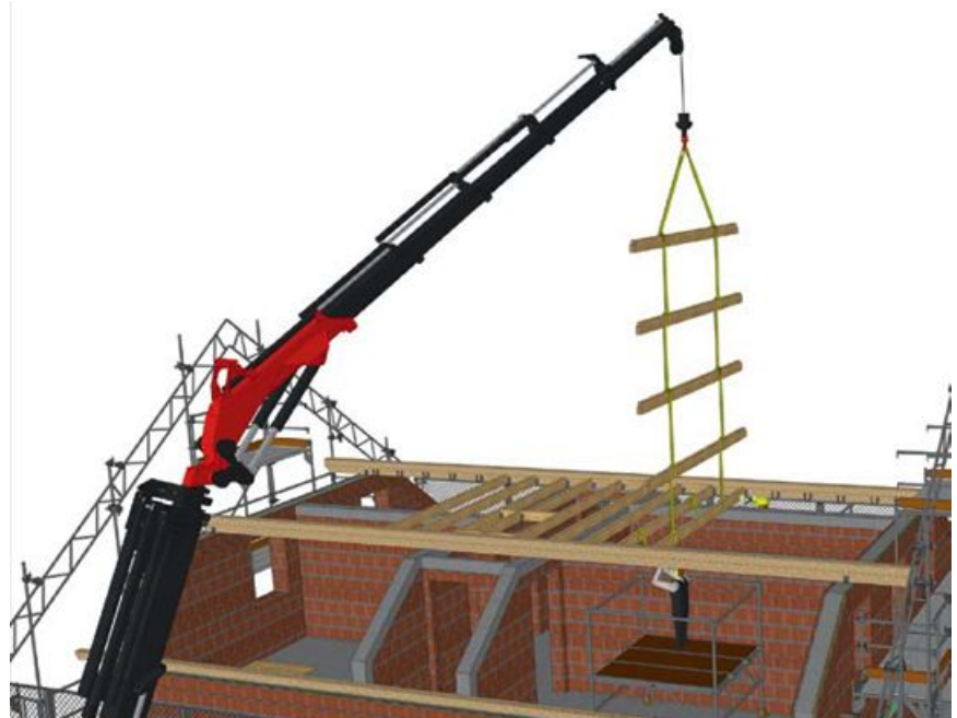
3 | Die Vermeidung großer Kranverfahrwege bei der Einzelmontage der als Serie angeschlagenen Kahlbalken spart Zeit. Die unkonventionelle Anschlagart kann schon im Betrieb vorbereitet werden.
