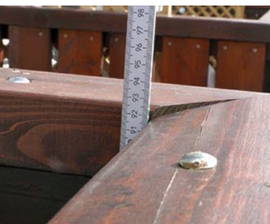
Hier wurde eine für die Gebrauchsklasse richtige Holzart verwendet, aber leider der unpassende Einschnitt. Der Balkonhandlauf, der aus dem Kernquerschnitt der Lärche gefertigt wurde, weist Radialrisse auf der Oberseite und eine starke Verdrehung auf. Wenn für den Handlauf herzförmig eingeschnittenes Holz verwendet worden wäre, wären deutlich weniger Risse und Verkrümmungen aufgetreten.
