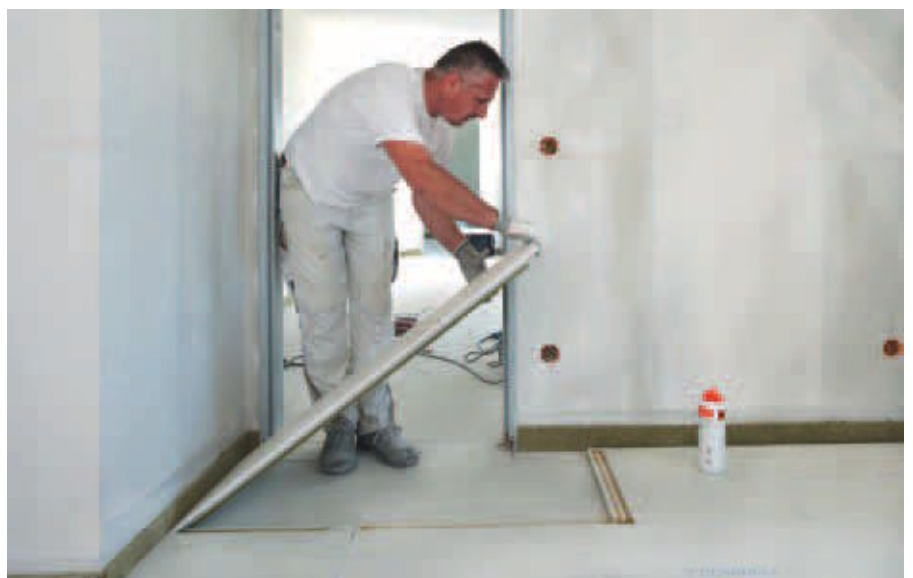
Die Verlegung der Estrichelemente erfolgt ohne Kreuzfugen im schleppenden Verband. Bevor das nächste Element verlegt wird, wird Estrichkleber auf den Stufenfalz aufgetragen.
