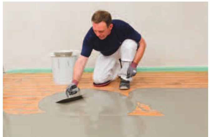
Die neue und faserverstärkte Bodenspachtelmasse auf Gipsbasis ist auf Holz- und kritischen Untergründen in Schichtdicken von 3 bis 10 mm einsetzbar.
