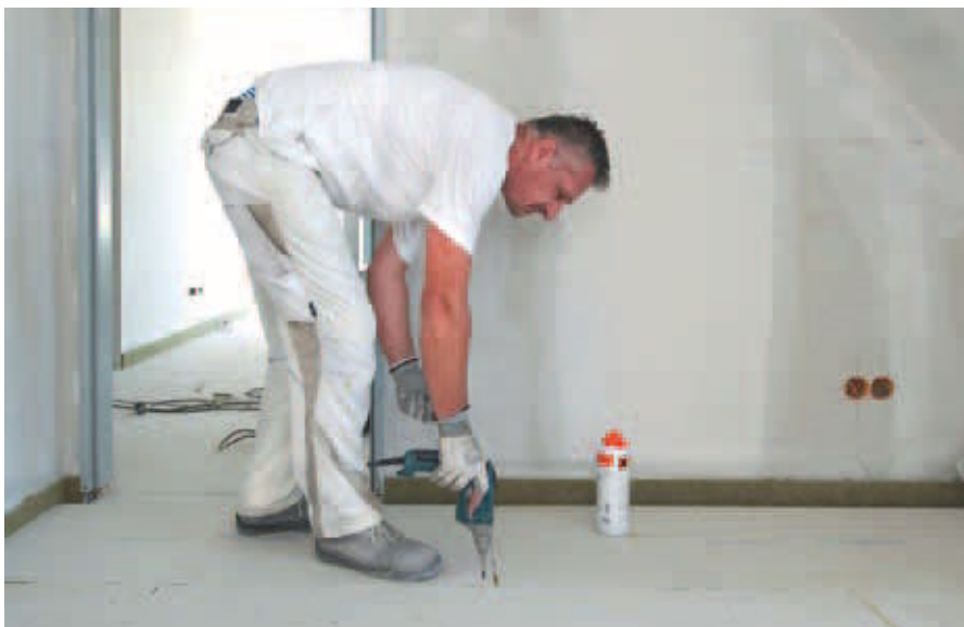
Anschließend werden die Elemente mit Schnellbauschrauben innerhalb von zehn Minuten im Bereich des Stufenfalzes verbunden, um die Klebkraft durch Anpressdruck zu erreichen.
