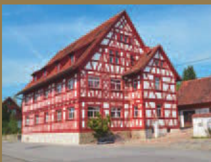
Foto: Holzbau Schmäh
