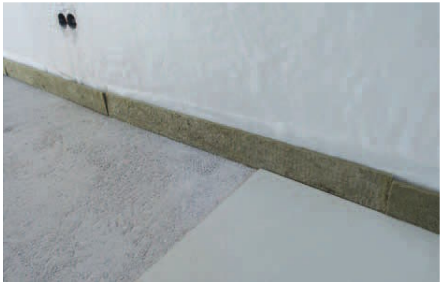
Um die Trittschallübertragung über Nebenwege zu minimieren, ist immer ein Randdämmstreifen anzubringen.
