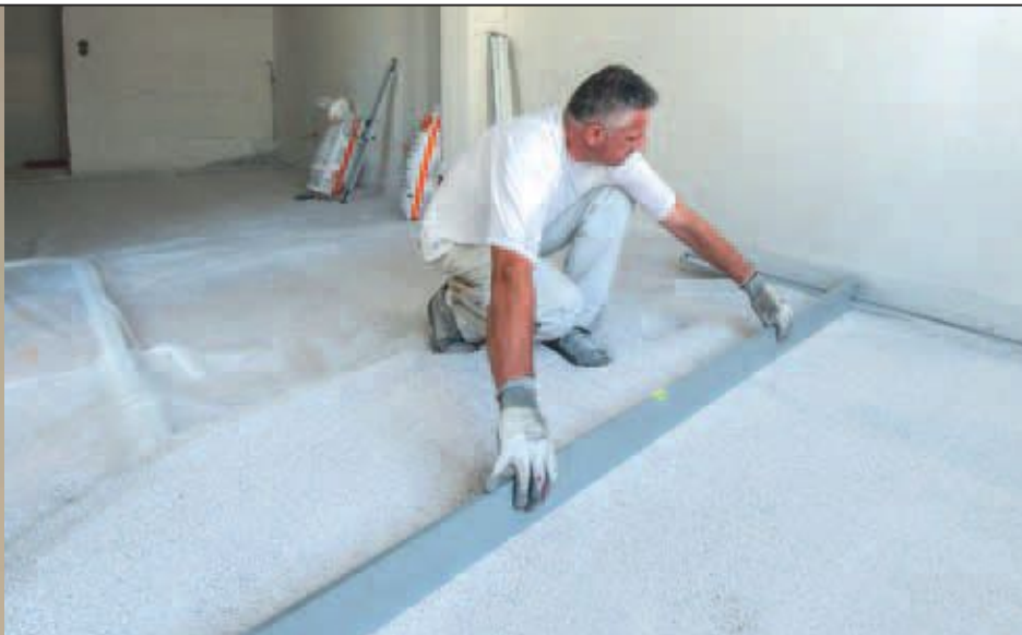
Trockenschüttungen werden vorrangig zur Nivellierung der Rohdecke eingesetzt. Vor dem Aufbringen auf Holzbalkendecken sollte eine Folie als Rieselschutz verlegt werden.
