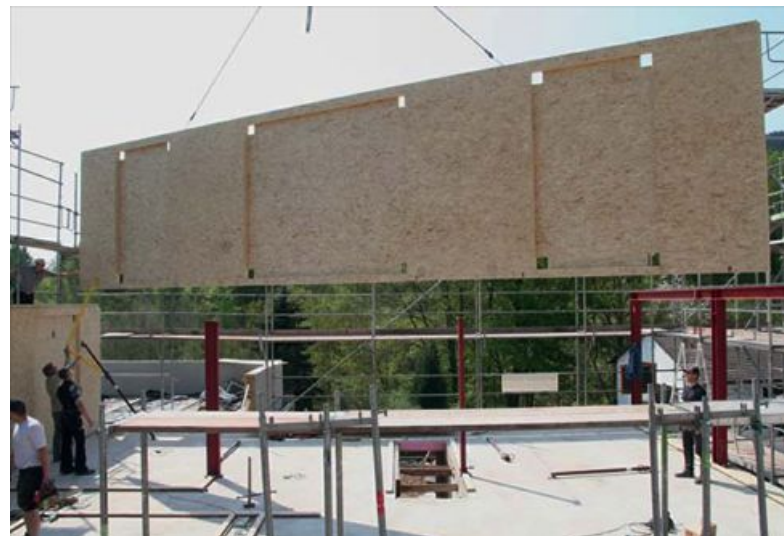
Die vorgefertigten Elemente sollen sich durch eine fugenlose, geschliffene OSB-Oberfläche, eine hohe Masse, einfache und schnelle Montage sowie ein sehr geringes Quell- und Schwindverhalten auszeichnen.
