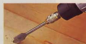
Drill a conduit opening
