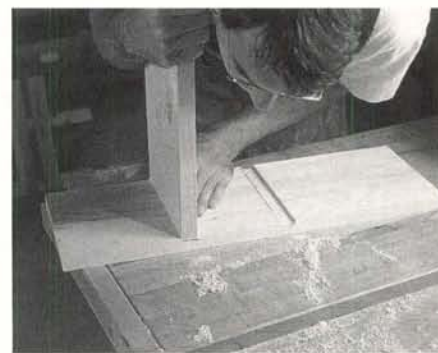
Photo D: A well-cut dado.
