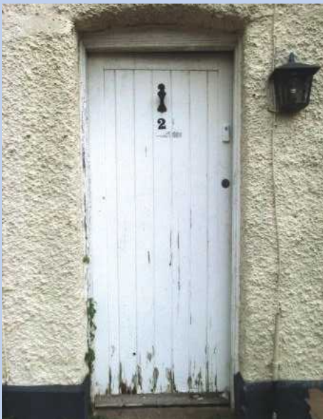
1 The original cottage door
