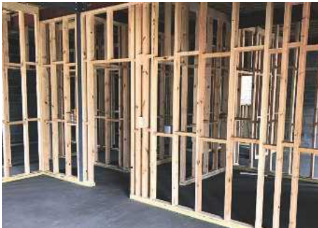
Timber stud walling
