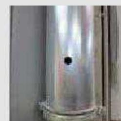
**Schritt 2:** Loch bohren
