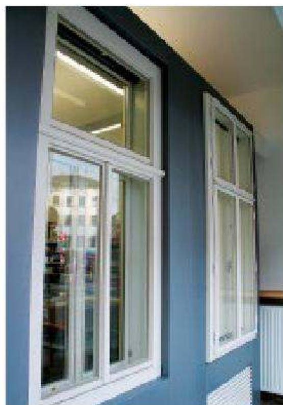
Das Standard-Kastenfenster erreicht einen Schalldämmwert von 50 Dezibel im eingebauten Zustand.
