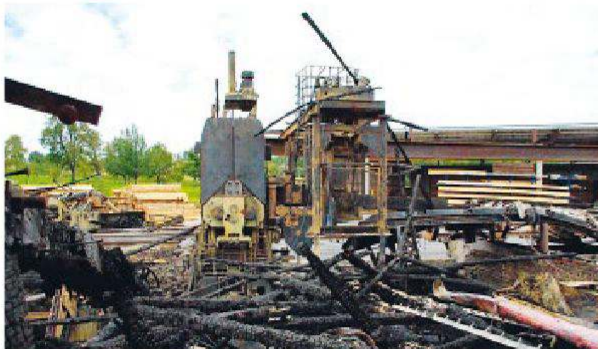
Das Sägewerk wurde durch das Feuer zur Gänze zerstört.
