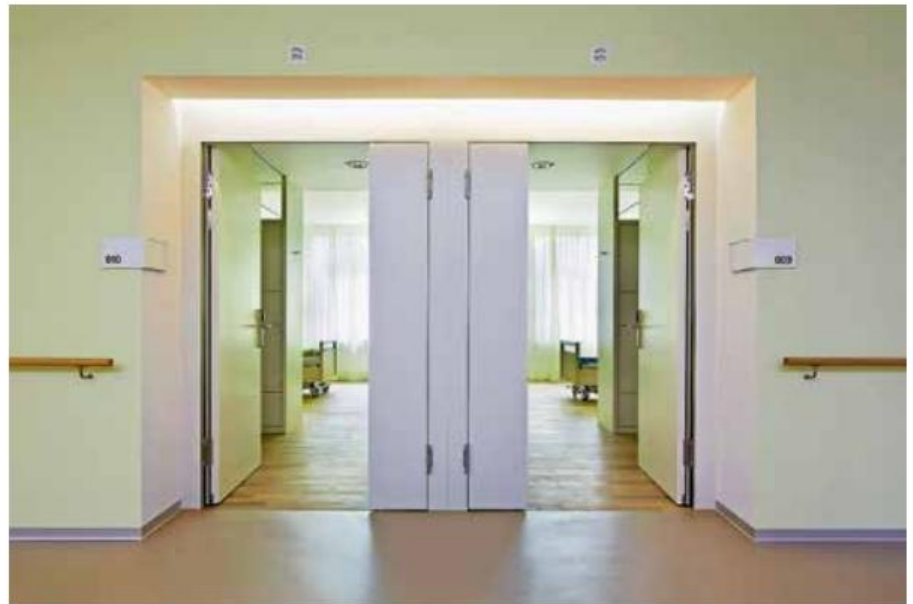
In Patientenzimmern gewährleisten schwellenlose, weit öffnende Schiebetüren den barrierefreien Zugang.
