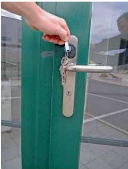
Immer mehr einbruchhemmende Türen werden mit mechatronischen Zutrittsystemen ausgerüstet. Hier (linkes Bild) öffnet ein Chip die Tür. Rechts: Zutrittsverwaltung per Smartphone. Vernetzte Systeme müssen vor Schadsoftware geschützt werden.
