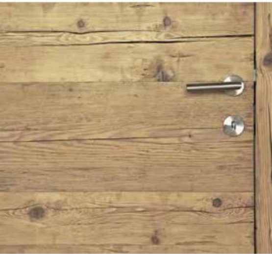
Die Altholztüren und die Strickwände wirken wie aus einem Guss.
