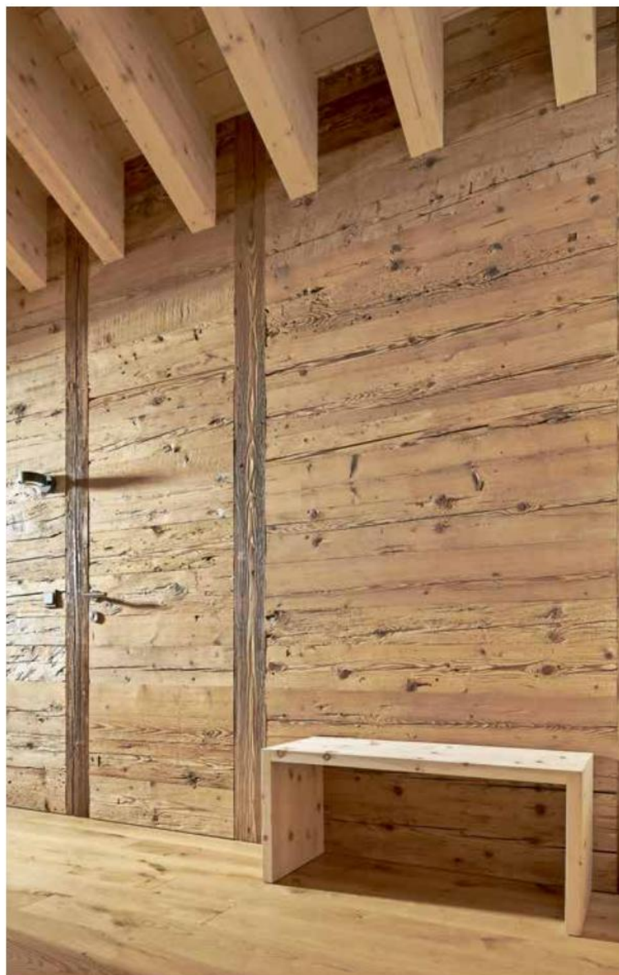
Einen besonderen Blickfang bilden die rund 200 Jahre alten, sogenannten Strickwände aus Fichtenholz, die aus alten Bauernhäusern herausgelöst wurden.
