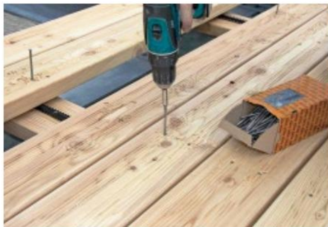
Für den Terrassenbau verwendeten die Handwerker drei verschiedene Schraubenarten aus Edelstahl.
