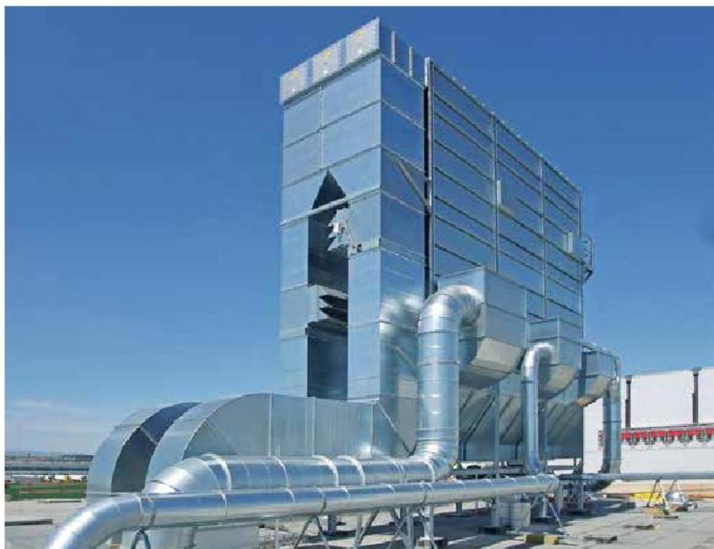
MultiStar-Filteranlage für kontinuierlichen Betrieb. Die Abreinigung erfolgt über Niederdruck-Spülluftventilatoren, die Filterentleerung über eine Förderschnecke.
