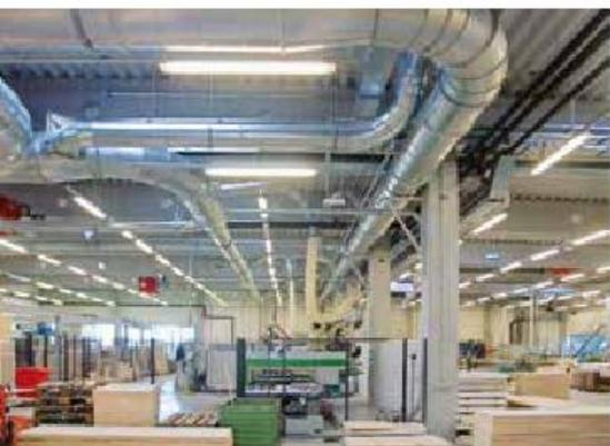
Ein Blick in die Produktion: Eine doppelte Absauglinie führt zu jeder Maschine.
