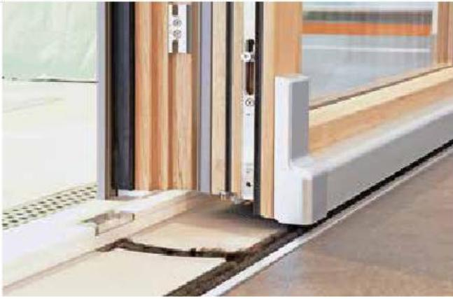
PSK mit Holzprofil für barrierefreien Durchgang
