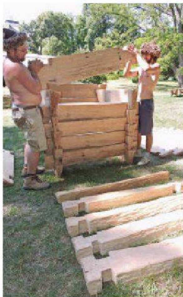
Der Brunnenkasten misst etwa 140 mal 140 Zentimetern und wurde bis zu einer Höhe von 2,4 Metern mit authentischen Methoden nachgebaut.
