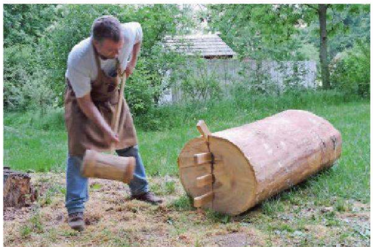
„Wie damals“ spaltet Wolfgang Lobisser den Eichenstamm mit einem Setzkeil aus Stein
