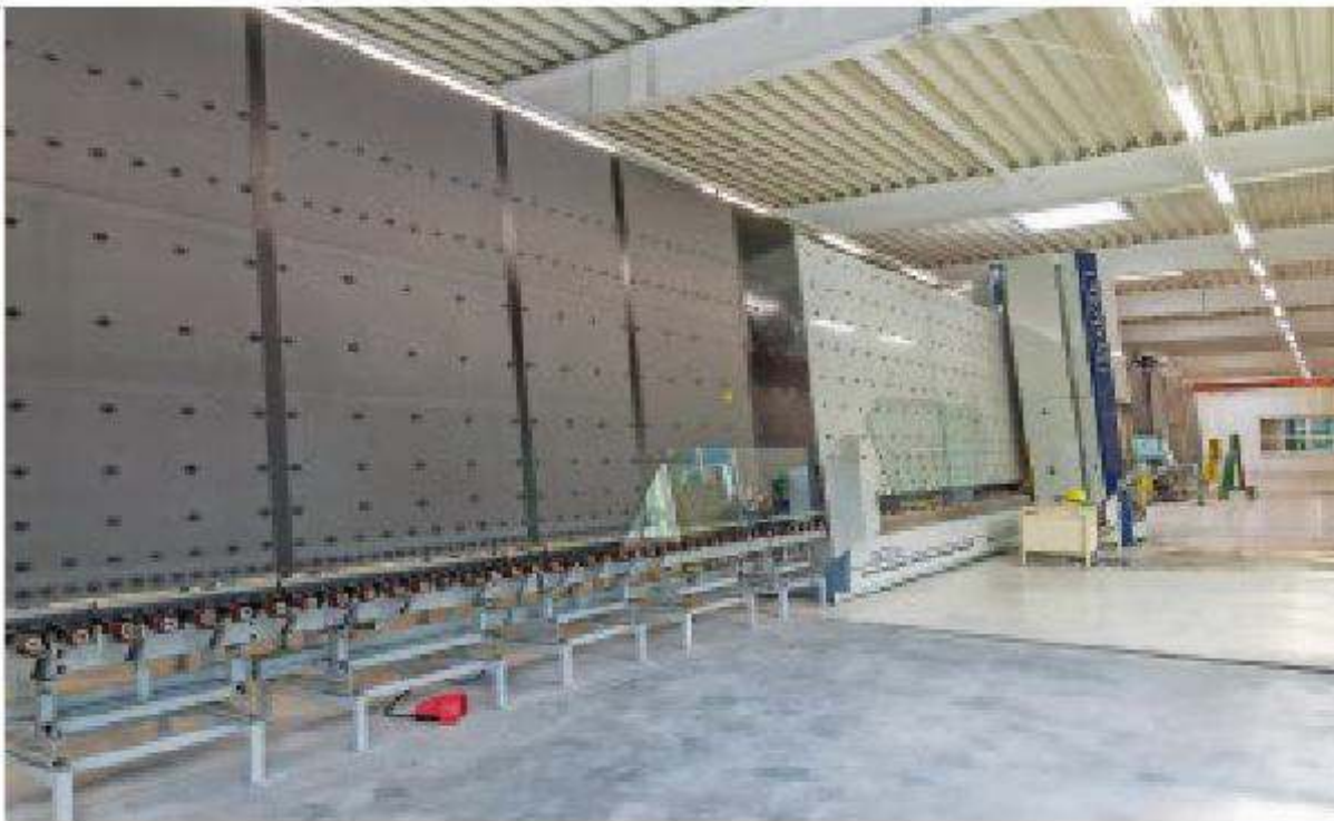
Um die Scheiben „in Form“ zu bringen durchlaufen sie ein vertikales Bearbeitungszentrum. Ein Wasserstrahl bohrt rasend schnell Löcher mit sauberen Kanten ins Glas.
