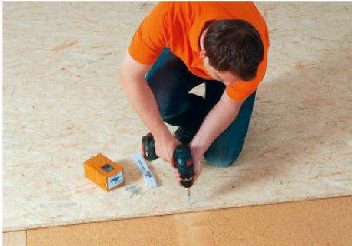
Die Heco-Unix Verlegeschraube fixiert Verlegespanplatten dauerhaft spaltfrei mit der Unterkonstruktion.
