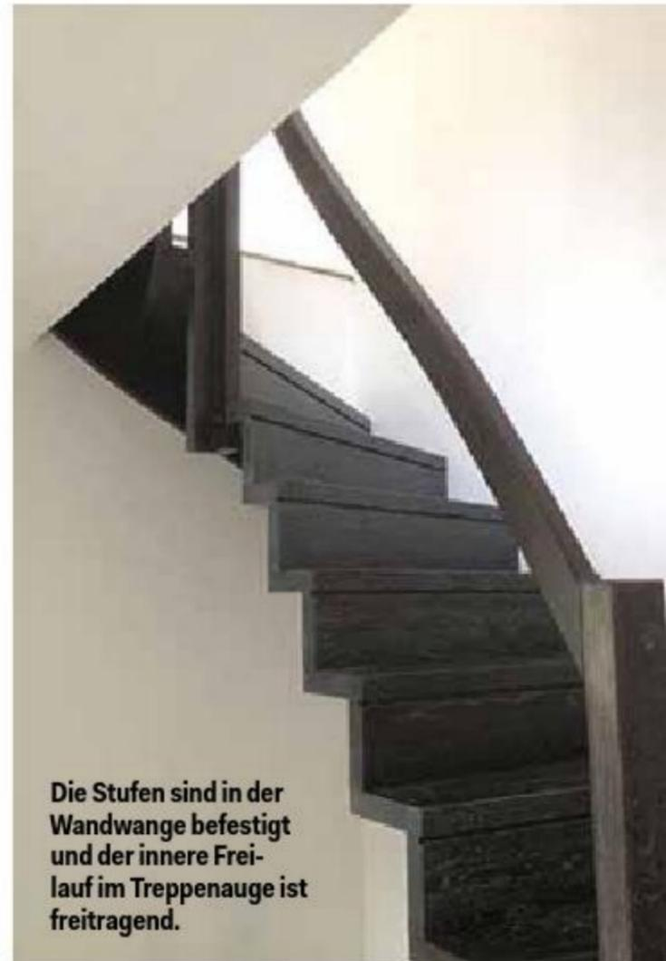
Die Stufen sind in der Wandwange befestigt und der innere Freilauf im Treppenaug ist freitragend.
