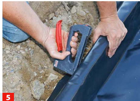
5 Auf der Außenseite des Rahmens wird die Folie dann relativ straff festgetackert.
