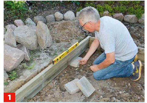
1 Den Rahmen mit Keilen, Steinen o. Ä. an den Seiten und Enden in die Waagerechte bringen.
