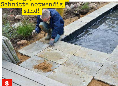
8 ... werden mehr Platten verlegt, sodass man bequem zum Mini-Pool gelangt. Platten festklopfen und Fugensand diagonal einkehren.
