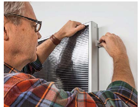
MONTAGE: Spezielle Halteklammern sorgen für einen Abstand des Kollektors zur Wand.
