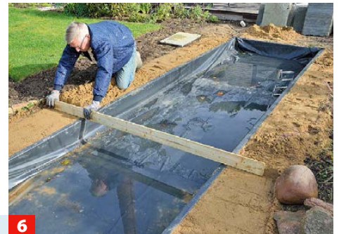
6 Nun rund um das Becken bis auf das Niveau der Umrandung weiteren Kies/Sand aufschütten, glatt abziehen und verfestigen.
