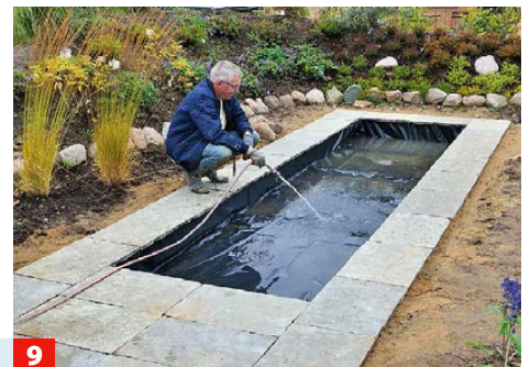
9 Wenn das Becken fertig ist, kann es befüllt werden. Das dürfte bei diesen Maßen ca. anderthalb bis zwei Stunden dauern.
