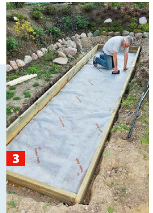
1 Den Rahmen mit Keilen, Steinen o. Ä. an den Seiten und Enden in die Waagerechte bringen.
