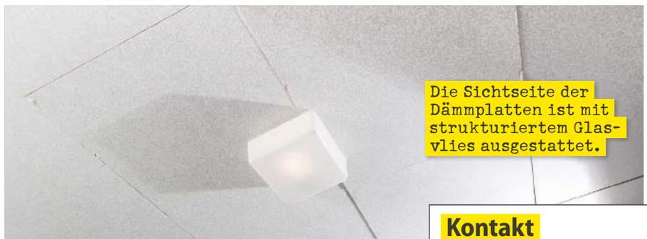
Die Sichtseite der Dämmplatten ist mit strukturiertem Glasvlies ausgestattet.
