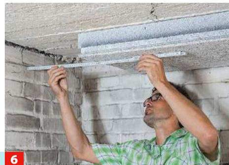
Nach der vorletzten montierten Platte messen Sie den Restabstand bis zur Wand aus und übertragen ihn auf eine Platte.
