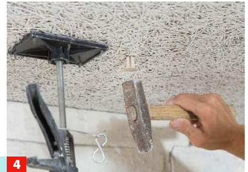
Für unsere 100 mm dicken Platten werden 140-mm-Dübel gesetzt, die Sie mit dem Hammer bündig zur Oberfläche einschlagen.
