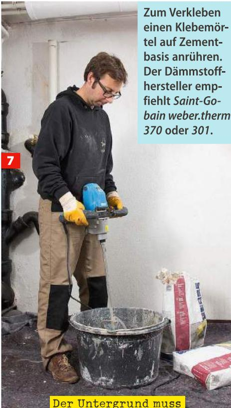
Zum Verkleben einen Klebemörtel auf Zementbasis anrühren. Der Dämmstoffhersteller empfiehlt *Saint-Gobain weber.therm 370* oder *301*.
