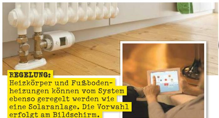
**REGELUNG:** Heizkörper und Fußbodenheizungen können vom System ebenso geregelt werden wie eine Solaranlage. Die Vorwahl erfolgt am Bildschirm.
