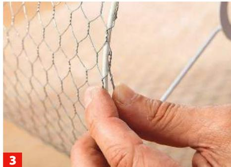
**3** Nun biegen Sie das Drahtgeflecht komplett um den äußeren Drahtring.
