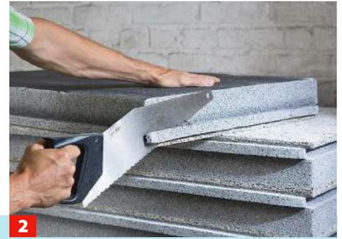
Für die erste Reihe die zur Wand zeigenden Polystyrolfedern absägen, bei der ersten Platte also an einer Längs- und einer Stirnseite.
