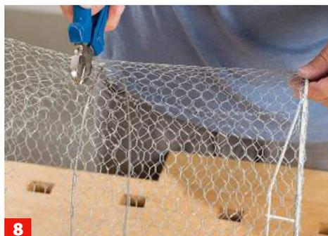
**8** Etwa einen Zentimeter unterhalb des Rings muss das Geflecht erneut aufgetrennt und das Reststück entfernt werden.
