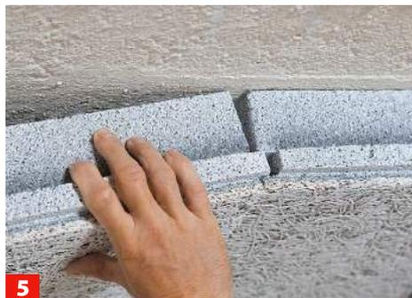
Die nächste Platte mit wandseits abgetrennter Feder an die montierte Platte heransetzen – Nut und Feder greifen ineinander.
