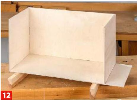
**12** Der Boden, die Rückwand und zwei Seiten – die Grundkonstruktion der Modellbauwerkstatt steht. Anschließend wird die ...
