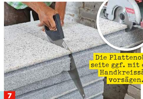
Die Plattenoberseite ggf. mit einer Handkreissäge vorsägen.
