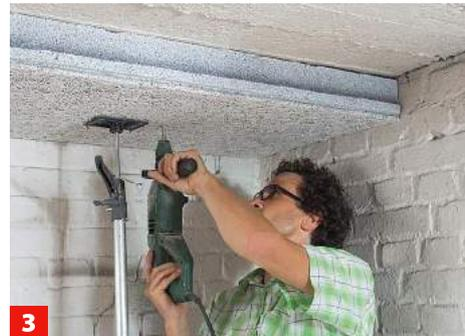
Setzen Sie einen Dübel pro Platte. Dazu mittig durch die Platte bis in die Decke bohren, Verankerungstiefe plus 5 mm.
