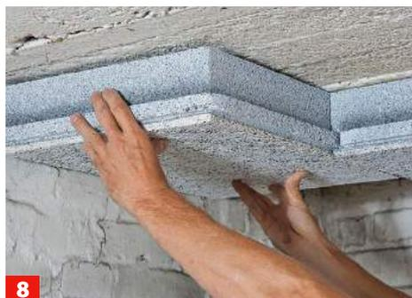
Federseiten wandseits abtrennen und die Platte in die Lücke hineinschieben. Längsseiten müssen in einer Flucht verlaufen!
