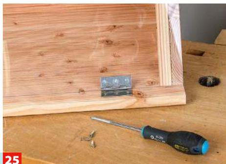
**25** Deckel erneut auflegen und die Scharniere auch an der Rückwand festschrauben. Fast fertig – aber da gibt es noch zwei Haken!
