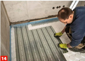
14 ... einfach in der nächsten Reihe einsetzen, so bleibt kein Verschnitt übrig. Verlegen Sie die Bleche nahezu vollflächig im Raum, ...
