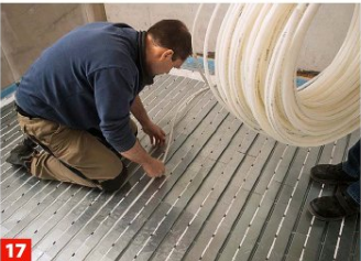
17 ... Rohr schieben und mit Mutter am Verteiler verschrauben. Das Rohr sauber von der Rolle ziehen und in die Aussparungen ...
