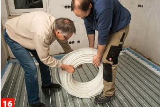
16 Ein Ende am Vor- oder Rücklauf befestigen. Dazu Rohr ablängen, Überwurfmutter und Klemmring überstülpen, Stützkörper ins ...
