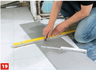
19 Muss am Ende der Reihe erneut ein Element gekürzt werden, markieren Sie die Schnittlinie rückseitig und sägen Sie es von der ...
