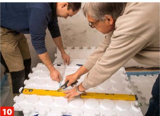
10 Der Zugschnitt erfolgt erneut problemlos mit Cutter. Halten Sie aber ein Schneidelineal, eine Latte oder eine Wasserwaage bereit.
