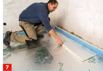
7 Um die Dämmung zu verbessern, legt man eine zweite Lage versetzt darüber (je nach Druckfestigkeit maximal 120 mm gesamt 2b ).
