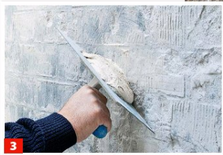
3 Nach etwa 24 Stunden Trocknungszeit kann verputzt werden.
