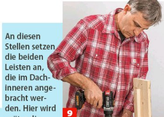
9 An diesen Stellen setzen die beiden Leisten an, die im Dachinneren angebracht werden. Hier wird später die Giebelverkleidung verschraubt.
