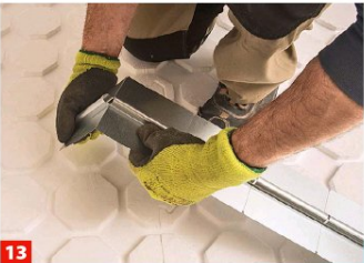
13 Alle 100 mm verfügen die Wärmeleitbleche über Sollbruchstellen, sodass man sie werkzeuglos ablängen kann. Das Reststück ...
