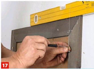
17 Tipp: Hängen Sie das Bild zunächst falsch herum auf und stellen die Seillängen bequem ein. Erst danach umdrehen.
