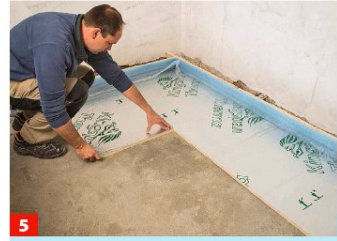
5 Beginnen Sie mit dem Reststück von vorne die nächste Reihe, so haben Sie automatisch etwas Versatz, der die Fläche stabilisiert.
