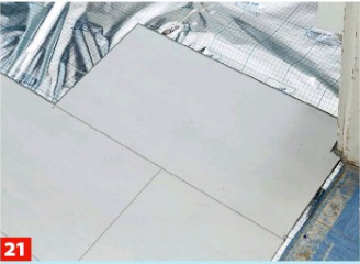
21 ... ein Elementerversatz von mindestens 40 cm bestehen! Idealerweise beginnt man mit dem Reststück die folgende Reihe.
