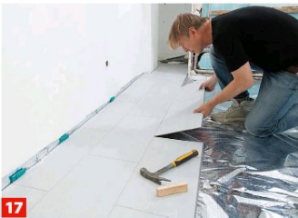
17 Das zweite Element dicht an Stirn- und Längsseite der beiden liegenden Elemente heranlegen und dann einschnenken.
