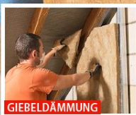
GIEBELDÄMMUNG
