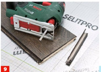
9 Vor allem bei schmalen Sockelleisten wandseits die Feder der ersten Diele abtrennen. Man fängt dann normalerweise in einer ...
