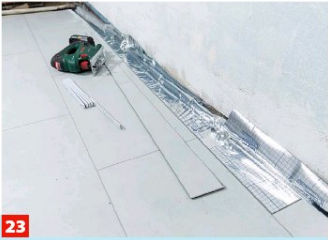
23 Je nach Wandverlauf lassen sich schmale Zuschnitte nicht verhindern, ggf. verleimen Sie zu schmale Abschnitte an Nut und Feder.
