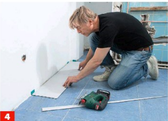
4 Berücksichtigen Sie einen Randabstand zur Wand von rund 10 mm – Kunststoff- oder Holzkeile helfen.
