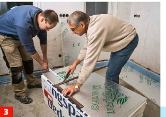
3 ... Stärke an, hier sehr gut dämmender PUR der WLS 024 1 . Diese aluminiumkaschierten Hartschaumplatten lassen sich mit Cutter ...
