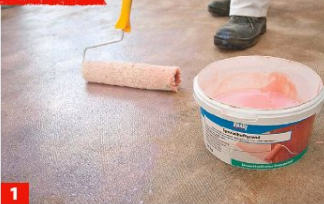
1 Möchte man einen Estrich mit Ausgleichsmasse glätten, muss man grundieren: Sehr stark sowie sehr schwach saugende ...
