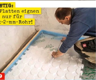
9 Legen Sie die Platten bündig an den Randdämmstreifen und lassen dessen Folie überlappen. Restabstand in Reihe 1 ausmessen.
