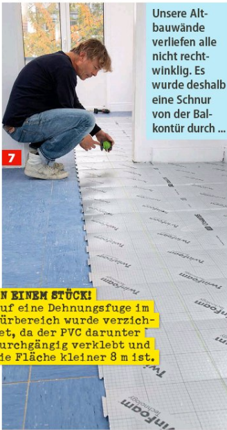
6 Platten in gleicher Ausrichtung wie den Boden auslegen (Längskante parallel zum Lichteinfall und zur Längsseite des Raumes).
