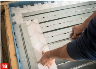
18 ... drücken. An den Umlenkpunkten ist der Biegeradius werkzeuglos möglich. Endstück dann ablängen und am Verteiler montieren.
