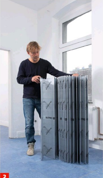
2 Die Unebenheiten des Untergrunds sollten max. 3 mm auf 1 m Länge betragen; die 2,2-mm-Schallunterlage gleicht bis zu 1 mm aus.
