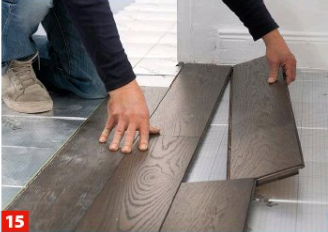
15 Das Reststück sollte nicht kürzer als 15 cm sein und die Dielen sollten reihenweise um mindestens 40 cm verspringen.
