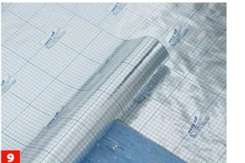
9 Die Stöße der Bahnen etwa 5 cm überlappen lassen. Wandseits die Folie rund 3 cm aufstellen und so quasi eine Wanne bilden.
