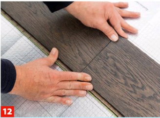
12 ... schräg ineinanderhebeln. Mit einem „Klick“ rasten sie ein. Beachten Sie, dass die Dielen in einer Flucht verlaufen! 1)
