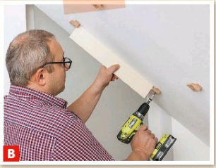
B Die vier Gegenstücke werden im richtigen Abstand zueinander an die Schräge geschraubt. Eine Distanzleiste hilft bei ...
