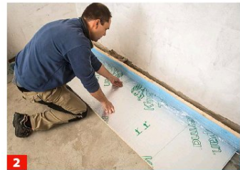
2 Im Erdgeschoss zum unbeheizten Keller hin ist eine Zusatzdämmung zuunterst sinnvoll. Selfio bietet Dämmplatten in 20 bis 50 mm ...
