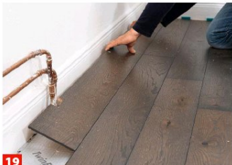
19 ... bedacht und die Dielen entsprechend ausgeschnitten werden. Berücksichtigen Sie 10 bis 15 mm Dehnungsfuge (siehe links)!
