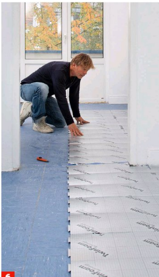
6 Platten in gleicher Ausrichtung wie den Boden auslegen (Längskante parallel zum Lichteinfall und zur Längsseite des Raumes).
