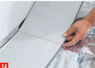
12 Die Stirnseiten einfach schräg ineinanderhebeln. Dabei darauf achten, dass die Längsseiten in einer Flucht verlaufen.
