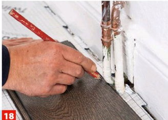
18 ... nicht an der Wand links begonnen haben, da diese Zuschnitte dann nicht so genau möglich gewesen wären. Auch Rohre müssen ...
