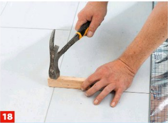
18 Die Stirnseiten kräftig herunterdrücken bzw. mit Hammer und Schlagklotz zusammenfügen.
