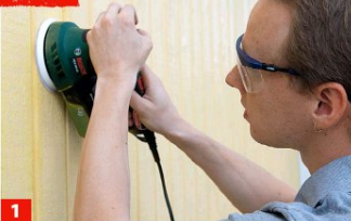
1 Alte Lackschichten gründlich anschleifen. Nutbereiche kann man mit sogenanntem Schleifroller auch elektrisch bearbeiten.
