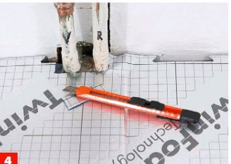
4 ... der Bahnen verhindern. Zu- und Ausschnitte können einfach per Cutter erfolgen; die Rasterung hilft bei geraden Schnitten.
