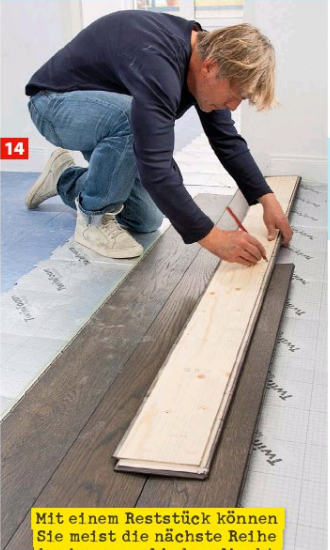
14 Mit einem Reststück können Sie meist die nächste Reihe beginnen und haben direkt einen Versatz.
