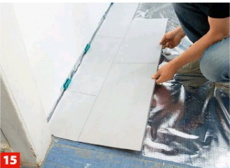
15 Reihe zwei wird hier mit ganzem Element begonnen (Steindekore verfügen über eine Fuge pro Element); hebeln Sie es schräg ein.
