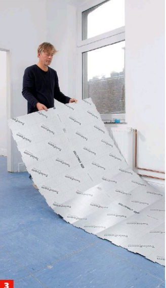
3 Die Unterlage auseinanderfalten und bahnenweise auslegen. Die seitliche Kontur greift ineinander und soll damit ein Verrutschen ...
