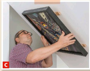
C ... der Positionierung. Das Bild kann anschließend einfach von oben über die Leistenabschnitte geschoben werden.
