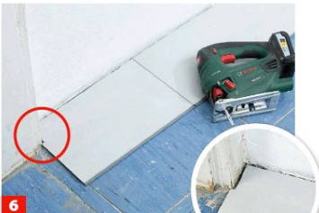
6 An Türzargen sind entsprechende Ausschnitte fällig. Auch hierbei 10 mm Dehnungsfuge beachten.
