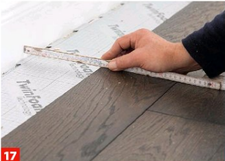
17 Durch die schräge Wand musste der Restabstand für den Zuschnitt der Dielen rund alle 10 cm ausgemessen werden; weshalb wir ...
