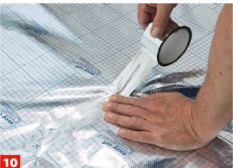
10 Überlappungen und Wandanschlüsse mit Aludichtband dampfdicht abkleben.
