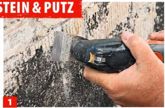
1 Poröse, lose Materialreste entfernen und Wand gründlich abgeben.
