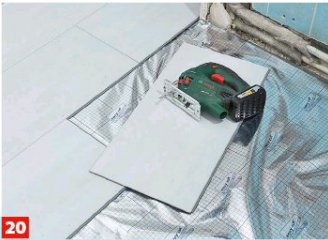
20 ... Rückseite aus durch – so vermeiden Sie ein Ausfransen auf der Vorderseite. Wenn es die Raumgröße ermöglichen, sollte stets ...
