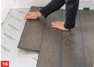
16 Schwenken Sie immer zuerst die Längsseite ein. Die Stirnseiten dann dicht aneinanderlegen und ineinander einrasten.
