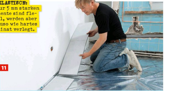
8 Die erste Reihe wieder aufnehmen; in Bädern und Küchen zunächst eine PE-Folie als Schutz gegen eindringende Feuchte auslegen.
