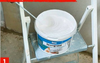
1 Dekorputze verlangen mehr als Tiefengrund: Knauf empfiehlt unter Easyputz einen Sperrgrund, der für Haftung und ...
