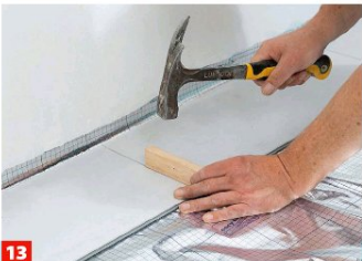
13 Eventuell ist zum Einrasten ein Schlagklotz nötig. Legen Sie ihn wie abgebildet quer auf einem Element ab und klopfen dann fest.
