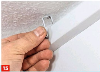
15 ... eine geknotete Schlaufe, die nach dem Aufstecken des Aluhakens eingehängt wird. Ein Durchmesser von 2 mm reicht in der ...
