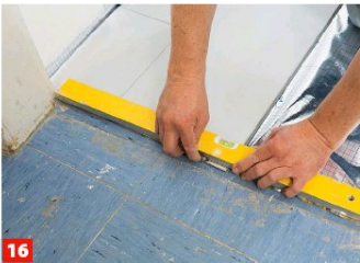
16 Im Türbereich müssen je nach Wandverlauf auch an den Stirnseiten Zuschnitte erfolgen.
