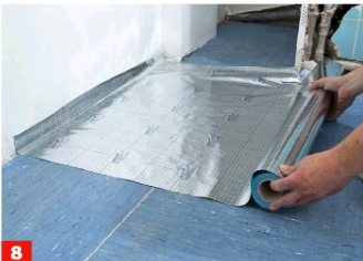
8 Die erste Reihe wieder aufnehmen; in Bädern und Küchen zunächst eine PE-Folie als Schutz gegen eindringende Feuchte auslegen.
