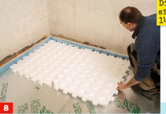
8 Auf die Dämmschicht folgen nun die EPS-Systemplatten für Trockenestrich, in die das Heizrohr gesteckt werden kann.
