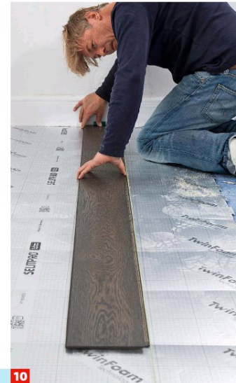
10 ... linken Raumecke an. Durch die verwinkelte Situation begann man die Verlegung hier in Raummitte entlang der Fluchtschnur.
