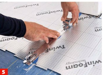
5 Die Stoßbereiche der Platten mit Aludichtband abkleben. Für Feuchteschutz empfiehlt der Hersteller, auch wandseits abzukleben. 1)
