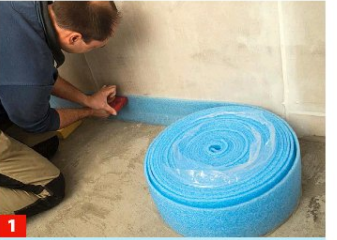
1 Umlaufend an der Wand einen Randdämmstreifen befestigen. Hier wird getackert, es gibt aber auch selbstklebende Streifen.
