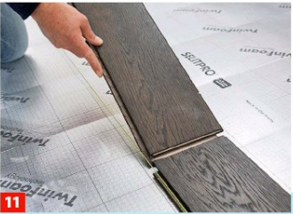
11 Die Federseite muss zur Wand zeigen, hier in Richtung der kürzeren Seite zur Wand. An den Stirnseiten die Dielen einfach ...
