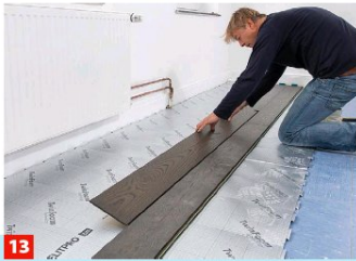
13 Im weiteren Verlauf werden in unserem Fall die Dielen zunächst rückwärts verlegt, man schwänkt sie mit der Nut- in die Federseite. 2)
