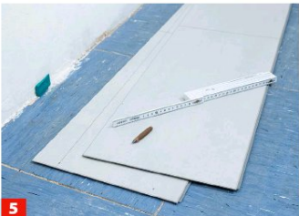
5 Auch die weiteren Elemente der ersten Reihe längsseitig so kürzen, dass sie fluchtgerecht zur gewählten Bezugslinie verlaufen.
