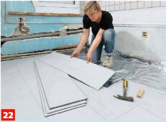
22 Um eine natürliche Farbvielfalt zu erzielen, mischen Sie beim Verlegen immer Elemente aus verschiedenen Paketen!
