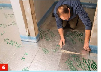
6 Verlegen Sie die Dämmung (und später den Trockenestrich) flächig auch durch Türdurchgänge, Bewegungsfugen sind nicht nötig. 2a
