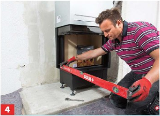
4 Bevor der Ofenbauer mit der Ummauerung beginnt, wird die Ausrichtung nochmals kontrolliert.
