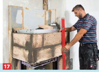
20 ... in feuerfesten Mörtel gesetzt und im Ver-band ohne Kreuzfugen gemauert. Die Mau-erflucht wird mit Wasserwaage kontrolliert.
