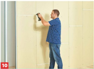
10 Die weiteren Platten mit einem Stirnkantenversatz von mindestens 40 cm und ohne Fugenabstand auf Stoß aneinandersetzen.
