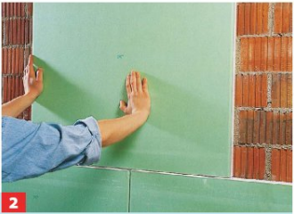
2 Die Platten im Versatz auf Stoß an die Wand kleben; zum Boden 10 mm, zur Decke 5 mm Fuge vorsehen. Fugen wie üblich verspachteln.
