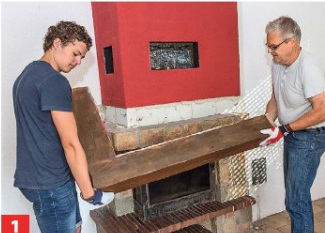
1 Erst eventuelle Holzablagen demontieren. Holz muss auch separat vom Bauschutt entsorgt werden, in der Regel als Sperrmüll.
