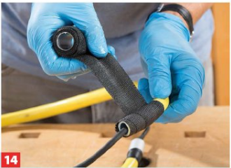
14 ... 20 Sekunden in lauwarmes Wasser tauchen. Dann ausdrücken und den Schlauch zügig vom Ende her stramm umwickeln.
