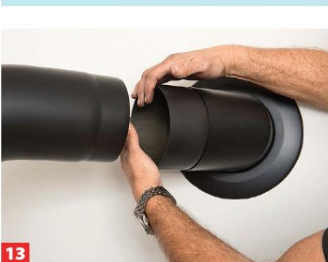
12 Nun den Kaminofen endgültig positionieren. Arbeiten Sie zu zweit! Hier handelt es sich um 129 kg, es gibt aber noch schwerere Kaminöfen. 13 Es folgt der komplette Anschluss. Der Winkelbogen aus dem Anschlussset wird in das bereits platzierte kurze Bogenstück gesteckt.
