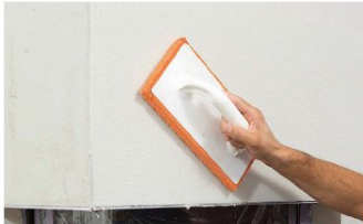
25 Hat der Putz etwas angezogen, reibt man ihn mit einem Moosgummbrett oder einem Schwammbrett flächig glatt ab.
