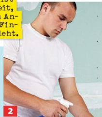
2 Den Kleber mit Wasser einsprühen. Nach 15 bis 30 Sekunden ist der Kleber einsatzbereit.
