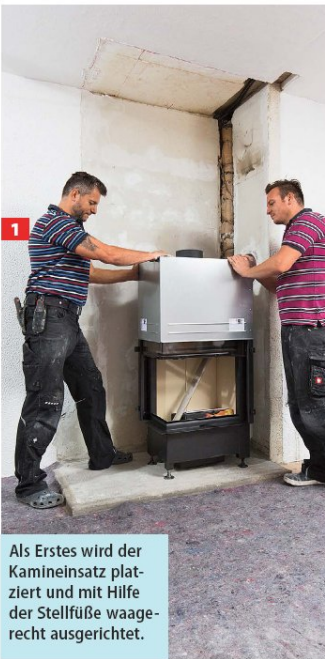
Für das neue Rauchrohr musste die alte Wandmuffe herausgestemmt werden. Später folgt noch eine neue (siehe Bild 13).
