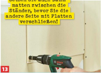
13 ... verschließen (Acryl oder Polymermasse). Eine zweite Lage Platten erhöht den Schallschutz und die Stabilität.
