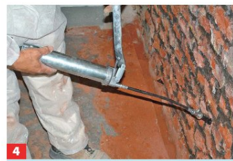
4 ... zum System gehören. Das Permagel damit einfüllen und die Löcher komplett verfüllen.
