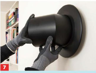
7 Ins Wandfutter steckt man das Ofenrohr, hier ein Bogenstück, über das man vorher die Rosette stülpt.
