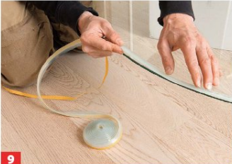
9 Damit sich kein Schmutz unter die Glasplatte schiebt, kleben Sie eine Silikondichtlippe umlaufend darunter, hier selbstklebendes ...
