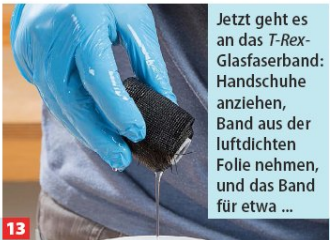
13 Jetzt geht es an das T-Rex-Glasfaserband: Handschuhe anziehen, Band aus der luftdichten Folie nehmen, und das Band für etwa ...
