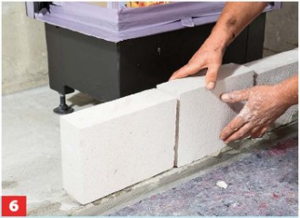
6 Die Steine werden zuunterst in Normalmör-tel gesetzt und fluchtgerecht ausgerichtet. Auch an den Stirnseiten wird vermörtelt.
