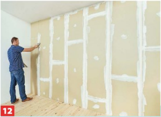
12 ... und darüber Fugendeckstreifen in den Spachtel einarbeiten. Anschlussfugen an Wand/Decke mit elastischer Dichtmasse ...
