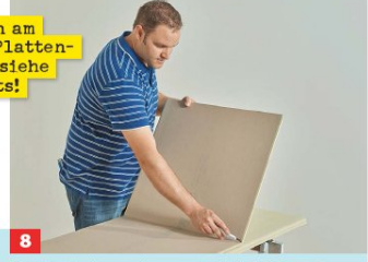
8 Die Platte kann dann wie üblich über eine Kante hinweg durchgebrochen werden; rückseltigen Karton mit Cutter durchtrennen.
