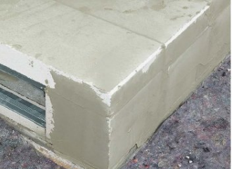
14 Der untere Bereich bis zum Feuerraum lässt sich gut mit Porenbeton mauern, hier zuge-schnittene Planbauplatten.
