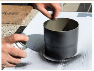
Zum Lackieren hitzebeständigen Lack verwenden, z.B. als Ofenlack(spray) bezeichnet.
