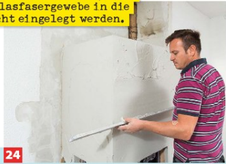
24 Ist der Putz mit einer Kelle aufgezogen, wird er mit einer Kartätsche/Abziehleiste glatt abgezogen.
