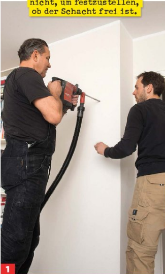
1 Weiß man nicht genau, ob Abgasrohre im Schornsteinschacht verlaufen, macht man eine Probebohrung. Gleichzeitig schaut ...
