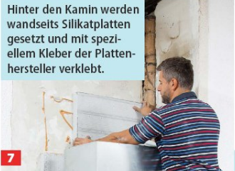
7 Hinter den Kamin werden wandseits Silikatplatten gesetzt und mit spezi-ellem Kleber der Platten-hersteller verklebt.
