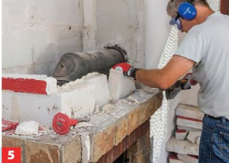
5 Beseitigen Sie zunächst die komplette Ummauerung bis zum Rauchrohranschluss.
