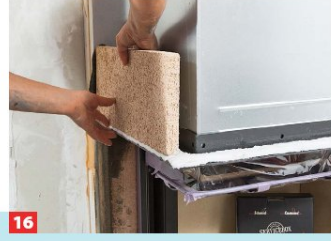
19 Die Schamotteplatten liegen so satt auf und Schallbrücken werden unterbunden. Die Platten werden an Stoß- und Lagerfugen ...
