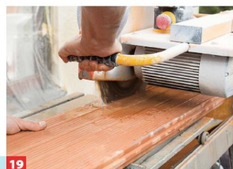
22 ... Warmluftaustritt eingeplant. Mit einem Nassschneidegerät schneidet man die ent-sprechende Öffnung in den Ziegel hinein.
