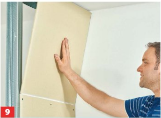
9 Die passend zugeschnittene Platte nun zur Decke hin einfügen und verschrauben. Richtung Decke etwa 5 mm Fuge vorsehen!
