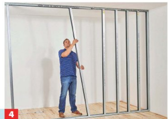
4 Ist der Profilrahmen verdübelt, folgen die CW-Ständerprofile, die man in geeignetem Achsabstand einstellt (s. linke Seite unten).
