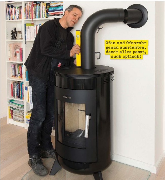
10 ... Band. Die Platte legen Sie dann exakt dorthin, wo der Ofen stehen soll. Sie muss den Ofengrundriss vorne um mindestens 50 cm ...
