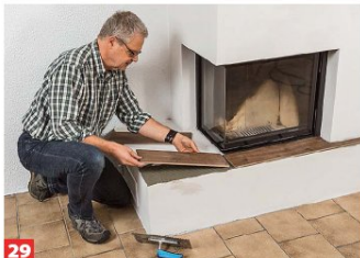
29 Fliesenkleber mit Zahnkelle aufziehen, zugeschnittene Fliesen mit etwas Fuge zum Kamineinsatz auflegen und dann verfugen.
