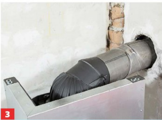
Hier zunächst ein provisorischer Anschluss zur weiteren Ausrichtung. Praktisch für den Anschluss: komplette Ofenrohrsets.
