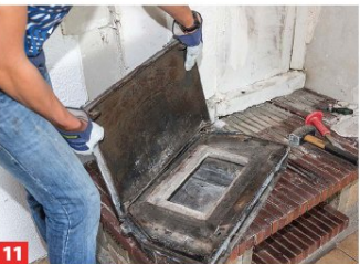
11 Metallschrott kann meist über den Sperrmüll oder auch getrennt vom Bauschutt in der Deponie entsorgt werden.
