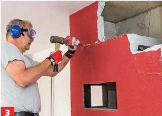
3 Beginnen Sie oben, die Ummauerung zu entfernen. Gehen Sie stückweise vor und tragen Sie beim Klopfen eine Schutzbrille.
