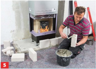
5 Der untere Bereich bis zum Feuerraum lässt sich gut mit Porenbeton mauern, hier zuge-schnittene Planbauplatten.
