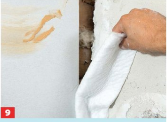
9 Sogenanntes Keramikvlies ist nicht brennbar und kann zum Ausstopfen schmaler Fugen hinterm Kamin verwendet werden. 1)
