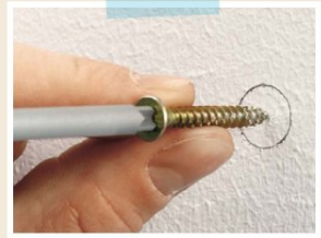
Einfach schrauben: Für die neue Wohnbauplatte Rigips Habito benötigen Sie weder Bohrmaschine noch Dübel.
