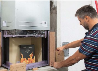
17 Dort, wo der Kamin Wärme abstrahlen kann, werden nun passende Schamotte-platten zur Ummauerung verwendet.
