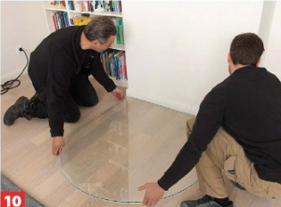
10 ... Band. Die Platte legen Sie dann exakt dorthin, wo der Ofen stehen soll. Sie muss den Ofengrundriss vorne um mindestens 50 cm ...
