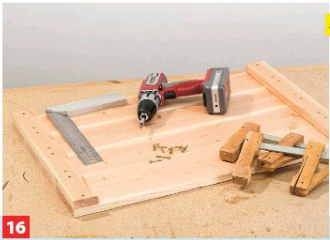
16 Zum Verschrauben die Bretter verspannen. Auf Rechtwinkligkeit prüfen!
