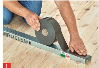
1 UW-Rahmenprofile für Boden, Wand und Decke zuschneiden und mit Dichtungsband bekleben. Entsprechend des Wandverlaufs ...
