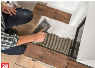
28 Abschließende Arbeiten kann der Bauherr problemlos selbst übernehmen, zum Beispiel die Fliesenverlegung auf dem Sockel.
