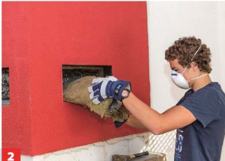
2 Tragen Sie eine Staubmaske! Mineralwolle, die vor 2001 eingebaut wurde, sollte man in Säcken luftdicht verpackt als Sondermüll entsorgen. 1)
