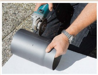
Kürzen Sie das Rohr gegenüber der Muffenseite mit einem Winkelschleifer.
