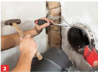
Für das neue Rauchrohr musste die alte Wandmuffe herausgestemmt werden. Später folgt noch eine neue (siehe Bild 13).
