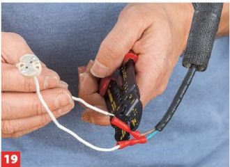
20 Die Litzen vereinzeln, an den Enden abisolieren, und die Aderenden mit Quetschverbindern (1,5 mm) fest verbinden.
