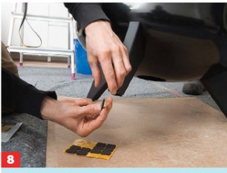
8 Der Kaminofen steht auf einer feuerfesten Glasplatte. Ggf. klebt man unter die Ofenfüße noch Filzgleiter, um das Glas zu schonen.
