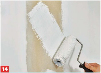
14 Die Sonicboard -Platten muss man nicht grundieren, sie können mit Knauf Trockenbaufarbe direkt gestrichen werden.
