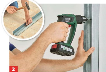
2 ... zunächst die Bodenprofile verdübeln, dann die Wandanschlussprofile sowie ...
