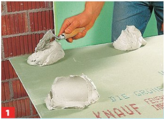
1 Zunächst die gesäuberten Wände grundieren. Dann Ansetzbinder anrühren und batzenweise auf der Plattenrückseite verteilen.
