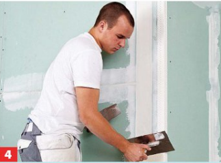
4 ... flach aufliegen und komplett die Plattenoberfläche berühren. Nach ca. 20 Minuten können Sie den Kantenbereich überspachteln.
