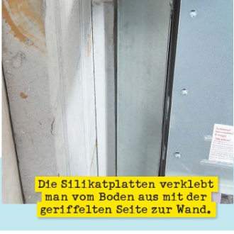
11 Die Silikatplatten verklebt man vom Boden aus mit der geriffelten Seite zur Wand.
