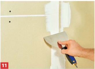
11 Fugenspachtel anrühren und Plattenübergangsfugen sowie Schraublöcher verspachteln. Geschnittene Kanten grundieren ...
