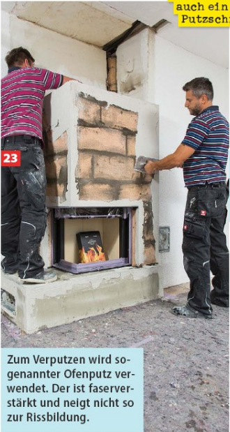
24 Ist der Putz mit einer Kelle aufgezogen, wird er mit einer Kartätsche/Abziehleiste glatt abgezogen.
