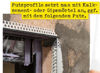
23 Putzprofile setzt man mit Kalk-zement- oder Gipsmörtel an, ggf. mit dem folgendem Putz.
