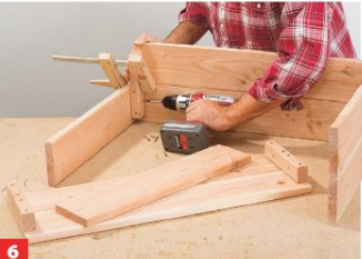
6 Die seitlichen Bretter werden nun von innen über die vorgebohrten Löcher in den Leisten mit Deckel und Boden verbunden.
