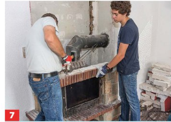
7 Es folgt das Abschlagen der Klinker rund um den Heizeinsatz. Vorsicht: Scharfkantige Materialien verlangen Arbeitshandschuhe!
