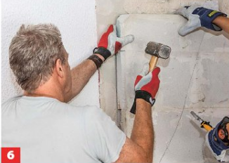
6 Auch wandseits können Steinplatten zum Ausgleich oder als Feuerschutz befestigt sein, die man vorsichtig entfernen muss.
