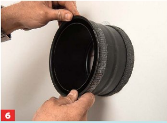
6 Die saubere Bohrung im durchgängig massiven Mauerwerk erlaubt so ein dichtes Einsetzen ohne weitere Vermörtelung.
