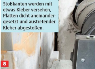
8 Stoßkanten werden mit etwas Kleber versehen, Platten dicht aneinander-gesetzt und austretender Kleber abgestoßen.
