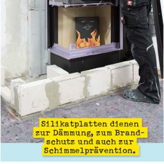
10 Silikatplatten dienen zur Dämmung, zum Brand-schutz und auch zur Schimmelprävention.
