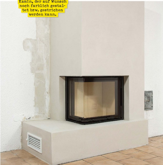
26 Direkt danach sollte das Kreppband am Kamin entfernt werden. Ist der Putz erst trocken, kann sonst etwas abplatzen.
