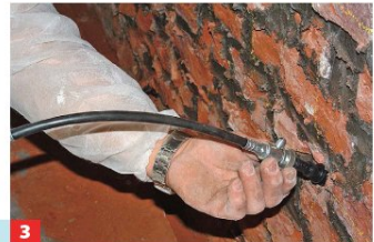
3 ... Adapter drehen, an denen dann die Pres- sen angeschlossen werden, die ebenfalls ...
