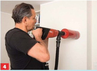
4 Mittels Kernbohrkrone bohren Sie ein Loch in den Schacht, das dem Ofenrohrdurchmesser bzw. dem Wandfutter entspricht.
