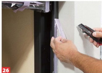
26 Direkt danach sollte das Kreppband am Kamin entfernt werden. Ist der Putz erst trocken, kann sonst etwas abplatzen.
