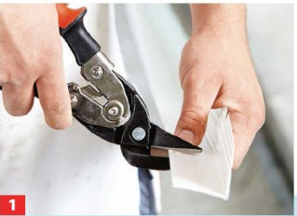
1 Den Rigips-AquaBead -Kantenschutz entsprechend der benötigten Länge (in der Regel = Deckenhöhe) zuschneiden.
