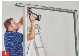
3 ... die Deckenprofile. Stellen Sie zur Abstützung schon einmal ein CW-Ständerprofil ein.
