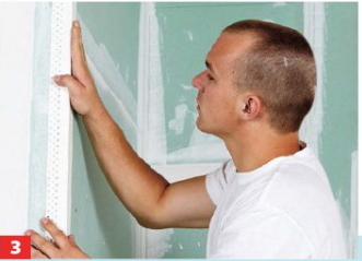
3 Setzen Sie den Kantenschutz an die Ecke der Trockenbauwand und drücken ihn fest und gleichmäßig an. Die Schenkel müssen ...
