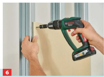
6 Die Platten etwa alle 25 cm verschrauben; zum Boden hin 10 mm Fuge vorsehen! Die Schnellbauschrauben 2) leicht versenken.
