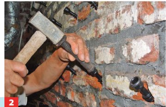
2 In die Löcher zum System gehörende Kunst- stoffpacker einschlagen. Auf die Packer ...
