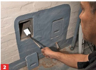
2 ... eine Person mittels Spiegel von einer Reinigungsöffnung im Keller nach oben in den Schornstein. Ist der Schacht frei, kann die ...
