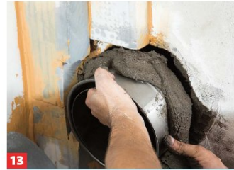
15 Nachdem die Silikatplatten an der Wand verklebt sind, folgt die neue Wandmuffe, die der Ofenbauer in feuerfesten Mörtel setzt.
