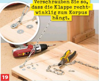
19 Verschrauben Sie so, dass die Klappe rechtwinklig zum Korpus hängt. Mit Rundkopfschrauben und Unterlegscheiben wird beidseitig eine Gliederkette angebracht. Dadurch wird die Klappe gesichert.
