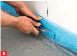
5 Grundkörper abrücken und Dämmstreifen entsprechend ausschneiden.
