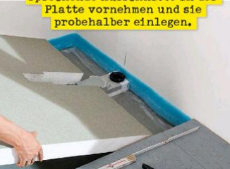
13 Stimmen die Ausschnitte und passt die Platte, flexiblen Fliesenkleber anrühren und mit Zahnkelle auf den Untergrund auftragen.
