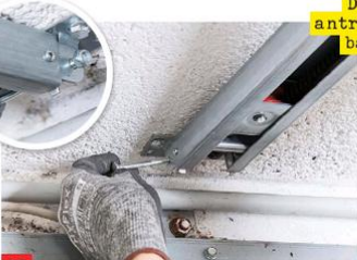
13 Schiene anheben, bis die Löcher des Befestigungsteils und der Sturzbefestigung übereinander liegen. Schraube durch die Löcher ...
