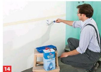
14 Dann verlegen Sie zunächst die Wandfliesen. Um die Haftung zu verbessern, grundieren Sie die Fläche.
