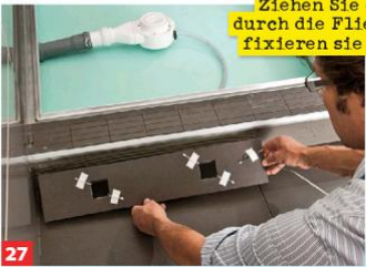
27 Tolle Sache: Steuler bietet Bodenschnittfliesen für LED-Leuchtmodule an, die bereits über exakte Ausschnitte verfügen.
