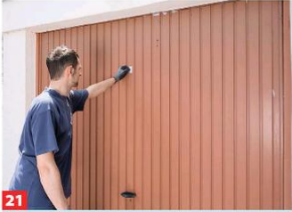
21 Den Entriegelungsgriff für die Not-Entriegelung in einer Höhe von mindestens 1,80 m mittig am Garagentor anbringen.
