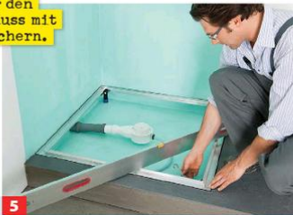
5 ... platzieren. Er verfügt über ein Drainagesystem, das durch undichte Silikonnähte eingedrungenes Sickerwasser ableitet. Es wird ... durch einen Schlauch am Kriechwasseranschluss mit dem Ablauf verbunden. Den Rahmen durch Drehen der vier Füße ausrichten.
