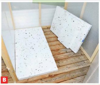
B Ausgelegte Styroporplatten (ca. 5 cm dick) verhindern, dass der Boden zu kalt wird.
