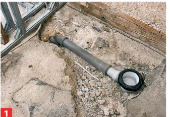
1 Für den Bodenablauf samt 50-mm-Rohr-Flutung Fallleitung den Estrich aufstemmen.
