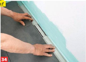
34 ... die Rinnenrückseite mit Fliesenkleber bestreichen und die Rinne einsetzen. Am Ende Wandanschluss mit Silikon abdichten.
