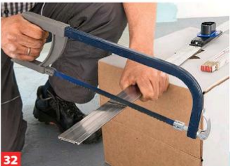
32 ... und längen sie entsprechend ab (die Rinnen sind in 90 und 130 cm erhältlich und bis 30 cm einkürzbar); Kanten entgraten.
