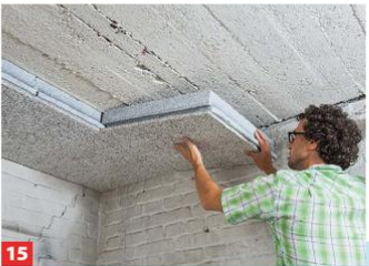
15 Mit dem Reststück beginnen Sie wieder vorne die zweite Reihe, so haben Sie direkt einen Versatz – Kreuzfugen sind zu vermeiden!
