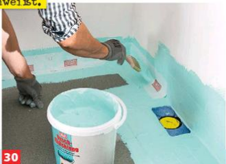
30 ... Abdichtband einlegen und dies sowie den gesamten Duschbereich komplett mit Abdichtanstrich beschichten.
