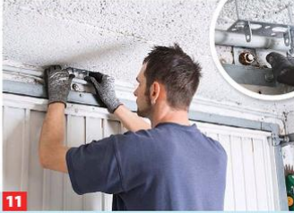
11 Die Sturzbefestigung für die Schiene erfolgt in Tormitte max. 50 mm über dem höchsten Punkt des Tores, entweder an der Wand ...
