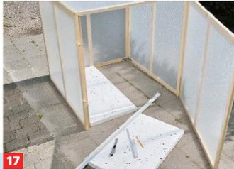
18 Etwa 5 cm starke Styroporplatten werden passend für den Boden zugeschnitten.
