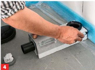
4 Markieren Sie direkt am Dämmstreifen auch die Umrisse des Grundkörpers.
