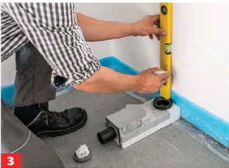
3 ... Wand ausrichten und dies markieren. Die Estrichaussparung vorher umlaufend mit einem Randdämmstreifen versehen.
