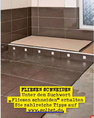
28 Nach vorheriger Verkabelung verklebt man nur noch die Fliese, schließt das LED-Leuchtmittel an und drückt es in die Öffnung.
