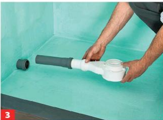
3 Abflussrohr DN 50 ablängen, auf Ablaufgarnitur stecken und mit Gefälle in den Wandabgang einführen. 2) Den Einbausystemrahmen ...
