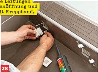
28 Nach vorheriger Verkabelung verklebt man nur noch die Fliese, schließt das LED-Leuchtmittel an und drückt es in die Öffnung.
