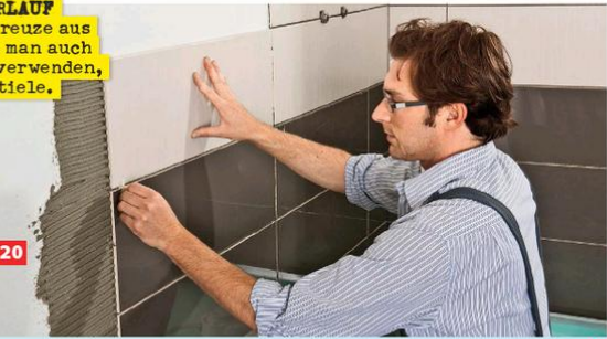
20 Eingesteckte Fugenkreuze nach dem Fliesenlegen wieder herausnehmen; ggf. lassen sie sich erneut verwenden.
