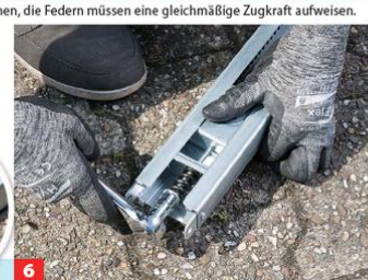
6 Den Zahnriemen soweit spannen, dass die Feder etwa zur Hälfte zusammengedrückt wird. Sie muss im Betrieb federn können!
