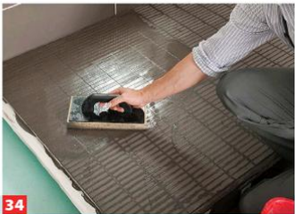
34 Vor allem bei den kleinteiligen Mosaikfliesen mit ihren vielen Fugen den Mörtel sorgfältig einschlämmen.
