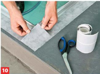
10 Überlappungen in den Eckbereichen noch mit zugeschnittenem Abdichtband überkleben.
