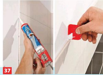
37 Nach zwei Tagen Trocknungszeit versiegeln Sie Anschluss- und Dichtungsfugen mit Silikon. Ein Kunststoffkeil hilft beim Abziehen.
