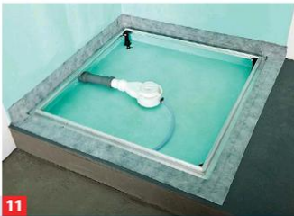
11 Die Abdichtung ist nun komplett. Übrigens: Der Rahmen lässt sich mit Schalungsplatten auch schon vor Estricharbeiten einsetzen!
