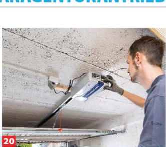
20 ... Endpositionen einstellen, an der das Tor beim Öffnen und Schließen hält. Genaue Erklärungen hierzu in der Bedienungsanleitung.
