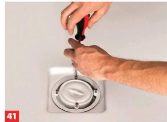
41 Wichtig: Die Schrauben mit maximal 2 Nm anziehen, also locker mit dem Schraubendreher und nicht mit dem Akkuschrauber!
