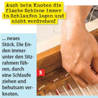
5 ... neues Stück. Die Enden immer unter den Sitzrahmen führen, durch eine Schlaufe ziehen und behutsam verknoten.
