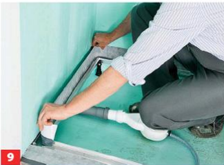
9 Auch den Anschluss zur Wand mit Abdichtband versehen, das Sie dort ein Stück an der Wand hochführen.
