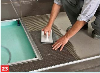
23 Mit einem Fugbrett oder Moosgummibrett drücken Sie die Fliesen glatt an.
