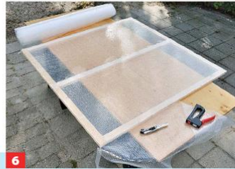
6 Dabei relativ straff spannen. In der Mitte sollten sich die Folienteile überlappen. Überstehende Reste mit dem Cutter abschneiden.
