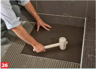
26 Die großen Fliesen in den Kleber einschieben und mit einem Gummihammer gleichmäßig festklopfen.
