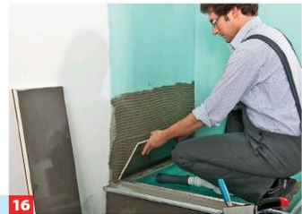
16 Ab 25 cm Fliesenkantenlänge eine Zahnkelle mit 10 mm Zahntiefe verwenden. Die Bezugslinie ist hier der Wannenrand.
