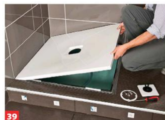
39 Mittenabstützung aus den Randstreifen der Kartonage herstellen, ggf. Potentialausgleich anschließen und Wanne vorsichtig einsetzen.
