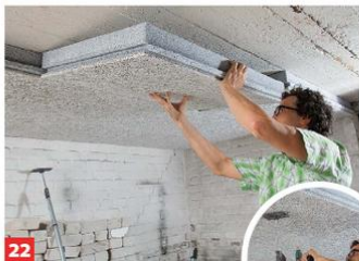
22 Platten weiter im Versatz montieren: fortlaufend abstützen, bohren und verdübeln.
