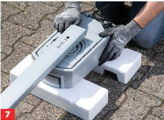
7 Die Schiene umdrehen und mit der Zahnradseite ganz auf den Antriebskopf stecken. 1)
