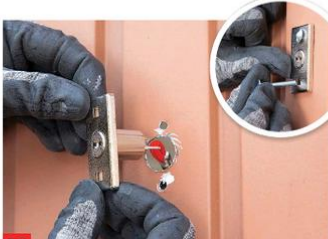
23 Rotes Seil der Not-Entriegelung durchs Loch ins Garageninnere führen, Beschlag, Schließzylinder und Befestigungsschrauben ...
