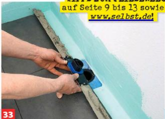
33 Jetzt wird zunächst gefliest! Nach Trocknung überprüfen Sie, ob die Rinne passt. Dann die Schutzabdeckung des Abflusses entfernen, ...
