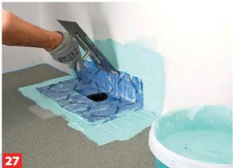
27 Das Vlies dann sorgfältig in die Flächenabdichtung eindrücken und glattstreichen.
