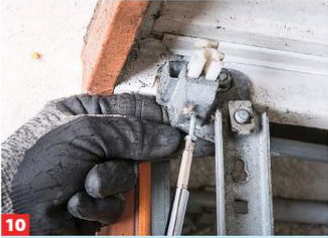
10 Der bisherige Verschlussmechanismus muss so blockiert werden, dass das Tor frei öffnet und schließt. Dies ist individuell zu prüfen!
