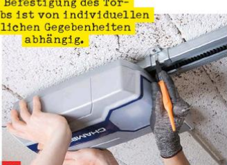
14 ... führen und mit Mutter sichern. Jetzt den Antriebskopf befestigen, in unserem Fall direkt an der Decke aus Bimsbetonplatten.
