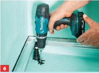
6 Um den Rahmen während der Fliesenarbeiten zu fixieren, die Bodenbefestigungen an die Füße stecken und am Boden verdübeln.
