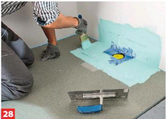
28 Den kompletten Bereich bis rund um den Abfluss mit Abdichtanstrich versehen.
