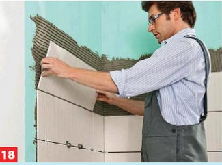
18 Den Fliesenkleber immer nur abschnittsweise auftragen; verwenden Sie kunststoffvergete Flexkleber mit hoher Anfangshaftung.
