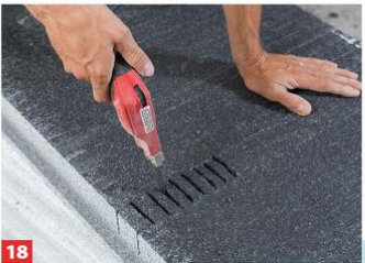
18 Je nach Erfordernissen ist auch eine spezielle Handsäge hilfreich.
