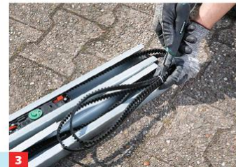
3 Zunächst Kabelbinder, die den Zahnriemen sichern, mit Schere bzw. Cutter entfernen.
