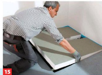
16 Die Platte in die Estrichaussparung einlegen und leicht andrücken. Anschließend die Position des Dünnbettaufsatzes festlegen.
