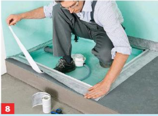
8 Trennstreifen abziehen und Abdichtbänder fest verkleben.
