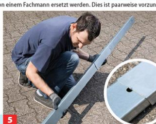
5 ... nach außen biegen und die Schienenteile ineinanderschieben. Durch die Blechnase sind sie im richtigen Abstand gesichert.
