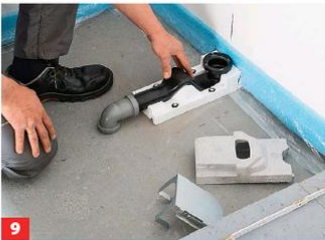
9 Mit einem 90-Grad-Siphonbogen den Grundkörper mit dem Ablauf verbinden. Die Rohre sind übrigens durch das ...
