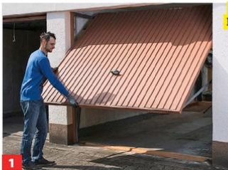
1 Das Tor zur Hälfte öffnen und loslassen. Hält das Tor weitgehend die Position, kann der Torantrieb eingebaut werden. 2)
