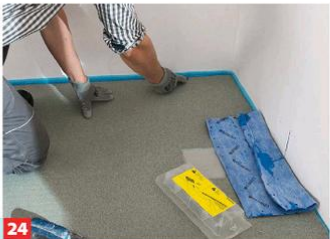
24 Überstände des Randdämmstreifens bündig zur Plattenoberseite abschneiden und den Bauschutz des Dünnbettaufsatzes entfernen.
