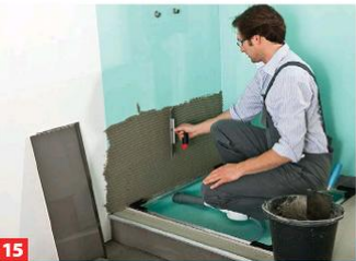
15 Eine sinnvolle Bezugslinie markieren, an der Sie mit dem Fliesenlegen beginnen. Fliesenkleber anrühren und mit Zahnkelle aufziehen.
