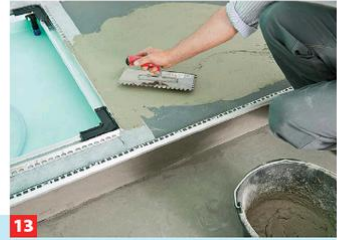
13 Fliesen trocken auslegen und kontrollieren, ob sie bündig abschließen; ggf. den Untergrund etwas beispachteln.
