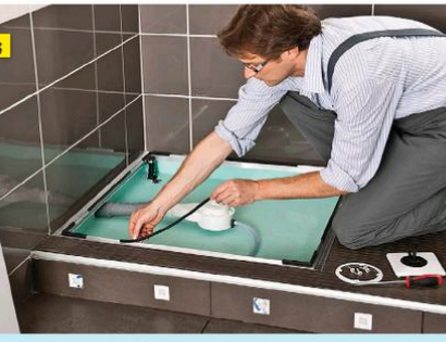
37 Nach zwei Tagen Trocknungszeit versiegeln Sie Anschluss- und Dichtungsfugen mit Silikon. Ein Kunststoffkeil hilft beim Abziehen.
