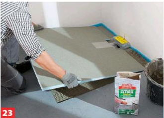
23 In unserem Fall folgt eine Gefälleplatte aus Polystyrolhartschaum, die mit Flexkleber auf die bereits verlegte Platte geklebt wird.
