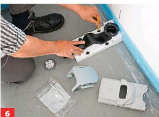
6 Grundkörper wieder platzieren, die schützende Aufsatzschale obendrüber abziehen und die vier Bohrlöcher markieren.
