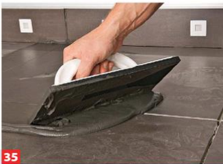
35 Immer diagonal und satt zur Fugenrichtung einarbeiten. Überschüssigen Mörtel bündig abziehen.
