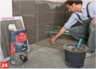
24 Unterhalb des Podestes werden 60 x 60 cm große Fliesen verlegt. Hierfür gibt es spezielle Flexkleber für großformatige Fliesen.
