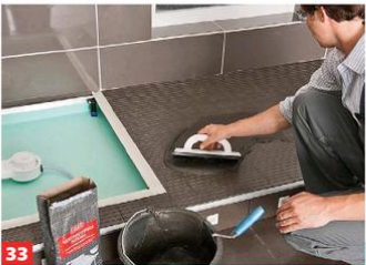
33 Nach den Wandfliesen verfugen Sie die Bodenfliesen. Gerade auf einem Podest wie hier flexiblen Fugenmörtel einsetzen.
