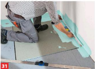
31 Zwischendurch können Sie noch einmal die Breite des Duschbereichs nachmessen. Übertragen Sie das Maß auf die Duschrinne ...
