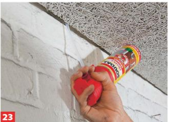
23 Hohlstellen und schmale Lücken am Rand mit dämmendem Bauschaum füllen, die Decke muss lückenlos gedämmt sein!
