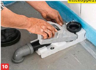
10 ... verdübelte Unterteil des Grundkörpers vom Untergrund schallentkoppelt. Stecken Sie nun die Aufsatzschale wieder auf.
