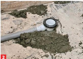
2 2 Prozent Gefälle einplanen, also 2 cm auf 1 m. Mit Zementestrich die Unebenheiten auffüllen.
