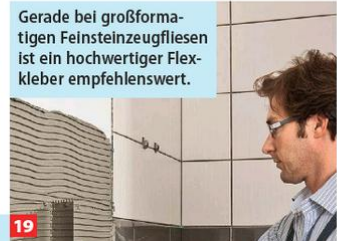
19 Gerade bei großformatigen Feinsteinezeugfliesen ist ein hochwertiger Flexkleber empfehlenswert.
