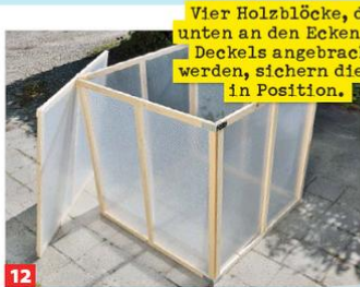
12 Vier Holzblöcke, die unten an den Ecken des Deckels angebracht werden, sichern diesen in Position.
