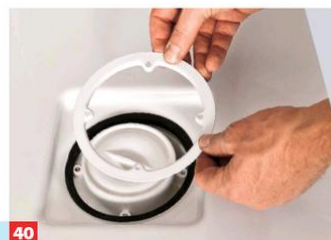
40 Den Siphon mit Ringen/Dichtringen befestigen. Die Einbauanleitung zeigt dies ziemlich detailliert – bitte beachten.
