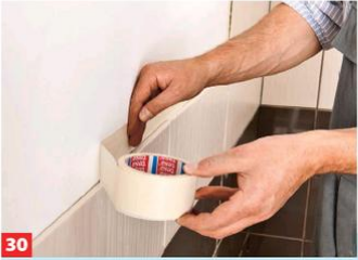
30 Nach 24 Stunden kann verfugt werden. Kleben Sie nicht geflieste Bereiche mit Kreppband ab, damit dort nichts verschmutzt.
