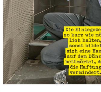
19 Gerade bei großformatigen Feinsteinezeugfliesen ist ein hochwertiger Flexkleber empfehlenswert.
