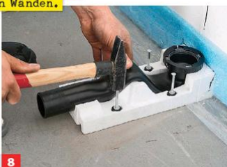
8 Grundkörper erneut platzieren und mit den Schlagdübeln am Untergrund befestigen.
