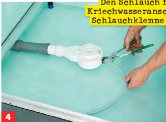
4 Den Schlauch für den Kriechwasseranschluss mit Schlauchklemme sichern.
