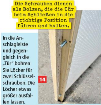
15 Führen Sie die Schraube mit Unterlegscheibe von innen ein. Mit der Mutter so sichern, dass diese im Holz verschwindet.
