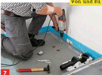
7 Für die mitgelieferten Schlagdübel die vier markierten Löcher bohren.
