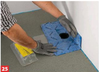
25 Das am Ablauf des Dünnbettaufsatzes vormontierte Vlies entfalten und über der Gefälleplatte und der Wandfläche ausbreiten.
