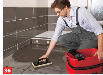
36 Beim Reinigen mit Schwamm oder Schwammbrett am besten unter leichtem Druck in eine Richtung wischen.
