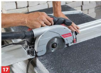
17 Die Polystyrolschicht in nötiger Tiefe mit Handkreissäge oder Stichsäge einschneiden.
