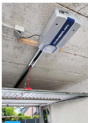
44 Garagentorantrieb Montage am alten Schwingtor
