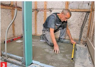
3 Das folgende Duschelement, hier aus zementummanteltem Hartschaum, muss plan aufliegen.
