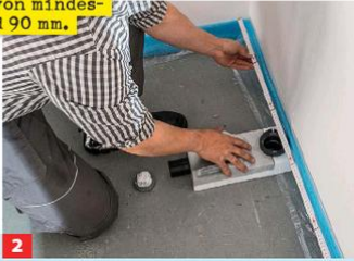
2 Der Bodenablauf befindet sich mittig und wird an die Wand geführt. Dazu Grundkörper des Cleanline-Systems mittig an der ...
