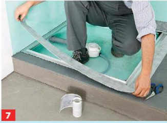
7 Abdichtband (Vlies-Butylband) für die Übergangsbereiche zwischen Boden und Ablaufkante des Einbausystems zuschneiden.
