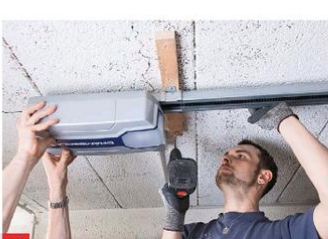
15 Hier platzierte man eine Holzlatte unter den Verankerungen an der Schiene und schraubte an mehreren Punkten direkt in die Decke.
