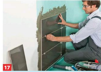
17 Setzen Sie Abstandsklötze/Fliesenkreuze in gewünschter Fugenstärke, um einen gleichmäßigen Fugenverlauf sicherzustellen.
