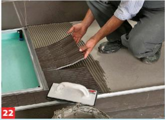
22 ... werden hier nun Mosaikfliesen im Farbton Mokka verlegt, die auf 30 x 30 cm großen Netzen zusammengefasst sind.
