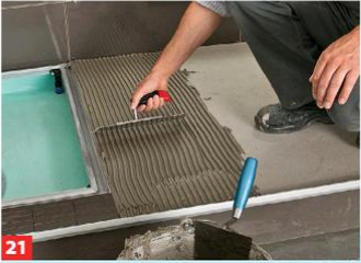
21 Es folgen die Bodenfliesen. Auf dem Podest wird Flexkleber aufgezogen. Kamen an der Wand 25-x-70-cm-Fliesen zum Einsatz, ...
