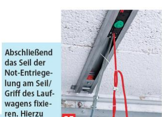
25 Abschließend das Seil der Not-Entriegelung am Seil/Griff des Laufwagens fixieren. Hierzu Montageanleitung der Not-Entriegelung beachten!
