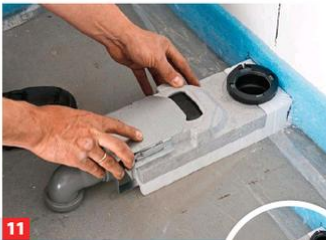
11 Die als Schutzklammer bezeichnete obere Abdeckung sichert das Abflusssystem.
