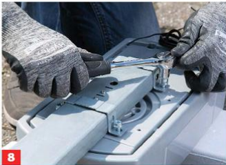
8 Mit den beiden Befestigungsbügeln und den Schrauben die Schiene am Antrieb sichern.
