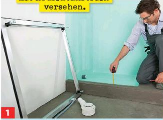
1 Die Montage der Wanne beginnt ohne sie: Tiefe der Bodenaussparung messen und Füße am Einbausystemrahmen 1) grob einstellen.
