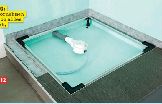
12 In die Ecken die mitgelieferten schwarzen Verlegehilfen drücken, die ein optimales Verfließen bis an den Rand ermöglichen.
