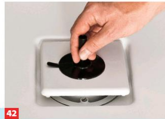
42 Dann den Ablaufdeckel aufsetzen. Abschließend die Fugenkanten rund um die Wanne mit Silikon versiegeln.
