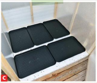
C Darauf werden als Wasserauffangbecken z. B. Schmutzschalen für Schuhe platziert.
