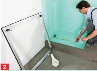
2 Zur Montage der Ablaufgarnitur ermitteln Sie die Länge vom Wandabgang bis zur Mitte; der Ablauf liegt in Wannenmitte.
