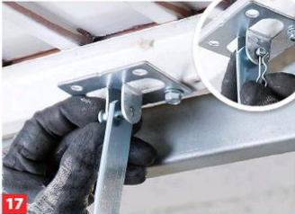
17 Daran wird der Torarm, auch Mitnehmer oder Führungsarm genannt, mit einem Splintbolzen befestigt.
