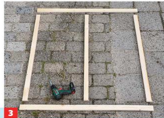
3 Jede Seite besteht aus zwei Quer- und drei Längsstreben. Legen Sie diese aus, am besten auf einer großen Platte, die Sie ...
