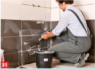
31 Fugenmörtel in passender Farbe anrühren und mit Fuggummi oder Fugbrett/Moosgummi-brett diagonal in die Fugen einarbeiten.
