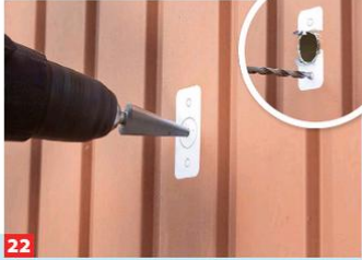
22 Durch die Schablone hindurch ein 19-mm-Loch mit Blechschräbholer sowie 6,5-mm-Schraublöcher mit Metallschrauber bohren.
