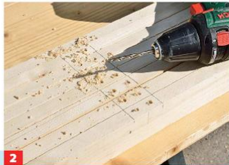
2 Verspannen Sie die Latten, damit sie nicht verrutschen. Innerhalb der Markierungen je zwei Löcher für die Verschraubung bohren.
