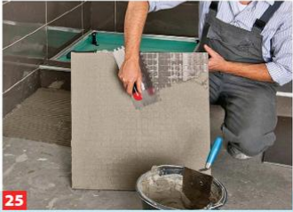
25 Ab Kantenlängen von über 50 cm den Kleber sowohl auf den Boden als auch auf der Fliesenrückseite aufziehen (siehe Kasten unten).
