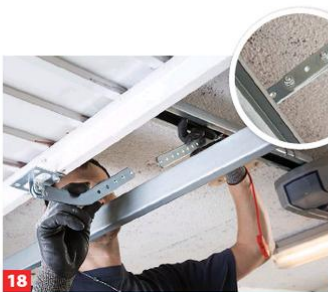
18 Den gebogenen Torarm nun mit dem in der Schiene vormontierten Abschnitt verbinden und mit Muttern/Schrauben sichern. 2)
