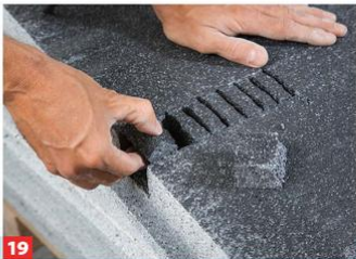
19 Durch die Einschnitte ließen sich hier die Polystyrolstücke gut herausbrechen.
