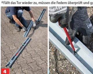
4 Vordere und hintere Schienenteile mit Lücke hintereinanderlegen, sodass Platz für das Mittelteil ist. Darin die Blechnase ...
