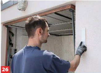
26 Optional gibt es auch das Funkcodeschloss. So kommt man durch Eingabe einer vierstelligen Pin in die Garage.
