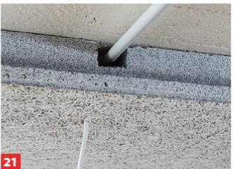
21 Während Sie die Platte ansetzen, ziehen Sie das Kabel durch das Loch in der Platte und verdübeln sie dann.
