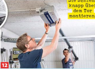
12 ... oder wie hier an der Decke, bis zu 150 mm raumseits. Den Antrieb nun abstützen oder von einer zweiten Person festhalten lassen.
