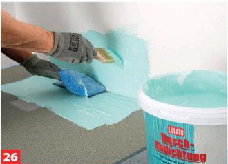
26 Unterhalb des Vlieses sowie rundum Abdichtanstrich auftragen.
