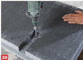
20 Muss ein Kabel durch die Platte geführt werden, bohren Sie vor der Montage ein entsprechendes Loch hinein.
