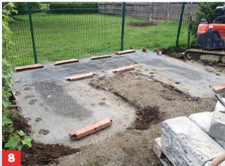
8 ... und erstmal provisorisch fixiert. Dank des feinmaschigen Netzes bleibt der Kontakt zur belebten Bodenzone erhalten.
