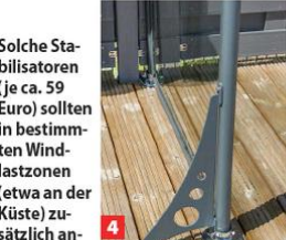
4 Solche Stabilisatoren (je ca. 59 Euro) sollten in bestimmten Windlastzonen (etwa an der Küste) zusätzlich angebracht werden.
