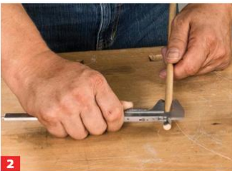
2 Nun wählen Sie eine Dübelstange – möglichst aus einem ähnlichen Material (Weich- bzw. Hartholz) und ermitteln den ...
