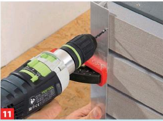
11 Den Winkel an der Konstruktion festspannen und diesen sowie das Profil durchbohren. Diesen Schritt jeweils auf beiden Seiten ...
