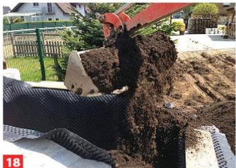
18 Für die späteren Zersetzungsprozesse werden zunächst Gartenabfälle wie Äste und Laub (siehe unten) eingelegt. Darauf ...
