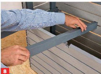
8 Das mittlere Auflager wird hingegen nur eingelegt.
