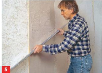
5 ... einem glatten Brett ziehen Sie den Putz über die Putzleisten hinweg glatt ab. Hat der Putz leicht angezogen, reiben Sie mit ...
