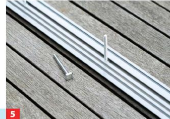
5 Nun die Sechskantschrauben in die vorgesehene Profilmutter schieben, je eins in die kurzen, je drei in die langen Profile.
