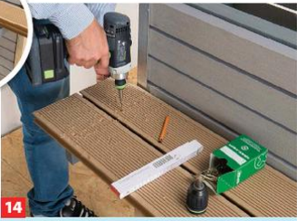
14 ... Sie diese ca. 5 mm zurückspringend ab und lackieren die Schnittfläche. Dielen vorbohren und mit den Auflagern verschrauben.
