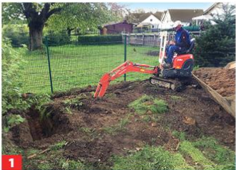
1 Für das Streifenfundament heben Sie den Untergrund entlang der abgesteckten Markierungen aus.
