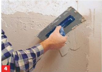
4 Den Putz mit einer Kelle aufziehen. Die Verarbeitungszeit einer Mischung beträgt etwa 1,5 Stunden. Mit einer Richtlatte oder ...
