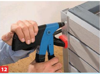
12 ... und an drei Positionen (oben, mittig und unten) wiederholen. Mit Blindnieten werden die Elemente dann fest verbunden.
