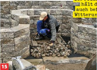
15 Für den Boden werden Reste des Betonsteins mit einem Rand aus Grauwacke verlegt. Dafür noch etwas Splitt aufschütten.
