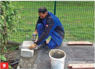
9 An einer Ecke beginnen Sie mit dem Mauern. Die erste Reihe wird im Mörtelbett verlegt. Das stabilisiert und gleicht kleine ...
