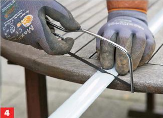
4 Die zwei längeren Profilschienen auf X-Maß minus 8 cm, die zwei kürzeren Profile auf Y-Maß minus 8 cm zusägen.
