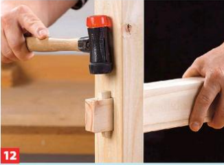
12 ... angerissene Markierung hinausragen. Zapfen einstecken und den Keil mit einem Schonhammer einschlagen.
