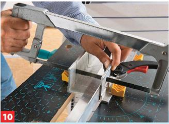
10 Um die Schnittkanten in den Ecken zu verbergen, werden Alu-Winkel genutzt. Diese zunächst mit der Eisensäge ablängen.
