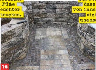
16 Zum Schluss fegen Sie Fugenmaterial ein. Wässern Sie die Fläche, anschließend nochmals einfeigen, bis nichts mehr nachrutscht.
