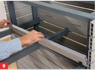
9 Entsprechend muss auch das nun folgende Profil mit Ausklinkungen versehen werden. Beplanken Sie dann bis zum Ende.
