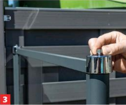
3 Hängen Sie das Glas ein. Oben werden noch die Chromdeckel aufgeschraubt.
