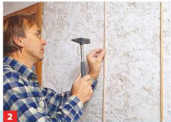
2 Um den Putz gleichmäßig abzulehen zu können, setzt man Putzschienen oder Holzleisten in Putzstärke* an die Wand. Statt sie ...
