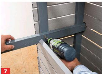
7 Die beiden äußeren Auflager werden dann mit den Seitenstreben verschraubt.
