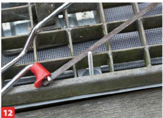
12 Bei Bedarf können die Sechskantschrauben noch etwas gekürzt werden.
