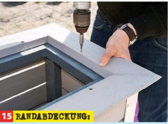
15 RANDABDECKUNG: Vier auf Gehrung geschnittene Rhombusprofile auflegen (alternativ Dielen), vorbohren und verschrauben, Schraubköpfe versenken!
