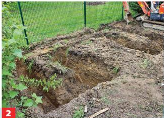
2 Die Gräben sind hier etwa 40 cm breit und für eine frostfeste Gründung etwa 80 cm tief ausgebaggert worden.
