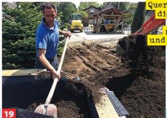
19 ... kommen dann ca. 4 m³ Mutterboden, die mit dem Minibagger eingefüllt und mit einer Schaufel gleichmäßig verteilt werden.
