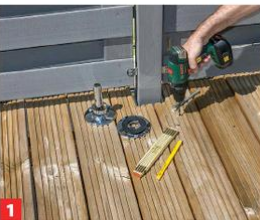
1 Zunächst Position der Füße markieren, bohren und Gestelle verschrauben.
