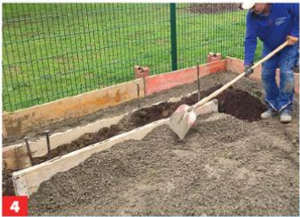
4 Bedingt durch die leichte Hanglage wird hier eine Schalung errichtet, damit der Beton in gewünschter Höhe aushärtet.
