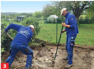
3 Nun wird nach und nach der angemischte Beton eingebracht. Das Fundament wird sogar noch mit einer Bewehrung verstärkt.
