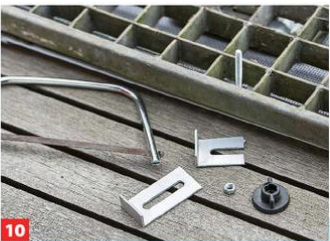
10 Den Gitterrost auf die Rückseite der Abdeckung legen, dabei die Sechskantschrauben entsprechend ausrichten.
