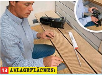
13 ABLAGEFLÄCHEN: WPC-Dielen ablängen und auf den Auflagern positionieren. Markieren Sie die Stelle, an der die Auflager bündig abschließen, längen ...
