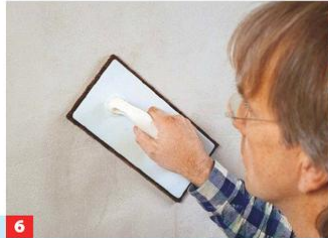
6 ... einem Filz- oder Schwammbrett in kreisenden Bewegungen darüber und verdichten ihn, dann ggf. mit Glättkelle glätten.
