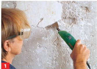
1 Alte, lockere Putzreste vorher entfernen, z.B. mit einem Elektrospatel (Schutzbrille tragen). Dann grundieren (Kasten oben rechts).
