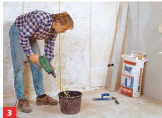
3 ... zu nageln, setzt man sie besser mit Mörtel an die Wand, so lassen sie sich ausrichten. Den Gipsputz mit Wasser anrühren.**
