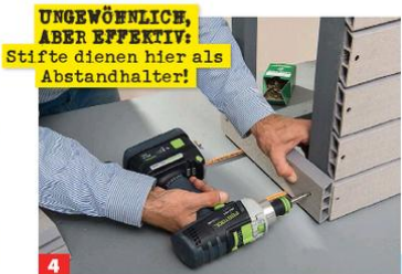
4 Im Abstand von ca. 8 mm zum Boden wird das erste Profil angebracht. Der Schraubenkopf verschwindet dabei komplett im Loch.
