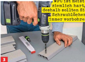
3 ... WPC-Rhombusprofile für die Seitenverkleidung zuschneiden und vorbohren. Dabei das Loch auf der Frontseite vergrößern.
