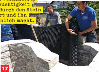
17 Innen werden die Seitenwände mit stabiler Noppenfolie ausgekleidet, um Betonstein und Erde zu trennen.
