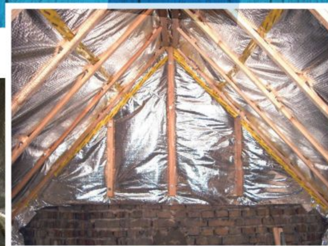
DÄMMUNG IM DACH: Die einzelnen Bahnen des Foliendämmsystems werden untereinander mit Dampfbremsklebeband verklebt.
