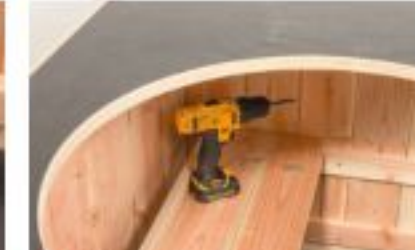
27 Der Zwischenboden, auf dem der Grill steht, ruht auf seitlichen Auflagerleisten zwischen den Holmen. Entlang der Rückseite ...
