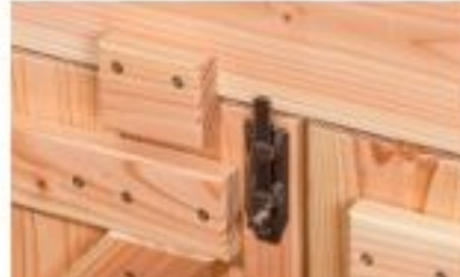
17 Hinter die zweite (hier rechte) Tür werden ein Anschlagholz und der Fensterriegel montiert.
