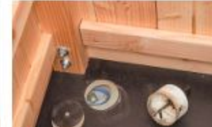
26 In die hintere linke Ecke des Grill-Moduls haben wir für die Luftzufuhr eine Öffnung mit der Lochsäge geschnitten.
