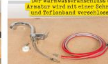
31 Armatur einbauen (Schlauchnippel am Zulaufschlauch anschrauben) und die komplette Platte einkleben.
