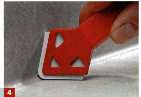
**4** Entfernen Sie das Kreppband und ziehen die Fugen ggf. nochmals nach, damit auch die Ränder glatt an die Fliesen anschließen.
