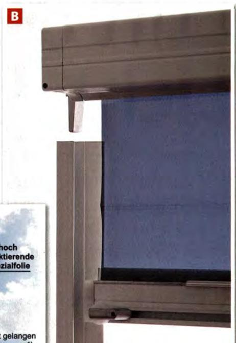
**B** Das *SmartRollo* wird direkt am Fensterflügel montiert und besitzt seitliche Führungsschienen.
