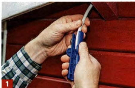
**1** Hier wurde die Zuleitung in einem regengeschützten Bereich einfach durch eine Bohrung im Gartenhaus geführt.
