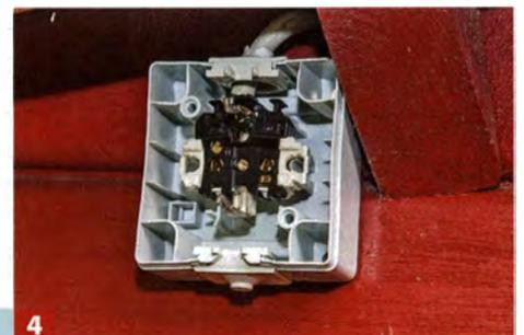
**4** Nach Herstellen der elektrischen Verbindungen Steckdosenkörper aufschrauben und Träger einsetzen. Deckel aufschrauben.
