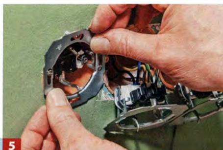
5 ... Verbindung zur nächsten Steckdose direkt möglich ist. Sonst die Verbindungen mit Dolklemmen hinter den Einsätzen herstellen.
