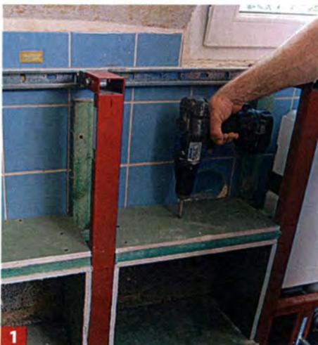
**1** Zwischen Vorwandprofilen und Wand Holzplatten befestigen und darüber zugeschnittene Feuchtraumgipsplatten schrauben.
