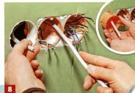
**8** ... Einsetzen die neu zu verlegende Verbindungsleitung aus einer der vorhandenen Dosen in den Dosenkörper führen.
