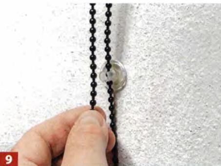
**9** Auch Kettenlänge, -farbe und Bediensseite legen Sie bei der Bestellung fest. Den Kettenhalter entsprechend festschrauben.
