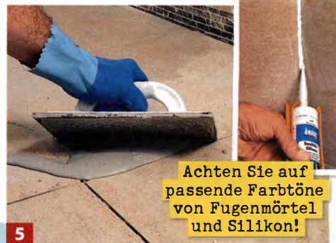
5 Fugenmörtel mit dem Moosgummibrett einarbeiten, Fläche mit dem Schwamm Brett reinigen. Anschlussfugen mit Silikon ausfügen.
