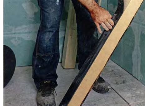
Dichtband unterm Holzbalken sorgt für Schallschutz
