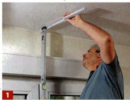
**1** Ermitteln Sie die Montageposition an der Decke – hier muss das Rollo vor dem Rollladenkasten montiert werden.
