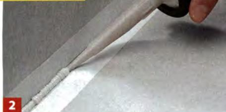
**2** Sind alle Silikonreste entfernt, Fuge beidseitig mit Kreppband abkleben und neues Silikon gleichmäßig einspritzen.
