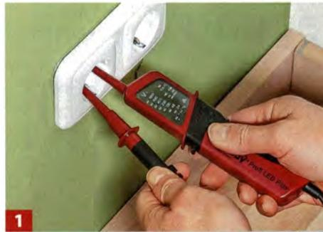
**1** Sicherung abschalten und die Spannungsfreiheit des betroffenen Stromkreises mit einem Messgerät überprüfen.
