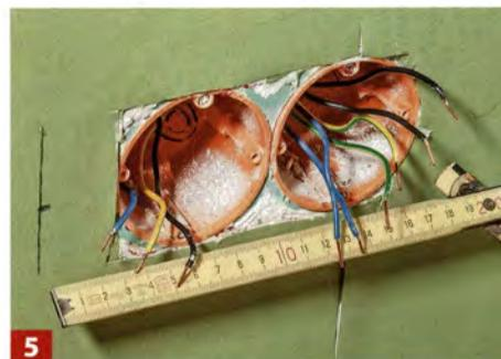
**5** Legen Sie nun die Bohrposition für die Erweiterungsdose fest und vergewissern Sie sich, dass beim Bohren keine Leitungen ...
