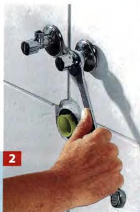
Die Eckventile an den Kalt- und an den Warmwasserausgang festschrauben. Dann zwei Trinkwasserschläuche unten an die Armatur schrauben. Diese von oben durch die ...
