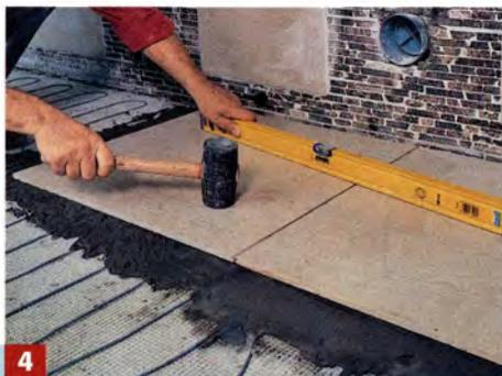
4 Besonders große Fliesen nicht mit Augenmaß, sondern mit Wasserwaage und Gummihammer im Kleberbett ausrichten.
