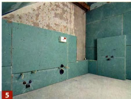
Fertig: Die Platten sind in zwei Lagen übereinander montiert; Anschlüsse von links nach rechts: Bidet, WC, Waschbecken.
