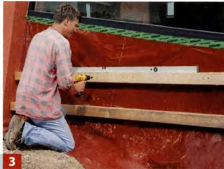
Die Grundlattung aus Rahmenhölzern ausrichten und an der Holzständerkonstruktion des Anbaus befestigen, Lattenabstand ...
