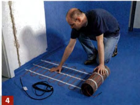
**4** Die Heizmatten nun nahe des Stromanschlusses ausrollen. Der Untergrund muss glatt, sauber und fest sein.
