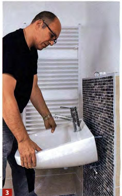
3 ... Beckenöffnung führen, bis sie aufsitzt. Das Becken an den Gewindestangen aufhängen und festschrauben (siehe Bild 5).
