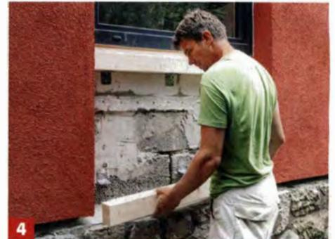
4 Entsprechend der Dämmdicke die Grundlattung montieren. Untergrund ggf. ausgleichen, die Lattung muss plan verlaufen!
