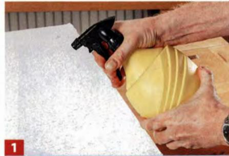
**1** Die mit bis zu drei Lagen tapezierte Platte wurde ausgiebig mit Wasser besprüht.
