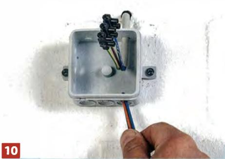
**10** Die Leitungen lassen sich am einfachsten durch die Verschlussnipel einführen, wenn die Adern bereits abisoliert wurden.
