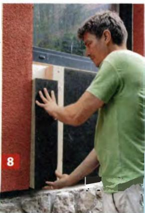
8 Zweite Lage Dämmstoff zuschneiden und einklemmen. Hier wurde eine 100 mm und eine 80 mm Dämmschicht eingesetzt.
