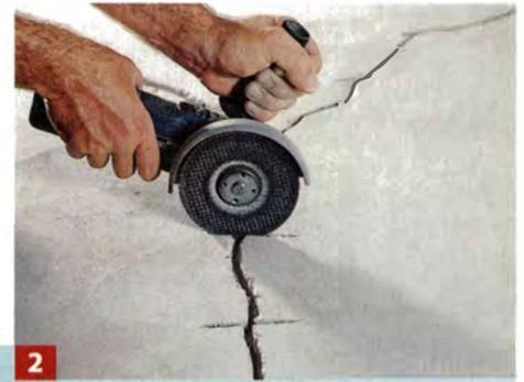
**2** Um die Sanierklammern setzen zu können, schneiden Sie mit Winkelschleifer und Trennscheibe quer über den Riss alle ...
