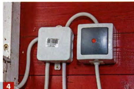
**4** Verteilerdose zuklipsen, Schalterdeckel aufschrauben. Die Schalterwippe wird meist eingeklippt. Strom einschalten, Funktion prüfen.
