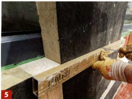
Dämmplatten einsetzen und dann bündig zum Fensterverlauf schräg abschneiden.
