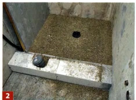
**2** ... Lehren plan abgezogen wird. Die Rohre sind dann von der Schüttung überdeckt, nur der Dusch- und WC-Abfluss liegen frei.
