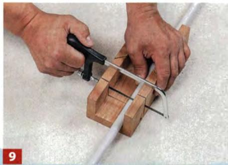
**9** Die Länge der Installationsrohre abmessen. Rohre dann am besten in einer Lade mit der Bügelsäge (Metallsägeblatt) ablängen.
