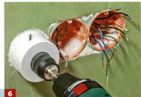
**6** ... im Hohlraum beschädigt werden können. Mit einer 68-mm-Bohrkrone die benötigte Aussparung in der Wand herstellen.
