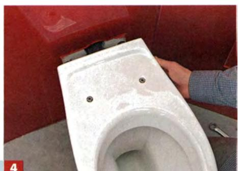
**4** Das wandhängende WC mit dem Abfluss verbinden, auf die Gewindestangen aufstecken und an der Verkleidung festziehen.
