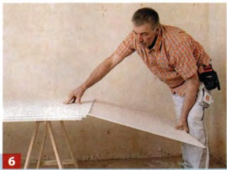
**6** Die Platte lässt sich dann über eine Kante hinweg durchbrechen. Der Zuschnitt mit normalem Cutter wird oft nicht so akkurat.
