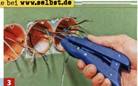
3 Adern abisolieren. Für Schraubklemmen sollte die abisolierte Länge etwa 6 mm, für Steckklemmen 10 bis 12 mm betragen.
