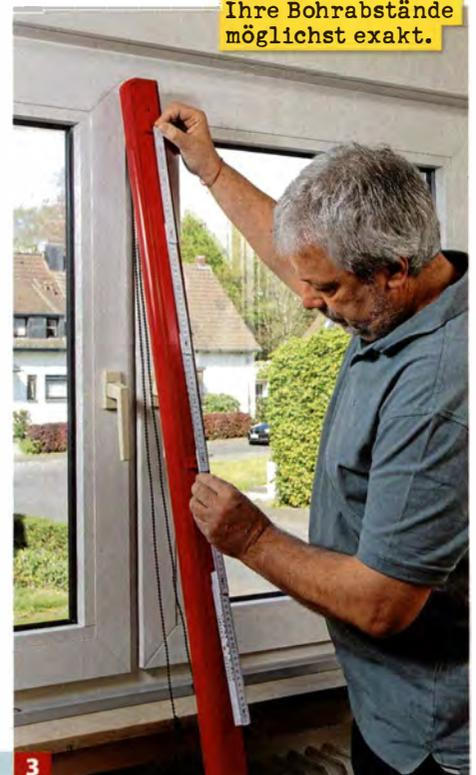
**3** Abhängig von der Rollobreite die nötige Anzahl der Clips (hier vier) gleichmäßig verteilt aufstecken; Lochabstand messen!
