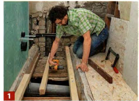
**1** Der Boden wurde bis zur Sparschalung unterhalb der Deckenbalken freigelegt. Zu beiden Seiten der Balken befestigte man ...
