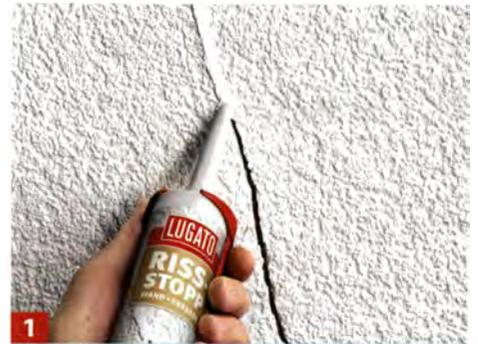
1 Loses Material entlang des Risses entfernen, säubern und Riss mit Acryl-Dichtmasse oder einem elastischen Polymerkleber füllen.
