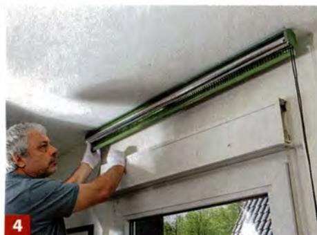
**4** Die Montage des Wickels erfolgt in umgekehrter Reihenfolge. An der Decke ist sie jedoch etwas schwieriger.
