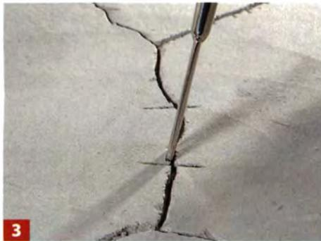
**3** ... 20 bis 30 cm Schlitz in den Estrich. Die Schlitztiefe sollte  $\frac{1}{2}$  bis  $\frac{2}{3}$  der Estrichstärke betragen. Den Riss dann säubern!
