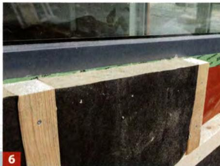
Dämmstoff so zuschneiden bzw. Lattung so setzen, dass die Dämmplatte stramm ohne Luftspalte dazwischensitzt.
