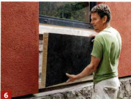
6 Die zugeschnittene Dämmplatte (Isover Ultimate Fassadendämmplatte 035) in den Zwischenraum klemmen.
