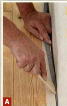
Hinterfüllschnur in den Hohlraum stopfen, dann die Fugen mit Silikon verschließen.
