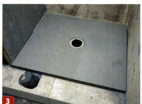
**3** Das 1200 x 1200 mm große Duschelement bzw. Bodenablaufsystem wird aufgelegt. Bei komplettem Bodenausgleich schließt ...
