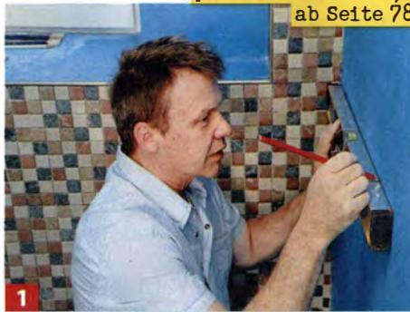
1 Die Höhe, bis zu der die Wandfliesen verlegt werden, ist durch die Höhe der Abkantung definiert. Den Höhenriss rundum markieren.
