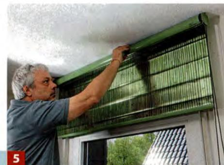
**5** Nun die Blende aufstecken und das Rollo auf Funktion testen. Anschließend Anschlagbegrenzer und Kettenhalter montieren.
