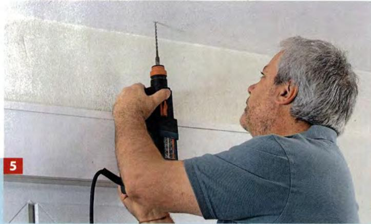
**5** Bei Stahlbetondecken reichen in der Regel 6-mm-Löcher für die entsprechenden, mitgelieferten Dübel und Schrauben. Idealerweise einen Bohrer verwenden.
