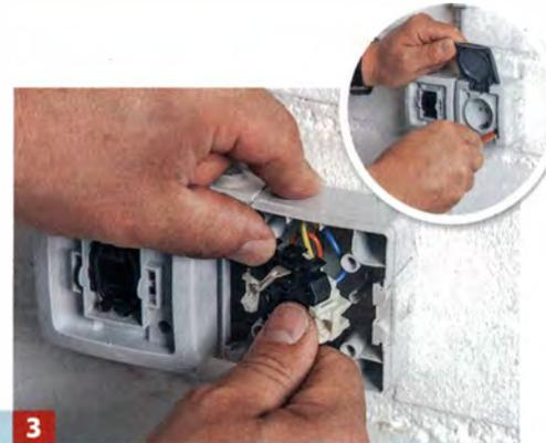
**3** In Steckdosen kann der Geräteinsatz zur einfacheren Verdrahtung herausgezogen werden. Zum Schluss Deckel aufschrauben.
