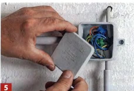
**5** Der Deckel wird später aufgesteckt, er ist mit einer dichtenden Lippe gegen das Eindringen von Feuchtigkeit versehen.
