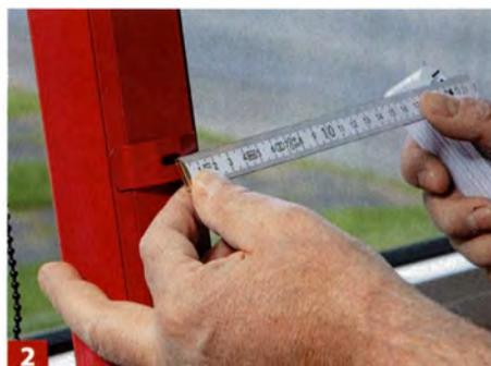
**2** Zu dem am Fenster abgenommenen Maß addieren Sie den Abstand von der Rollo-Rückseite bis zur Mitte des Clip-Langlochs.
