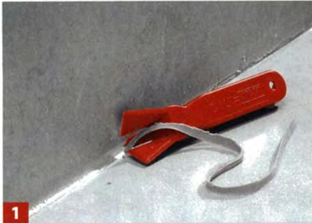
**1** Fugenschneider, Fugenhai oder Silikonkratzer – es gibt spezielle Werkzeuge, die das Herauslösen alter Silikonfugen erleichtern.
