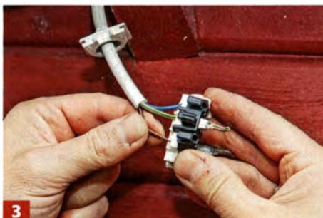
**3** Im Inneren der Aufputzsteckdose können die Zuleitungsdrähte einfach angesteckt werden. Der Träger ist abnehmbar.
