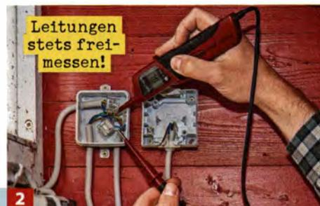
**2** ... durch elastische Gehäusemuffen nach innen führen. Stromkreis abschalten und stromgebende Verteilerdose öffnen.
