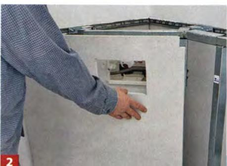
**2** Die erste Lage Verkleidung erfolgt mit Gipsfaserplatten, die mit Ausschnitten für die Spültaste und den Abfluss versehen sind.
