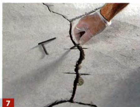
**7** Dann setzen Sie die Estrichklammern in die vorgefrästen Schlitz und übergießen sie ...
