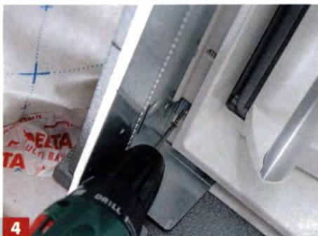
**4** Das Profil anschließend am Fensterrahmen an den vorgesehenen Stellen festschrauben.
