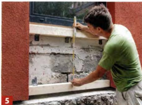
5 Zwischenraum ausmessen und den Dämmstoff so zuschneiden, dass er an allen Seiten bündig anliegt (ca. 10 mm Klemmzugabe).
