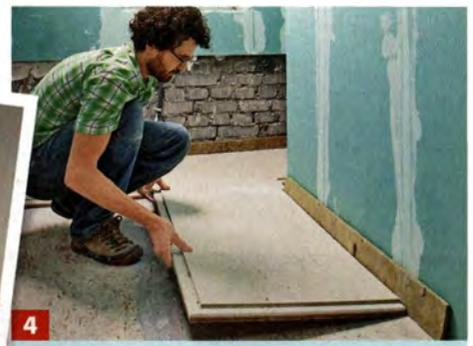
**4** Umlaufend Randdämmstreifen verkleben, dann die Trockenestrichelemente auslegen. Sie werden im Falzbereich verklebt.
