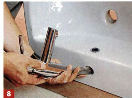
Dann das Waschbecken an den Gewindestangen aufhängen, dabei eine Schallschutzmatte hinterm Becken platzieren!
