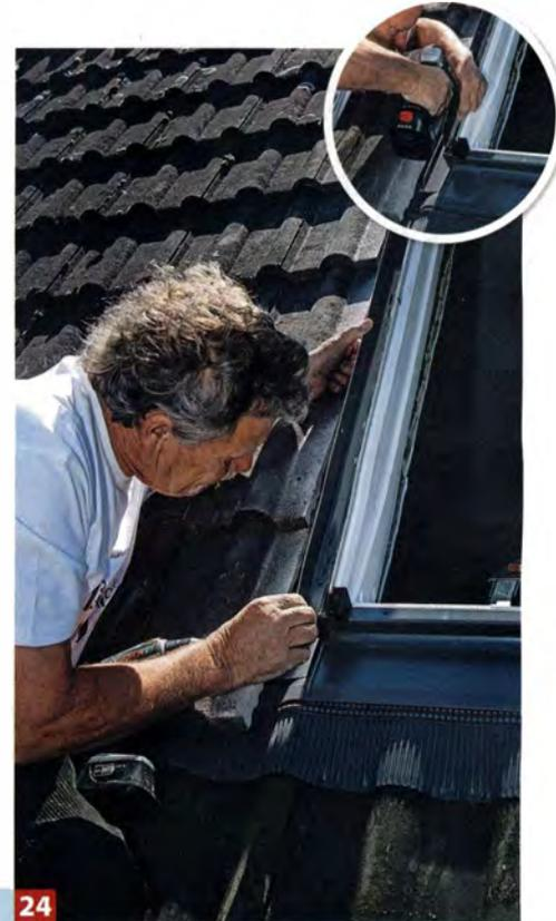
**24** Folgt ein Rollladen, befestigt man obenauf noch Führungsschienen.
