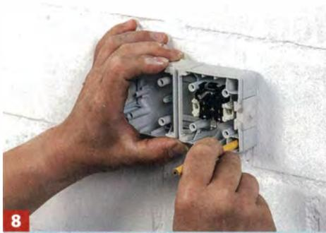
**8** Position von Schaltern und Kombigeräten markieren, Geräte öffnen und an den Montagepositionen auf der Wand verschrauben.
