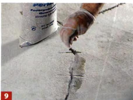
**9** Saniergießharze (z. B. Epoxidharz) bilden eine sehr glatte Oberfläche. Damit anschließender Belagskleber gut haftet, streuen ...
