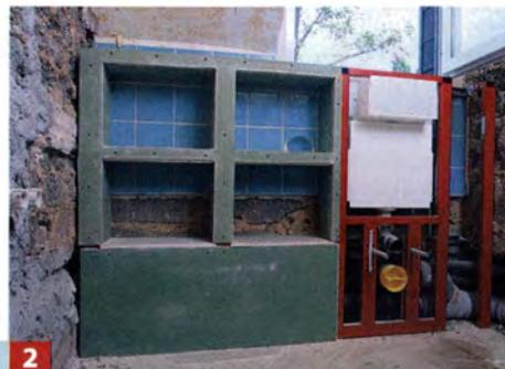
**2** Für die Verkleidung vorne ebenfalls Gipsplatten passend zuschneiden und mit Schnellbauschrauben an den Profilen befestigen.
