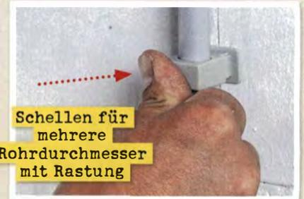
Schellen für mehrere Rohrdurchmesser mit Rastung
