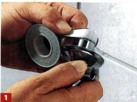
1 Um zwei Eckventile für den Kalt- und Warmwasserausgang Teflonband oder Hanf/Dichtpaste zur Abdichtung wickeln.
