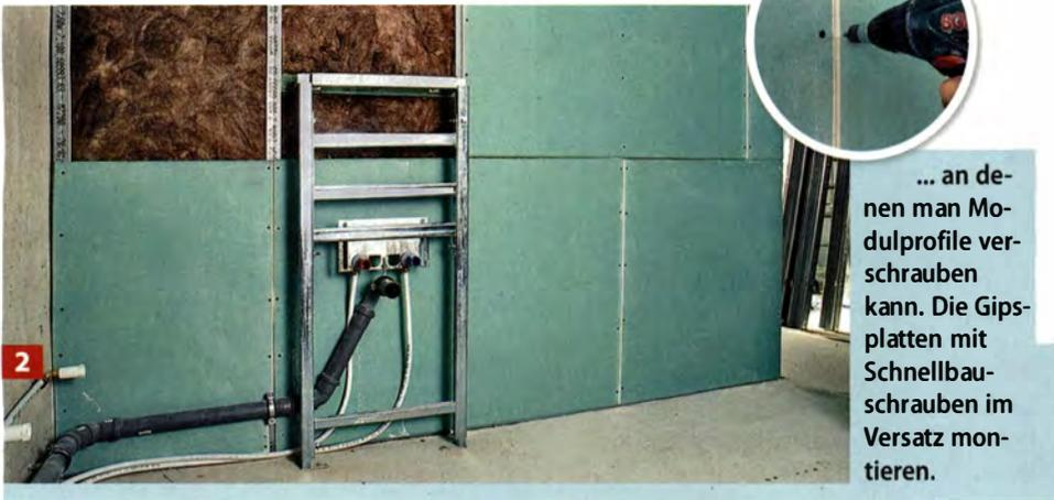
... an denen man Modulprofile verschrauben kann. Die Gipsplatten mit Schnellbauschrauben im Versatz montieren.
