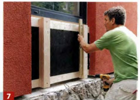
7 Nun die Konterlattung aus Rahmenhölzern zuschneiden, ausrichten und montieren.
