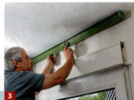
**3** Nun die Kassette an der Decke positionieren, markieren, bohren und Dübel einstecken. Dann durch die Kassette schrauben.
