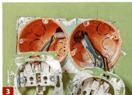
**3** ... vorhandenen Steckdoseneinsätze ausgetauscht werden. Hier besteht die Wand aus Gipskarton, die Elektroinstallation ist ...
