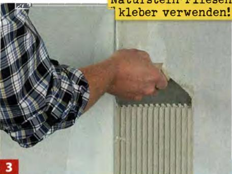
**3** Tragen Sie auf einer Seite entlang der Markierung Fliesenkleber auf und drücken die gelochte Schenkelseite des Profils in den Kleber.
