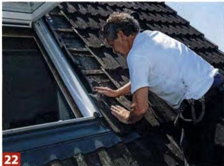
**22** Der Schaumstoff an den Eindeckrahmenseitenteilen wird auf die Höhe der Dachsteine gekürzt. Danach werden diese aufgelegt.
