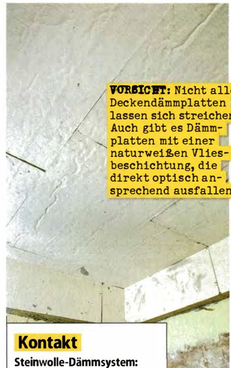
**VORSICHT:** Nicht alle Deckendämmplatten lassen sich streichen! Auch gibt es Dämmplatten mit einer naturweißen Vliesbeschichtung, die direkt optisch ansprechend ausfallen.
