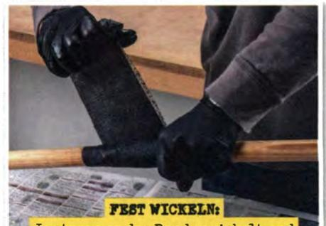
**FEST WICKELN:** Je strammer das Band gewickelt und (zuletzt mit dem Vinylband) verdichtet wird, desto stabiler wird die Reparaturstelle.
