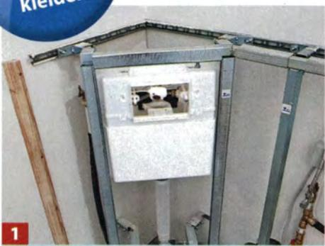
**1** Vorwand-Eckelement fürs WC setzen. Hier haben Hersteller bzw. Handel passende Module im Sortiment.
