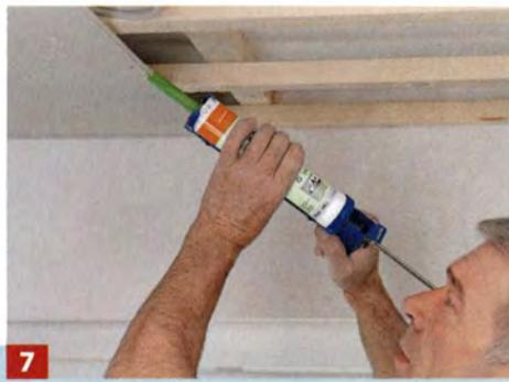
**7** Die Platten setzt man auf Stoß. Auf die Kante wird jeweils vorher ein Fugenkleber aufgetragen, hier *Fermacell greenline*.
