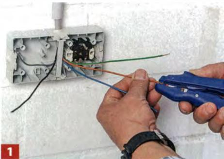
**1** Je nach anzuschließenden Geräten die Adern eventuell einkürzen. Adern abisolieren – bei Schraubverbindungen kürzer, für ...
