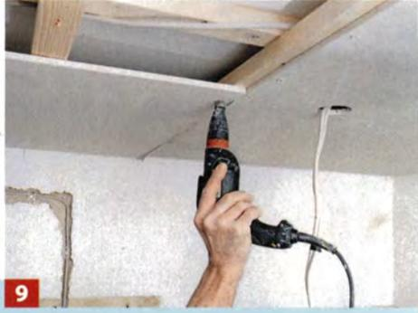
**9** Für 10- und 12,5-mm-Platten verwendet man 30 mm lange Schnellbauschrauben, bei 15 mm dicken Platten 40-mm-Schrauben.
