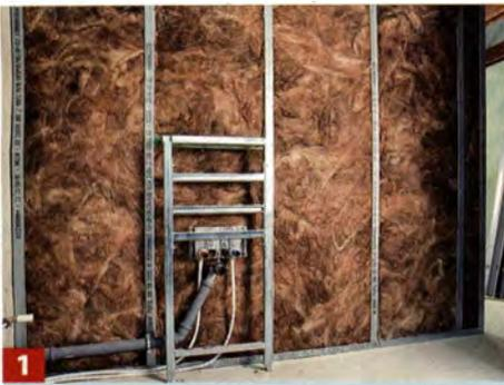
Um ein Vorwandmodul sicher an einer Leichtbauwand zu befestigen, ggf. noch imprägnierte Dachlatten quer setzen, ...
