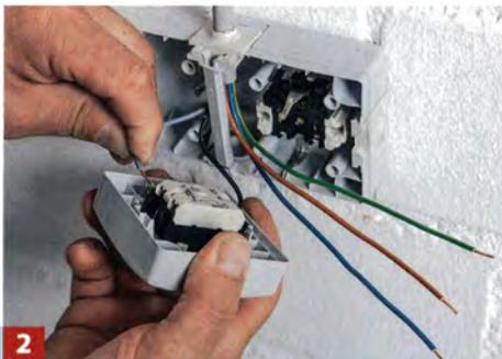
**2** ... Steckverbindungen etwas länger (rund 7 mm). Abisolierte Adern bis an die Isolation in die Steckklemmen einführen.
