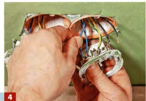
**4** ... daher in Hohlraum Dosen ausgeführt. Da bei uns die Einsätze gewechselt werden müssen, wurden alle Steckdosen demontiert.
