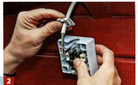
**2** Achten Sie bei der Montage auf eine dichte Verbindung zum Innengehäuse. Aufputzgehäuse verfügen über solche Dichtnippel.
