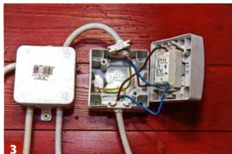
**3** Schalter nach aufgedrucktem Schaltplan anschließen. Für den Betrieb der Kontrollleuchte muss eine Phase angeschlossen werden.
