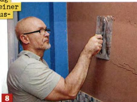
8 Den Kalkputz (Tadelakt) mit der Kelle in einer Schichtdicke von 1 bis 3 mm aufziehen. Eine zweite Schicht nach rund 2 Stunden.
