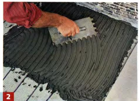
2 Fliesenkleber mit der geeigneten Zahnkelle abschnittsweise aufziehen.
