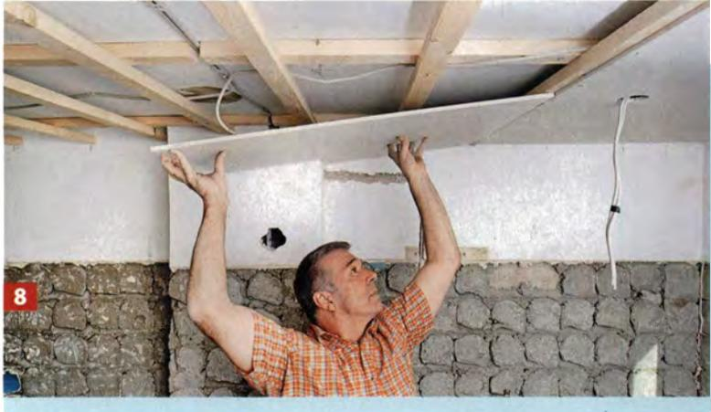
**8** Die Ein-Mann-Platte lässt sich auch über Kopf gut alleine ansetzen. Die Leitungen fortlaufend direkt durch die geschnittenen Plattenöffnungen ziehen.
