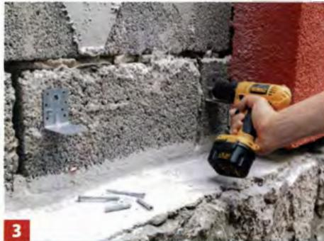
3 ... von Winkeln gekennzeichnet, an denen in diesem Fall die Querlattung montiert wurde. Die Winkel im Mauerwerk verdübeln.
