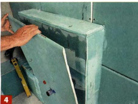
Damit alles dicht ist und ein solider Fliesengrund entsteht, beplanken Sie die Fläche doppelt.\*\* Fugen vorher beispachteln.
