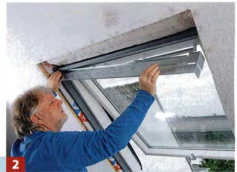
**2** ... noch weiter ausgeschnitten werden. Es folgt der Montagerahmen des Einbausets. Zunächst oben ein Querprofil einsetzen.
