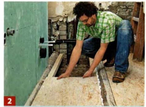
**2** ... Kanthölzer als Auflage für OSB-Platten. Diese auf Maß schneiden und bündig zur Balkenoberseite aufliegen.
