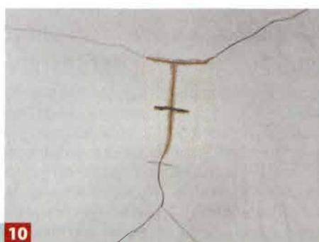
**10** ... Sie vorm Abbinden des Harzes Quarzsand darüber. Der Bodenbelag kann nun darauf verlegt werden, ohne dass er zu reißen droht.
