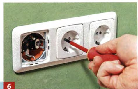
6 Steckdoseneinsätze ausrichten und mit den Geräteschrauben am Rand der Dosen befestigen. Rahmen und Blenden montieren.
