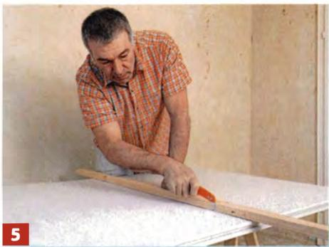
**5** Gerade Zuschnitte gelingen gut mit einem speziellen Plattenreißer\*, den man entlang einer Holz- oder Metallschiene führt.
