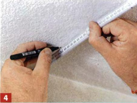
**4** Übertragen Sie nun die ermittelten Bohrlochabstände sehr genau an die Decke.
