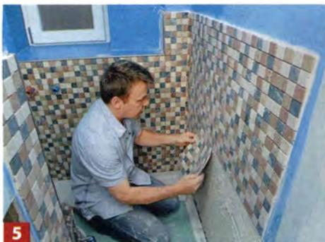
5 Vom Höhenriss aus die Matten nach unten verlegen. Zuschnitte zur Wanne hin erfolgen mit Fliesenbrechzange; Gewebe mit ...
