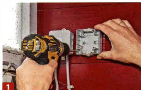
**1** Schalter demontieren, Gehäuseboden an gewünschter Position befestigen. Zuleitung von der Steckdose und Anschlussleitung ...
