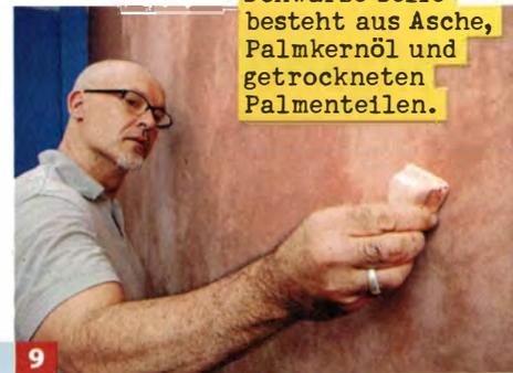
9 Hat der Putz angezogen, wird er mit einem Stein poliert und verdichtet (im Spritzwasserbereich mit Schwarzer Seife polieren).
