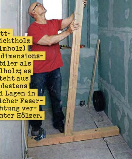
Brettschichtholz (Leimholz) ist dimensionsstabiler als Vollholz; es besteht aus mindestens drei Lagen in gleicher Faserichtung verleimter Hölzer.
