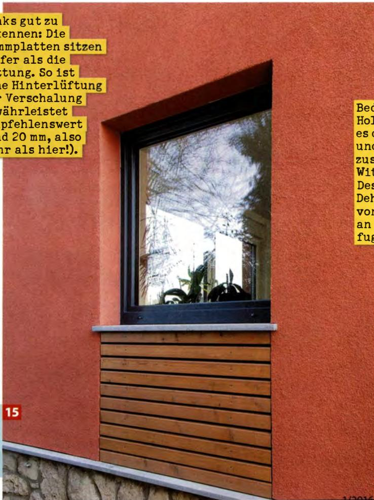
Bedenken Sie: Holz arbeitet, es dehnt sich aus und zieht sich zusammen, je nach Witterung. Deshalb stets Dehnungsfugen von etwa 10 mm an allen Anschlussfugen einplanen.
