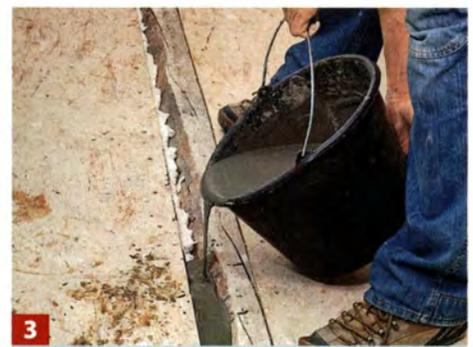
**3** Kleine Risse mit Acryl verschließen, größere Hohlstellen mit kunststoffvergüteter Ausgleichsmasse ausgießen.
