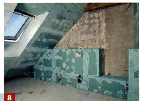
... Mal beispachteln, bis eine glatte Fläche entsteht. Nach Trocknung alles mit Tiefengrund behandeln.
