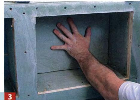
**3** Die Rückwände mit Gipsplatten bekleben (mit Ansetzbinder oder Montagekleber), Fliesenprofile setzen und Fliesen verlegen.
