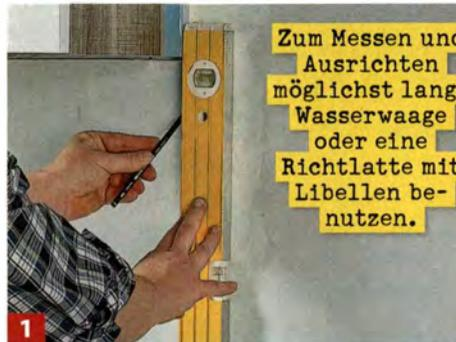
Zum Messen und Ausrichten möglichst lange Wasserwaage oder eine Richtlatte mit Libellen benutzen.
