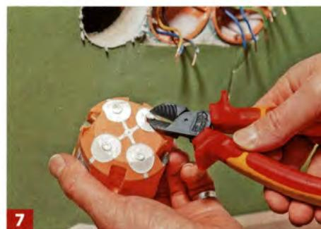
**7** An der Hohlraumdose eine der für die Durchführung der Zuleitung vorgesehenen Aussparungen öffnen und beim ...
