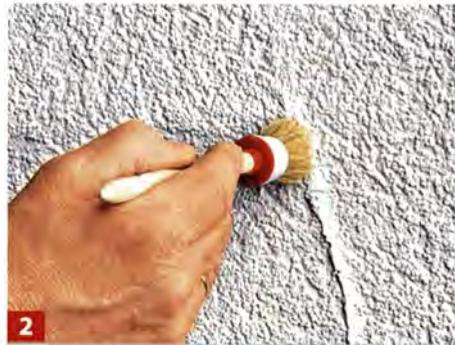
2 Die frisch aufgetragene Dichtmasse dann mit einem Pinsel der Putzstruktur anpassen.
