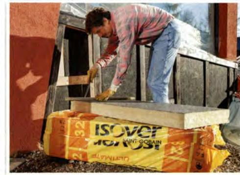
*Fassaden-Dämmplatte-035*. Es ist flexibel und gleicht so Unebenheiten des Untergrunds aus. Eine Hinterströmung wird so vermieden. Am Anbau verwendete der Bauherr *Isover Ultimate Kontur FSP-032*, eine Fassadendämmplatte, die sich gut zur direkten Montage auf Holzständerwänden eignet. Die Platten sind wasserabweisend – wichtig bei einer Verschalung mit offenen Fugen.
