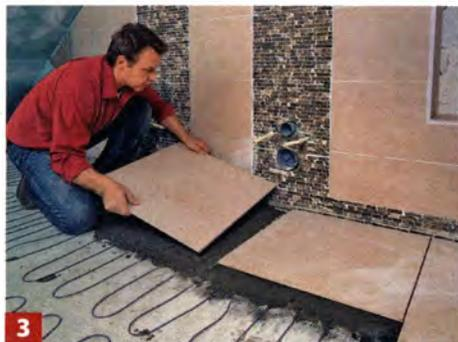
3 Auf dem Boden wurden 90 x 90 cm große Feinsteinzeugfliesen verlegt, hier auf einer elektrischen Fußbodenheizung.
