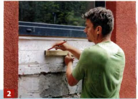
2 Den Zwischenraum für den Zuschnitt der Lattung ausmessen. Hier wurden dann noch Bohrpunkte zur Montage ...
