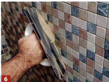
6 ... Schere durchtrennen. Nach frühestens 3 Std. wird verfugt. Den Natursteinfugenmörtel mit Fuggummi oder Moosgummibrett einbringen.
