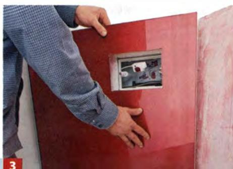
**3** Darüber wird die Acrylglasplatte mit geeignetem Montagekleber gesetzt. Bei Zu- und Ausschnitten Schnittstelle kühlen!
