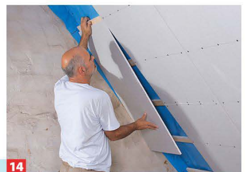
14 Platte dann mit Fuge zum Giebel hin verschrauben. Untereinander setzt man die Platten auf Stoß.
