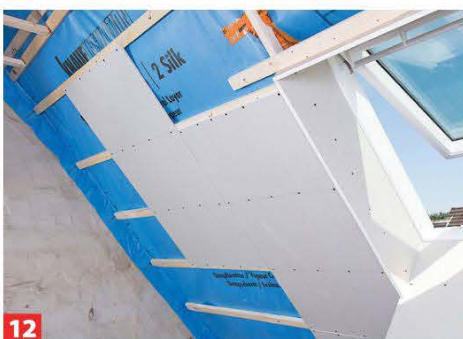
12 Vermeiden Sie Kreuzfugen und achten Sie darauf, dass möglichst immer die längeren Plattenkanten auf der Lattung aufliegen.
