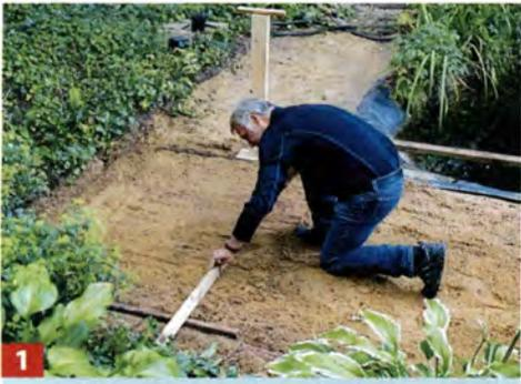
**1** Die Fläche um den Teich mit Sand nivellieren und verdichten, dann glatt abziehen mit leichtem Gefälle (1 bis 2%) zum Teich.
