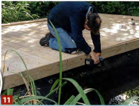
**11** Anschließend das Blendbrett mit der Unterkonstruktion verbinden.
