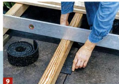
**9** Kontrollieren Sie das Gefälle. Mit Gummipads in unterschiedlichen Stärken können Sie die Balken unterfüttern.
