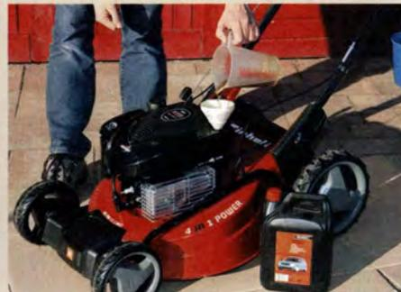
**MOTORENÖL** der vorgeschriebenen Spezifikation einfüllen (gemäß der Anleitung). Unbedingt richtige Füllmenge abmessen!
