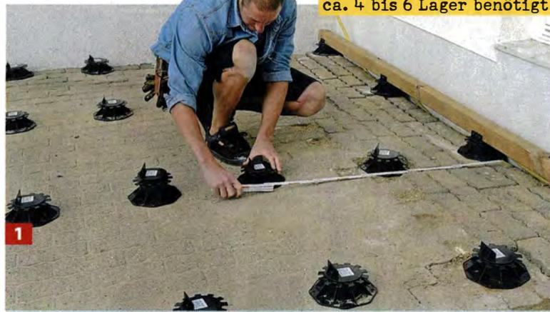
Die Terrassenlager werden auf der gesamten Fläche verteilt, beginnend an der Hauswand. Mit ihnen können Sie die Höhe bzw. das Gefälle des Belags regulieren (60 bis 140 mm).
