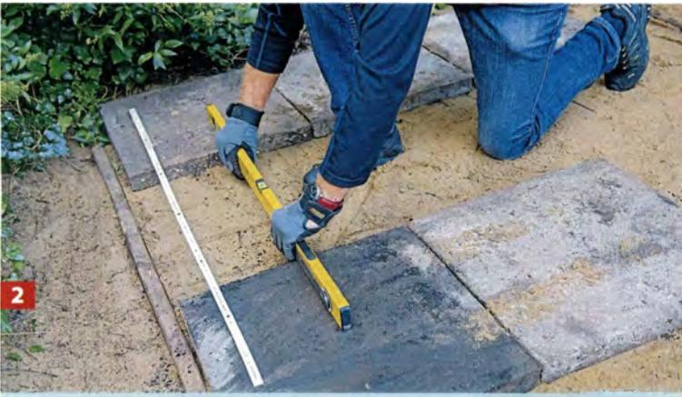
**2** Als Auflager für die Unterkonstruktion dienen Gehwegplatten. Diese in Reihe mit ca. 40 cm Abstand auslegen. Das Gefälle kontrollieren.
