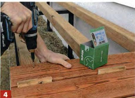
4 Die Dielen werden zugeschnitten und nach dem gleichen Prinzip wie bei der Terrasse verlegt und verschraubt.
