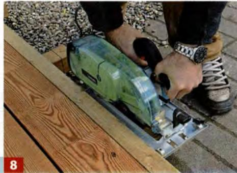
**8** Überstehende Balkenteile werden mit der Handkreissäge abgelängt. Eine Hilfsleiste dient als Anschlag.
