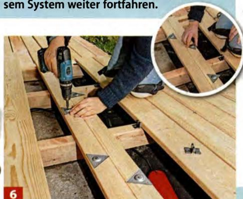
**6** Die herausnehmbare Diele von unten mit Dreieckselementen versehen. Diese mit einer Spitze (Detail) unter das vorherige Brett ...
