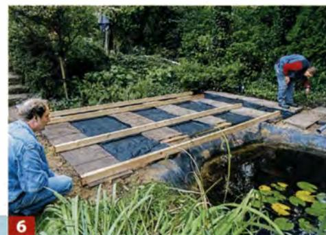
**6** Die Balken der Unterkonstruktion zuschneiden und auslegen. Das Gefälle in Dielenlauf-richtung beachten!
