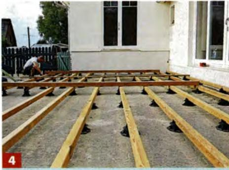
**4** Tipp: Um die Terrassenlager gleichmäßig auszurichten, legen Sie einfach einen weiteren Balken der Unterkonstruktion auf.
