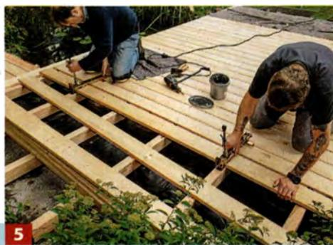
**5** ... das Holz in die Klammern pressen und diese mit den Balken verschrauben. Mit diesem System weiter fortfahren.
