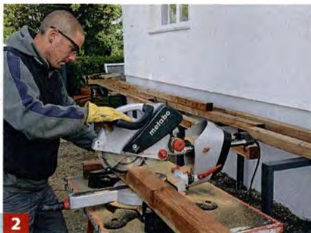
2 Schneiden Sie die Unterkonstruktionsbalken zu. Diese verlaufen parallel zur Hauswand. Die U-Profile sind vorgebohrt.
