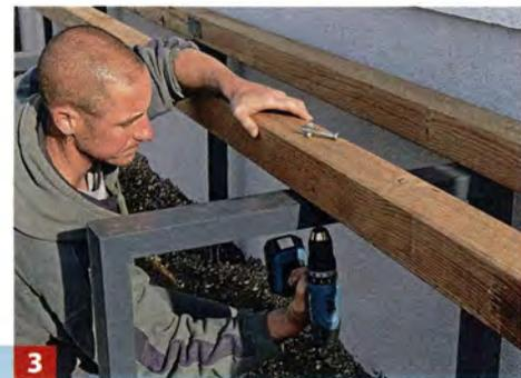
3 Balken ebenfalls vobohren. Ein Gummipad dazwischenlegen und beide Elemente mit Schlüsselschrauben verbinden.
