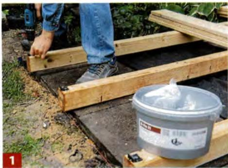
**1** Vor dem Befestigen der ersten Diele wird zuerst die spezielle Randklammer am jeweiligen Balkenende befestigt.
