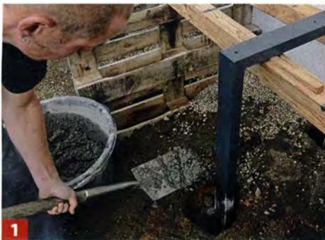
1 Die Träger (800 mm breit, 1300 mm hoch) werden ca. 600 mm tief einbetoniert und im Abstand von 1,5 bis 2 m aufgestellt.
