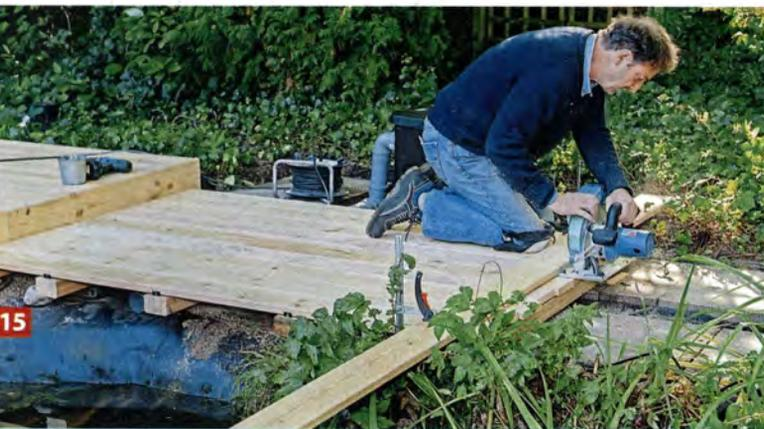
**15** Hier ebenso die Überstände am Rand mit der Handkreissäge abhängen.
