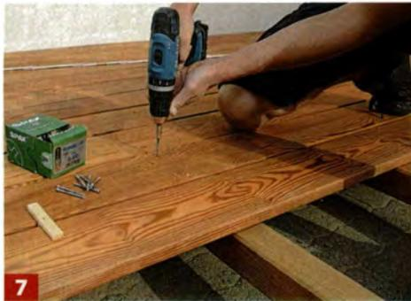
**7** ... verwendet. Anschließend können Sie die Dielen mit Edelstahlschrauben mit den Balken verbinden.
