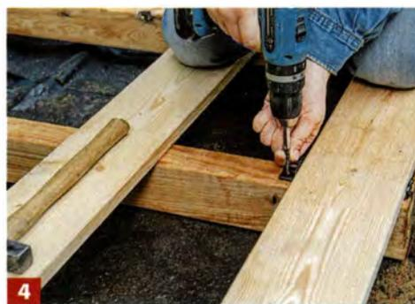
**4** Die Klammern mit der Unterkonstruktion verschrauben. Nächstes Brett anlegen, mit dem Verlegegerät auf beiden Seiten ...
