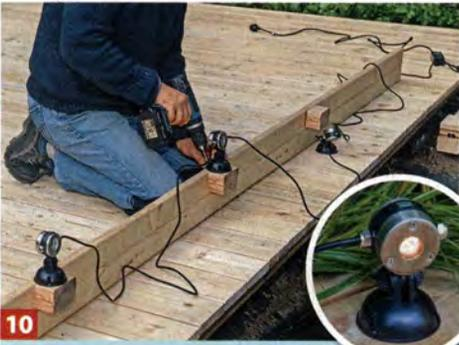
**10** Mit Holzklötzen werden die Lampen (für den Einsatz am Teich geeignet!) kopfüber an der Verblendung befestigt.
