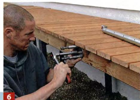
6 Geländermontage: Zuerst wird die Montageplatte an der Unterkonstruktion angeschraubt.
