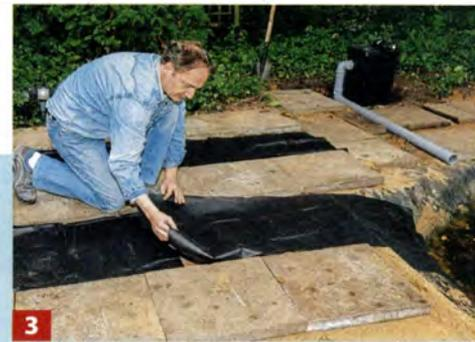
**3** Die Zwischenräume werden mit fester Folie abgedeckt, um möglichen Unkrautwuchs zu unterdrücken.
