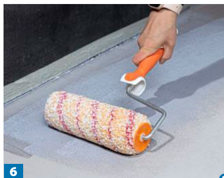
6 Am Boden dann drei Schichten Versiegelung auftragen; Trocknungszeiten von je vier Stunden berücksichtigen!
