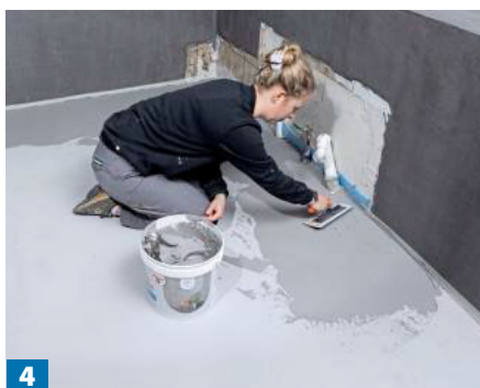
4 Nach sechs, besser noch acht Stunden Trocknung die zweite Lage aufziehen. Ist auch diese Lage ...
