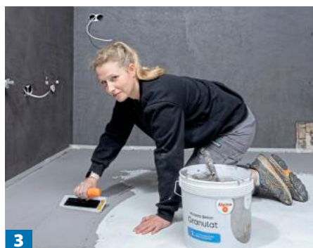
3 Das angemischte Granulat mit der Alpina Effekt-Kelle in einer Schichtstärke von 1 bis 3 mm aufziehen.
