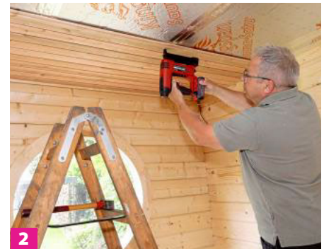
2 Die Bretter für die Deckenverkleidung werden mithilfe eines Akku-Naglers montiert.
