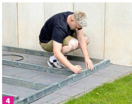
4 Überprüfen Sie, ob die Längsbalken im gleichen Abstand zueinander im Inneren des Grundrahmens liegen.
