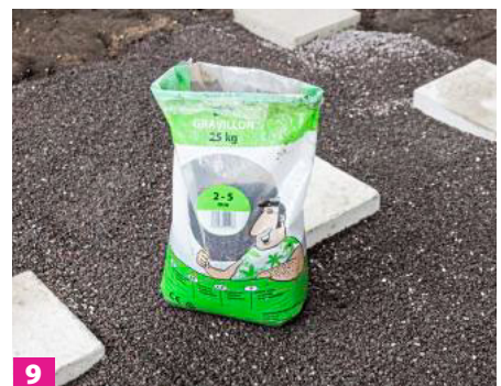
9 Die Zwischenräume dann gut verdichten und mit Splitt auffüllen.
