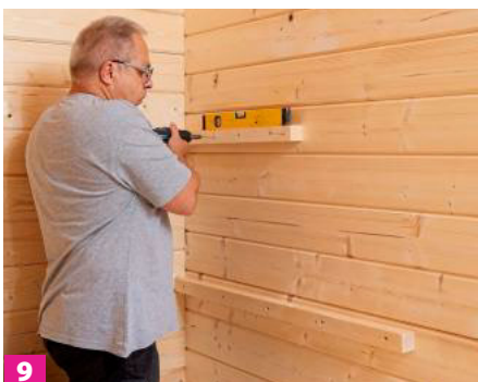
9 Achten Sie darauf, dass das Ganze korrekt ausgerichtet ist.
