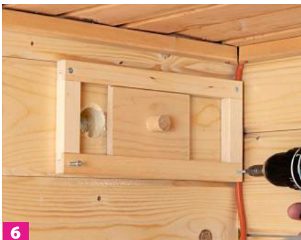
6 Anschließend wird der Lüftungsschieber darüber montiert.
