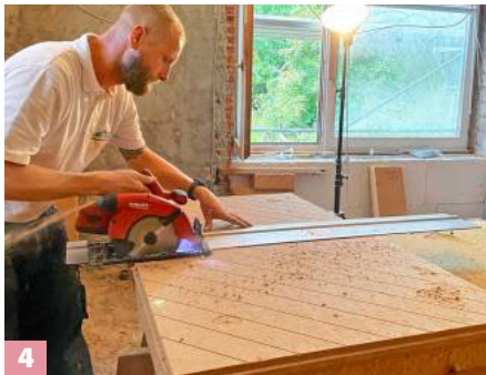
4 Die 80 bis 200 mm dicken Platten lassen sich gut mit Handkreis- oder Stichsäge schneiden, für Leitungen kann ...
