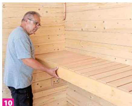
10 Nun können die Sitzbankelemente auf die Leisten gesetzt werden.
