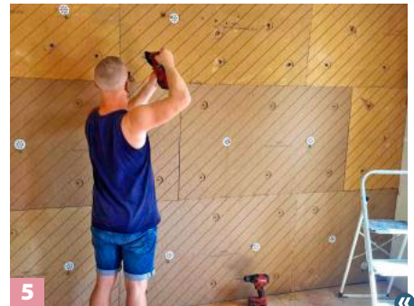
5 ... man Stellen ausfräsen. Dann mit UdiMULTIGRUND und eingelegtem Gewebe mindestens 4 mm dick verputzen.
