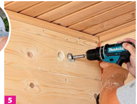
5 ... ist vorab auf Gehrung zu schneiden. Mit einem Forstnerbohrer werden zwei Lüftungslöcher gebohrt.
