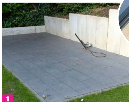
1 Als Untergrund für das Saunahaus dient ein zuvor selbst verlegtes Fundament aus Terrassenplatten.
