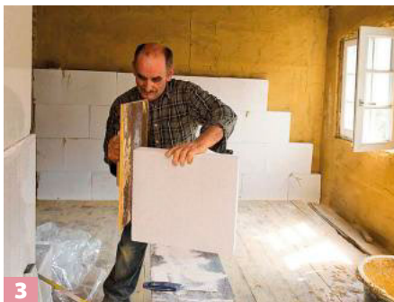
3 Passstücke mit dem Fuchsschwanz zugsägen. Das Material lässt sich auch gut mit einem Schleifbrett anpassen.
