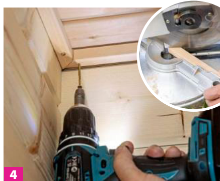
4 ... angeschlossen. Für eine schönere Optik wird eine Zierleiste an der Deckenverkleidung angebracht. Diese ...
