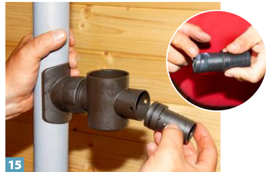
12 Die Fallrohrteile zusammenstecken. Wegen der Einstecktiefe werden keine Dichtungen benötigt.
