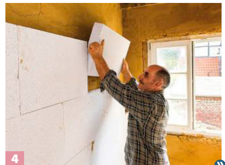
4 Die Platten mit leichtem Druck „einschwimmen“ und dicht aneinander setzen. Die Fugen nicht verkleben!
