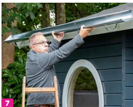
7 An beiden Seiten des Dachs wird an den traufseitigen Blindbrettern eine Regenrinne installiert.
