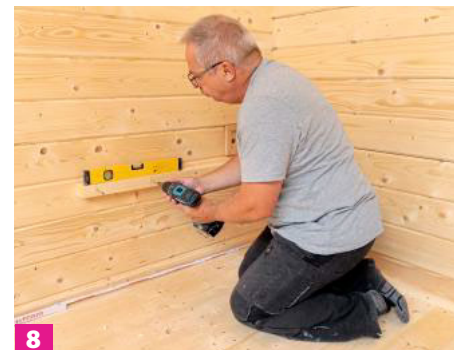
8 Anschließend können Sie die Holzleisten an die Wände schrauben.
