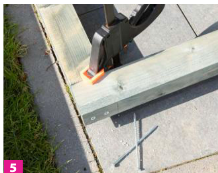
5 Ist alles korrekt ausgerichtet, können die Hölzer des Grundrahmens miteinander verschraubt werden.
