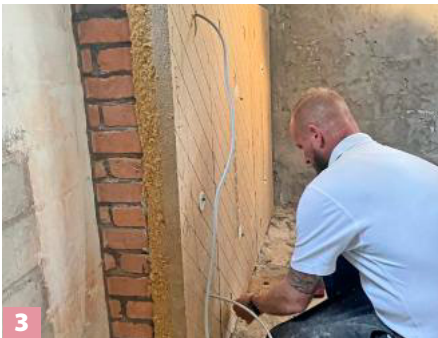
3 ... der Rückholverschluss einrastet und der Dübel plan zur Oberfläche liegt. Die Platte sitzt nun dicht an der Wand.
