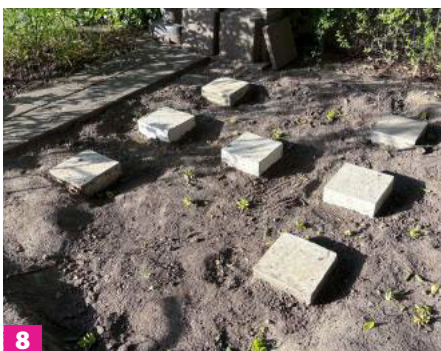
8 ... Kanthölzer, die als Schwellen die unterste Lage bilden. In unserem Fall wurden sieben Fundamente gegossen.
