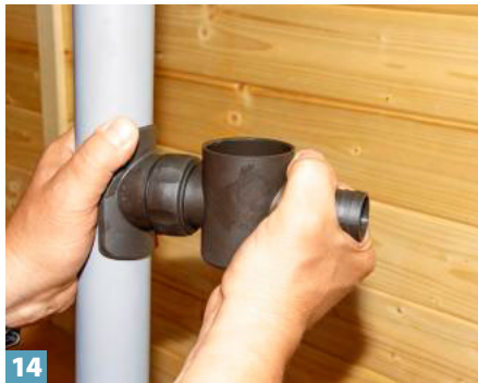
11 ... und beides in den Rohrausschnitt einrasten lassen. Die Dichtung des Regensammlers am Tank einsetzen.
