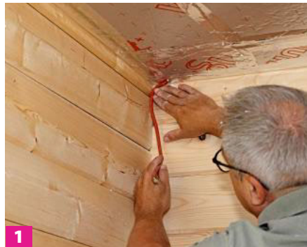
1 Zuerst wird die Stromleitung für die Innenbeleuchtung im Saunaraum verlegt.
