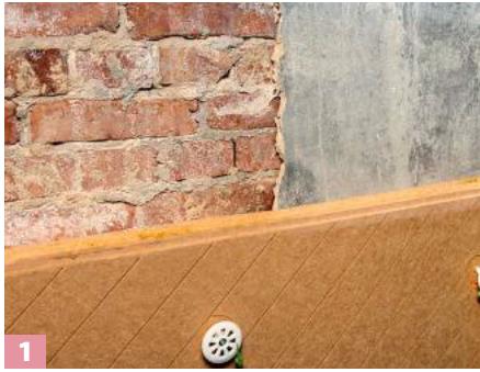
1 Pro UdiIN-RECO-Dämmplatte mindestens acht Stelldübel setzen (UdiMONTAGE SDM RECO; auf Fachwerk ...
