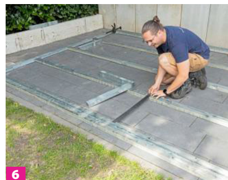
6 Anschließend setzen Sie die Querbalken in den Grundrahmen ein – an die Position, wo die Wand für die ...
