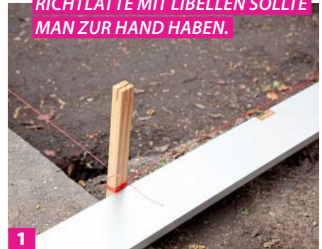
1 Spannen Sie den Grundriss mit einer Fluchtschnur exakt ab.
