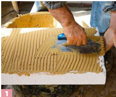
1 Die Multipor-Platten werden innen mit Leicht- und im Fachwerk mit Lehmörtel verklebt.
