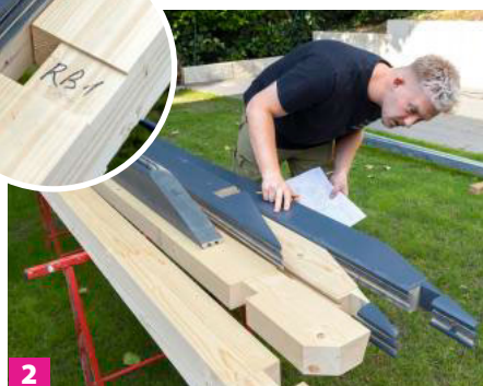
2 Bevor es an den Aufbau geht, sind die einzelnen Elemente zu sortieren und auf Vollständigkeit zu prüfen.
