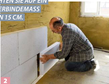
2 12-mm-Zahnkelle verwenden, Steghöhe des Mörtels mindestens 8 mm. Die Platten dann im Versatz verkleben.
