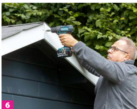
6 Am Giebel werden ebenfalls Blindbretter angebracht.
