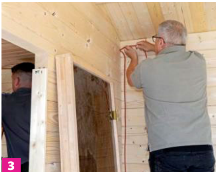
3 Weitere Leitungen werden in den Vorraum gelegt. Neben der Beleuchtung wird u. a. auch das Steuergerät ...
