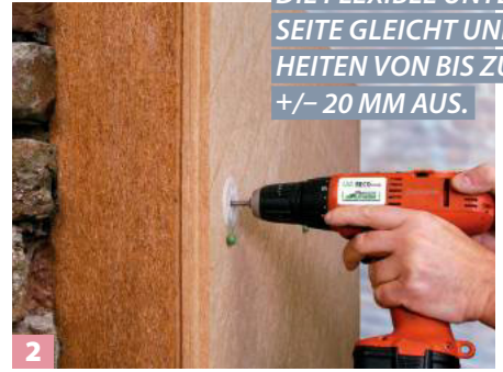
2 ... UdiMONTAGE SDH RECO). Mit 8 mm vorbohren, Dübelteller mit Schraube ansetzen, dann einschrauben, bis ...
