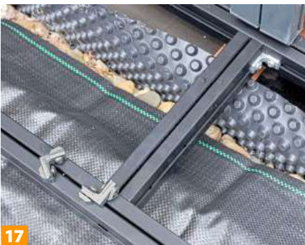
14 Querverstrebungen sorgen für Verwindungssteifigkeit. Um diese im 90-Grad-Winkel setzen zu können, montiert ...
