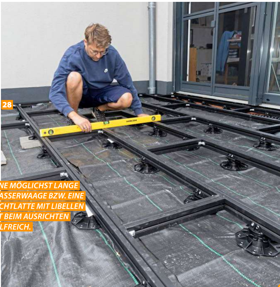
25 In einer Ecke planen Sie das Gefälle am besten diagonal ein. Mit einem 4-m-Profil und einer Wasserwaage lässt ...
