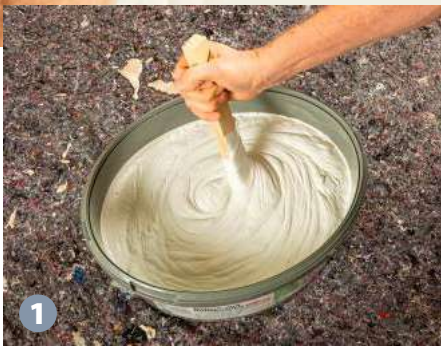
1 Vor der Verarbeitung gut aufrühren, bis eine cremige Konsistenz entsteht.
