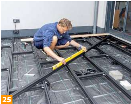
22 Abschließend das Längsprofil der anderen Kopfseite verlegen und mit Eckverbindern befestigen.
