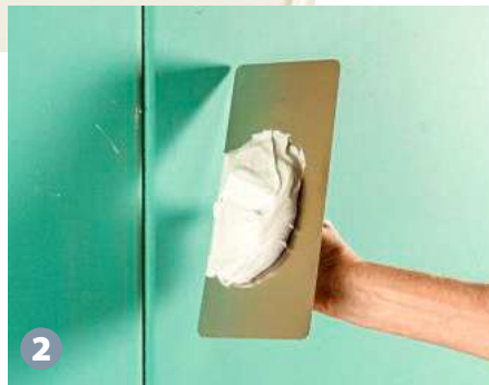
2 Die Spachtelmasse z. B. mit einer Glättkelle aufziehen, bei Dicken über 4 mm ...
