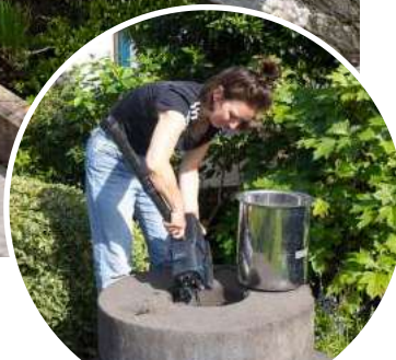
BRUNNENPUMPE MIT WASSERSPIEL AUSTAUSCHEN.
