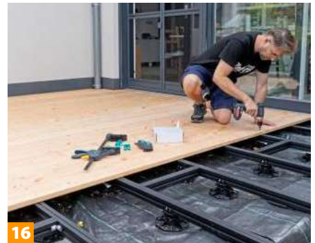
13 ... man auch nach oben: Hier sitzt der Dielenabschnitt sehr knapp zwischen Führung und Unterkonstruktion.
