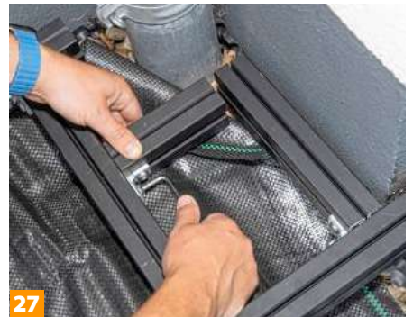
24 Hier wurden jetzt nach und nach alle Stellfüße gesetzt – alle 50 cm sollte ein Auflagepunkt liegen.
