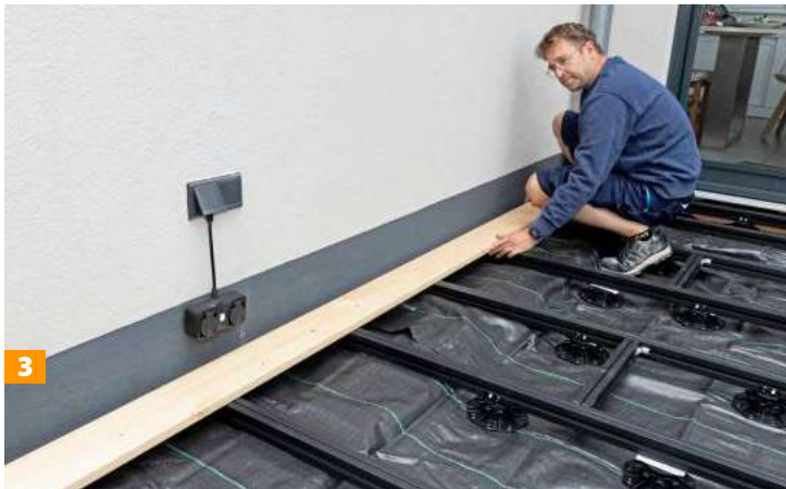
1 Beginnen Sie die Verlegung an der Hauswand und messen die nötige Dielenlänge ab.
