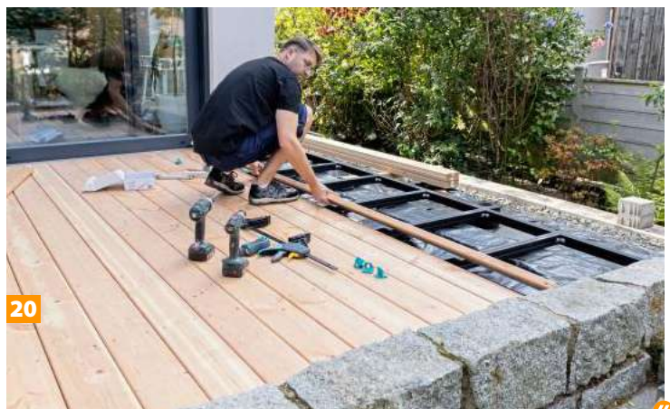
Sind die Abstandhalter gesetzt, die Montagezwinde an zwei Ende ansetzen und die Dielen zusammenziehen.
