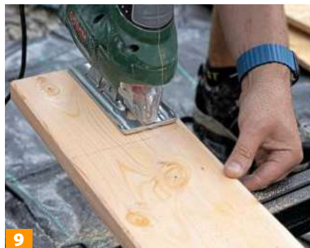
Für Eckzuschnitte am besten eine Stichsäge verwenden.
