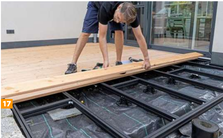
14 Weitere Dielen auflegen und ausrichten. Die Abstandhalter etwa alle 100 cm setzen.
