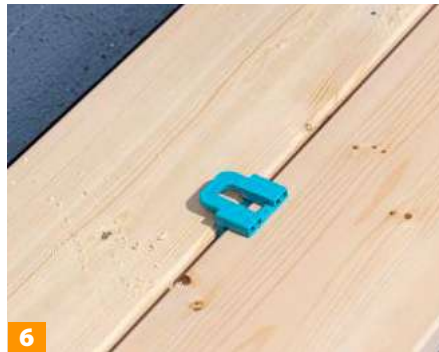
Dann die nächste Diele mit 3 mm Abstand setzen. Praktisch: Das Wolfcraft Terrassenbau-Set mit Abstandhaltern, ...
