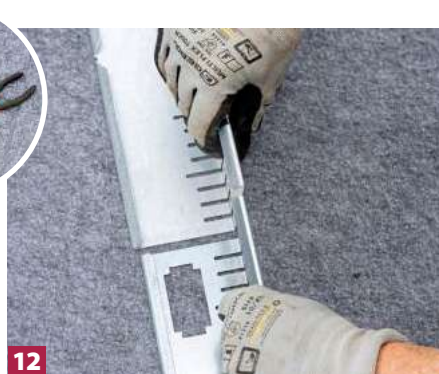
9 Für die Ecken gibt es Eckverbinder-Profile. Hier müssen kleine Ausschnitte vorgenommen werden.
