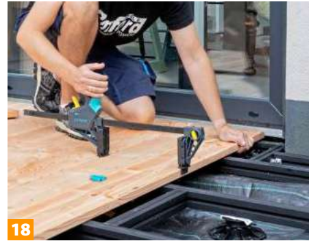
Sind die Abstandhalter gesetzt, die Montagezwinde an zwei Ende ansetzen und die Dielen zusammenziehen.
