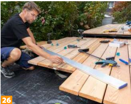
23 Die Dielen kürzen Sie erst nur grob rechtwinklig und verschrauben sie mit Überstand nach vorne.
