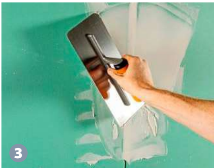
3 ... oder Fugen in mehreren Lagen. Untere Lagen 48 Stunden trocknen lassen!
