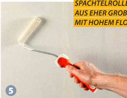
5 ... und mit der Kelle glätten. Auch der Auftrag per Airless-Spritzgerät ist möglich.
