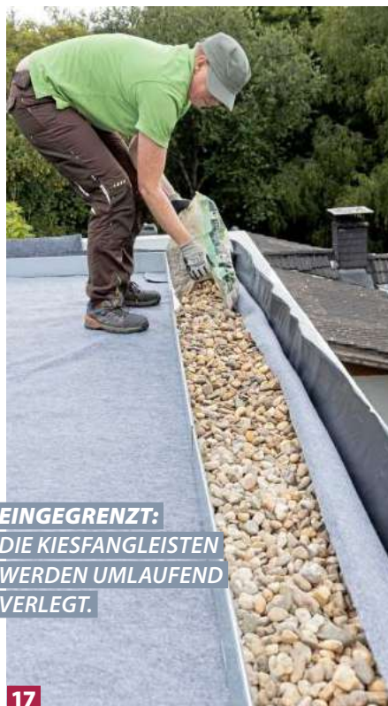
17 ... Folienuntergrund kleben. Zwischen Dachkante und Kiesfangleiste rund 5 cm hoch Kies einfüllen ...
