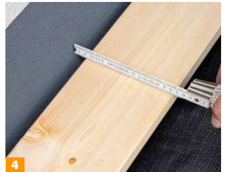
Hier hat man sogar 20 mm Abstand zur Wand vorgesehen – besser mehr als zu wenig einplanen!
