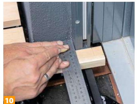
Muss man Bauteile wie Rollladenführungen aussparen, sollte auch das nicht zu knapp bemessen werden.
