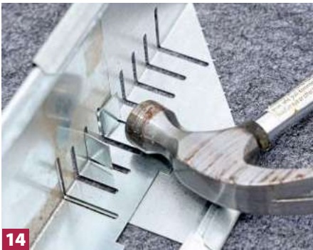
11 Auch am Schenkel trennt man ein Stück Metall heraus.
