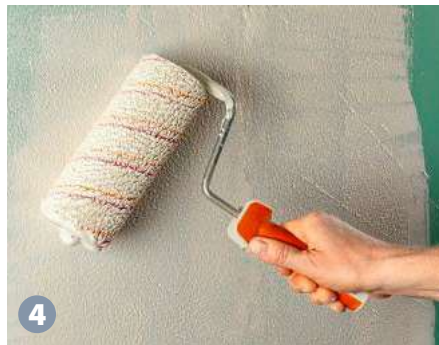
4 Alternativ mit einer angefeuchteten Spachtelrolle ca. 4 mm dick auftragen ...
