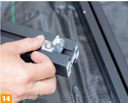
11 Das Profil wird mit zwei Schrauben an den Stellfüßen befestigt. Verwenden Sie nur Edelstahlschrauben!
