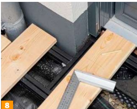
Zuschnitte über Eck mit dem Winkelmaß anzeichnen. Auch hier wieder mind. 15 mm Dehnungsfuge vorsehen.
