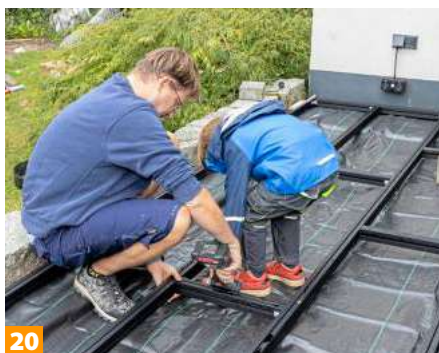
18 ... und mit den Eckverbindern montieren. Um die weiteren Profile verlegen zu können, zunächst das Längsprofil an der Kopfseite platzieren.
