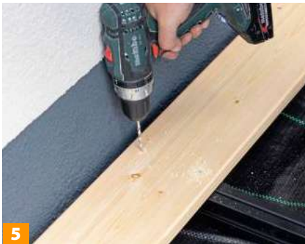
Bis in die Unterkonstruktion vorbohren und verschrauben, an beiden Seiten mit 20 mm Randabstand.
