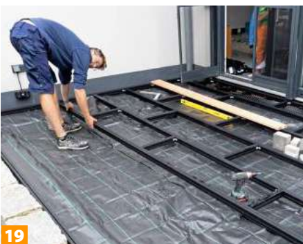
17 Auch der Abstand der Querverstrebungen sollte im Verlegeplan notiert sein. Die Profile entsprechend kürzen ...
