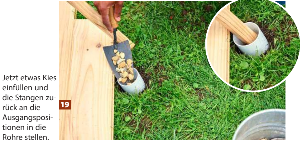
16 ... dann in der Mitte der Bodenplatte. Zum Schutz der Zeltstangen werden diese auf Kiesfundamente gesetzt.
