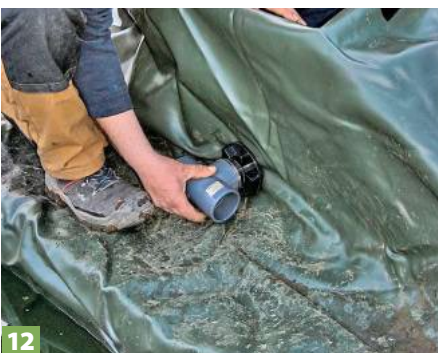
12 Am Rand ggf. einen Filter platzieren. Die Folie davor einschneiden, am Filterauslass ein T-Stück setzen und die ...
