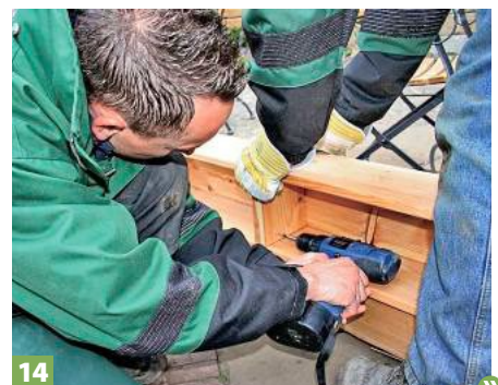
14 Die Holzkästen um die Schwimmzone, die später im Wasser liegen, wurden mit Edelstahl-Schrauben verbunden.
