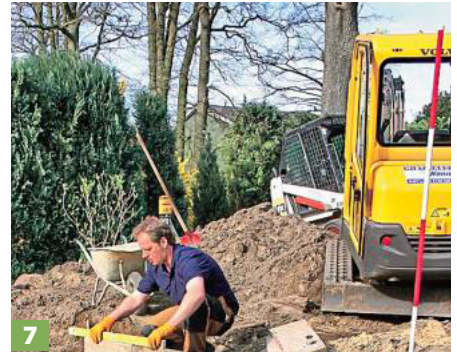
7 ALS TEICHKANTE UND KAPILLARSPERRE WURDEN GANZ AUSSEN HALBIERTE TERRASSENPLATTEN IN MÖRTEL GESETZT.
