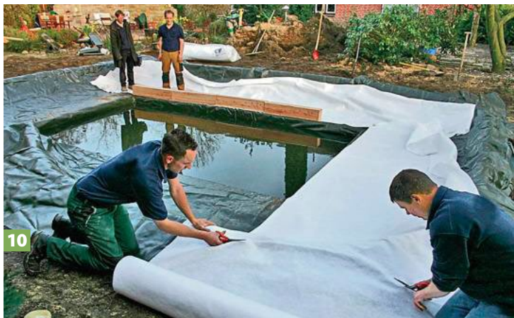
8 Das Vlies auch im Bereich der Regenerationszone auslegen, um die folgende Folie von unten zu schützen.
