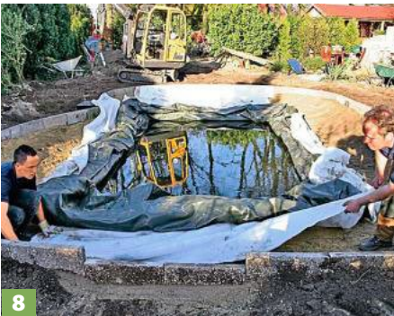
8 Das Vlies auch im Bereich der Regenerationszone auslegen, um die folgende Folie von unten zu schützen.
