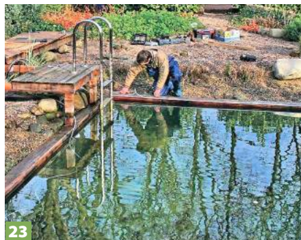
23 Die LED-Lichtleisten wurden hier in die Holzumrandung des Schwimmbereichs eingelassen.
