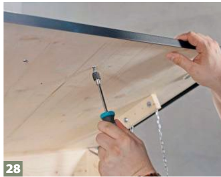
28 ... Blech ins Holz bohren. Anschließend den Griff von innen verschrauben.
