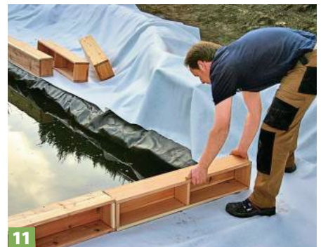
11 Die Badezone, die hier mit den Kunststoff-Wandelementen ausgebildet ist, wurde noch mit Holzkästen umrandet.
