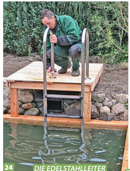
21 ... dass der Filter zugänglich bleibt und eine eventuelle Ein- und Ausstiegleiter gut daran montiert werden kann.
