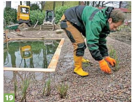
19 Während das Wasser einläuft, in die Kiesschicht wasserreinigende Sumpfpflanzen und Wasserpflanzen setzen.
