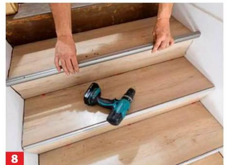
**8** Abschließend können die Abdeckprofile auf die Basisprofile geschraubt werden.
