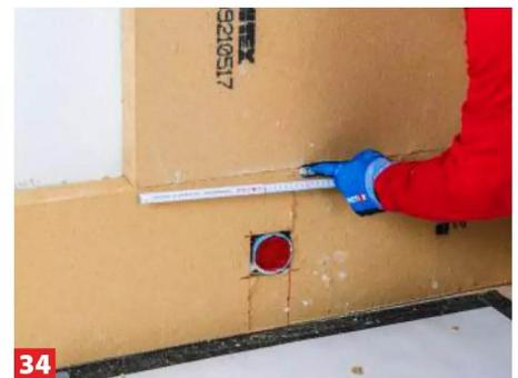
Setzen Sie die Dämmplatten mit mindestens 20 cm Versatz und richten sie im Kleberbett lotrecht aus.
