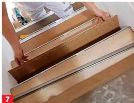
**7** ... Paneel pro Stufe. Berücksichtigen Sie beim Zuschchnitt, dass die Paneele ein Stück hinter die Profilkante gleiten.
