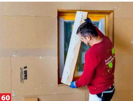
**60** ... verkleben. Außen schließen sie mit der Oberfläche der Wanddämmplatte ab, in der Laibung setzt man sie fugenfrei an ...
