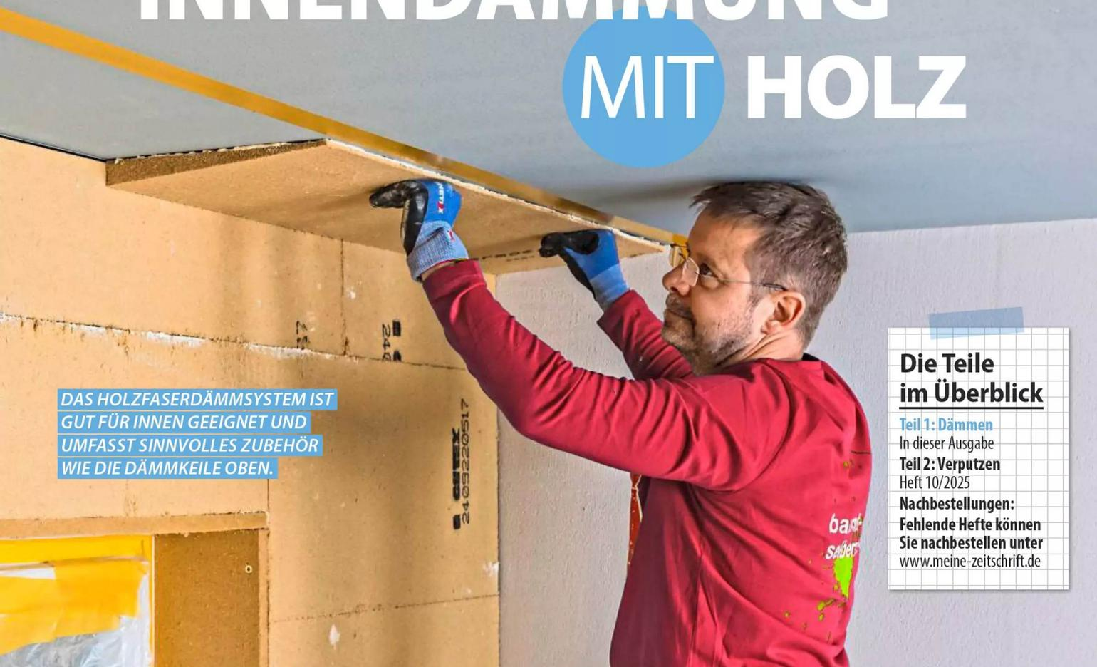
**DAS HOLZFASERDÄMMSYSTEM IST GUT FÜR INNEN GEEIGNET UND UMFASST SINNVOLLES ZUBEHÖR WIE DIE DÄMMKEILE OBEN.**
