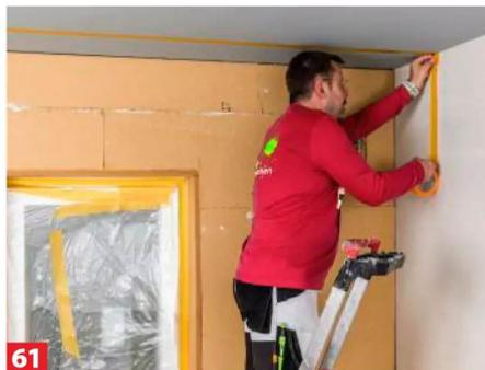
**61** ... die obere und untere Laibungsplatte. Um Wärmebrücken zu minimieren, unter die Decke noch Anschlusskeile kleben.
