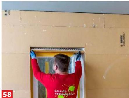
**58** Auch hier wieder Klebspachtel im hinteren und Montagekleber im vorderen Bereich einsetzen.
