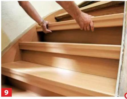
**9** Bei Treppenrenovierungssystemen umschließt das Trittstufen-Element die Trittkante und man benötigt kein Profil.
