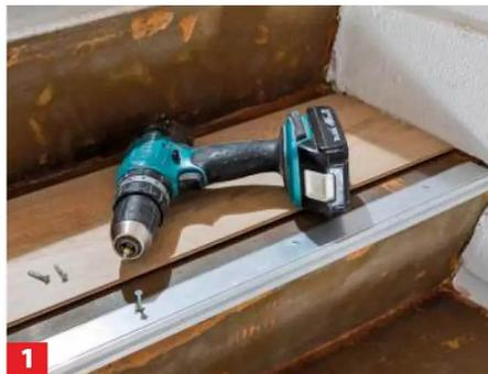
**1** Vorne auf der Trittstufe verschrauben Sie zunächst das Basisprofil des Treppenkantensystems, hier Küberit 320.
