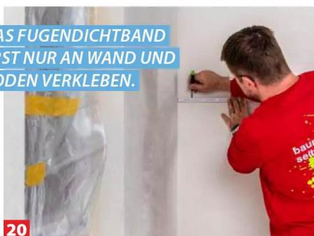
**20** Der Stoßbereich der Dämmplatten am Boden, an angrenzenden Wänden und an der Decke muss mit Kompriband ...
