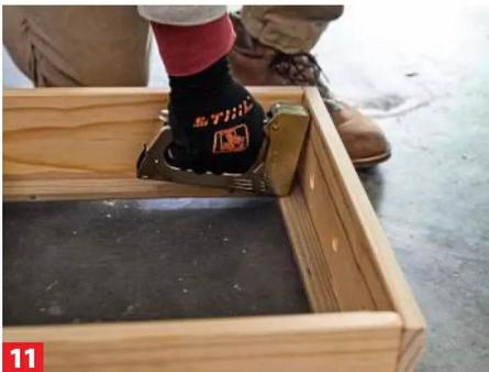
**11** Dann schneiden Sie passend für den inneren Rahmen der mittleren Box die Gaze zu und tackern sie fest.
