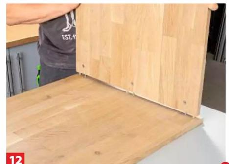
Dann setzen Sie die Wände probeweise auf (bzw. unter) die Arbeitsplatte.
