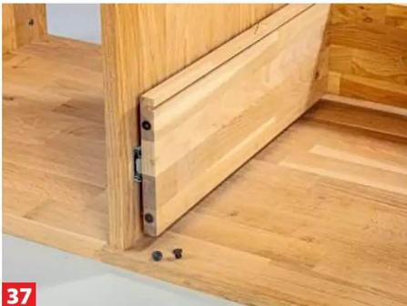
**37** Stecken Sie die Markierstifte in die vier Dübellöcher. Danach Sperrholz im gewünschten Spaltmaß (hier 5 mm) ...
