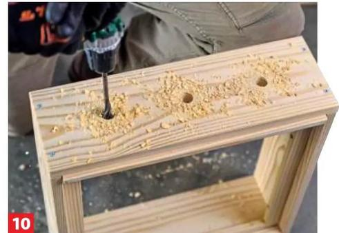
**10** Als Lüftungslöcher setzen Sie mit dem 19-mm-Forstnerbohrer auf jeder Längsseite eines Kastens 3 Bohrungen.
