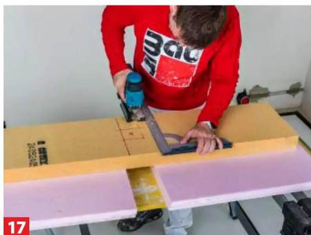
**17** ... unserer Innendämmdose erleichtert das Zuschneiden der Dämmplatte.
