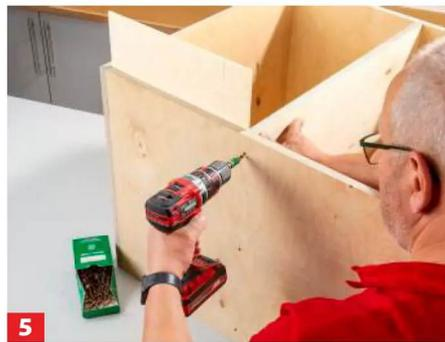
... und verschrauben Sie sie. Dann wird die Zwischenwand montiert. Sie springt hinter die Falzmaße zurück.
