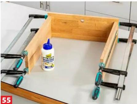
**55** Nun bauen Sie einen nach hinten offenen Schubkasten mit Frontplatte und (gefastem) Griffloch.
