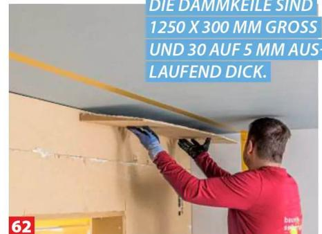
**62** Dazu den Bereich markieren, z.B. mit Kleband, und die Keile wie gehabt mit Klebspachtel ansetzen.
