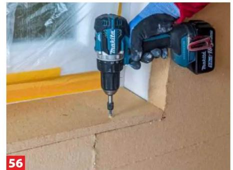
**56** ... der Trocknung zusätzlich mit Schrauben (z.B. 4,5 x 60 mm). Nach ca. 24 Stunden kann man diese wieder entfernen.
