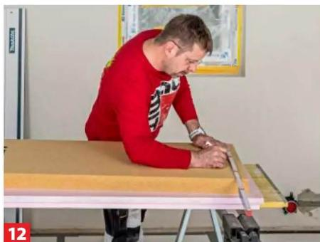
**12** Verlangt die erste Plattenreihe einen Zugschnitt, markieren Sie die Schnittlinie.
