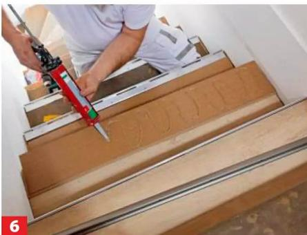
**6** ... Laminatpaneele übertragen. Für die Setzstufen ebenfalls Paneele zuschneiden und verkleben. Hier reichte ein ...
