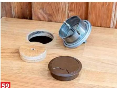
**59** Vor Ort haben wir für den Gasdruckminderer-Schlauch ein Loch geschnitten und eine Kabeldurchführung eingesteckt.
