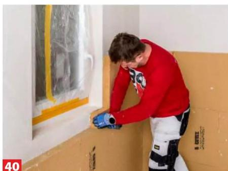
... Laibungsplatte von 5 bis 10 mm einkalkulieren und die Wandplatte mit einigen Millimetern Überstand verkleben.
