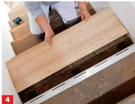
**4** Beide Paneele zusammenklicken und am Stück in den Kleber einlegen. Bei gewendelten Treppen muss man teils jede ...
