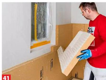
Auch über die nächste Ecke hinweg die Dämmplatte entsprechend zuschneiden und verkleben.
