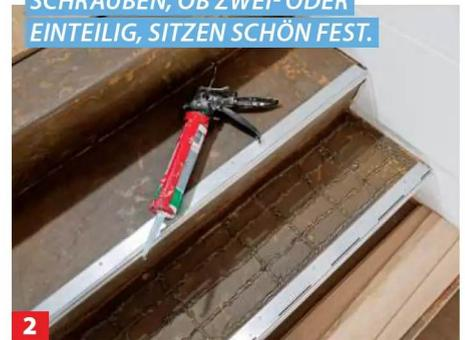
**2** Die Stufen dann vermessen, die Laminatpaneele passend zuschneiden und verkleben.
