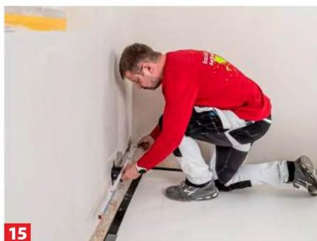
**15** An der gesetzten Dose muss die Dämmung ausgespart werden. Dazu in dem Bereich das Maß abnehmen ...
