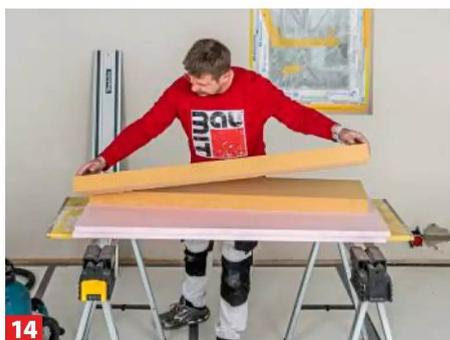
**14** Sauber und staubfrei gelingt der Schnitt, wenn man einen Werkstattsauger an die Säge anschließt.
