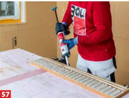
**57** Nach der unteren folgt die Verklebung der oberen Platte unterm Sturz.
