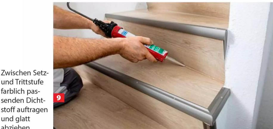
**9** Zwischen Setz- und Trittstufe farblich passenden Dichtstoff auftragen und glatt abziehen.
