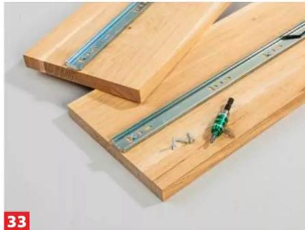
**33** Außen auf den Seitenzargen können Sie bereits jetzt die Schraubpositionen der Innenlauf-Auszugsschienen vorbohren.
