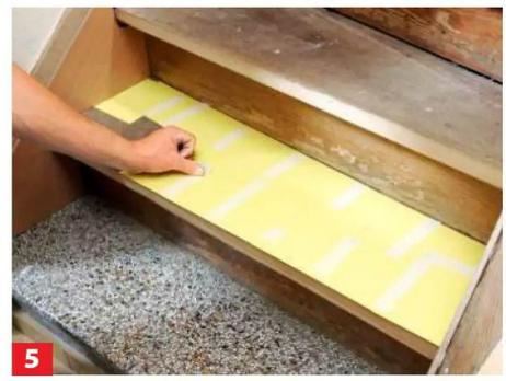
**5** ... empfehlen sich auch für die Tritt- und Setzstufen einzeln angefertigte Papierschablonen.
