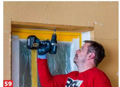
**59** Besonders unterm Sturz ist eine zusätzliche Verschraubung sinnvoll. Abschließend die seitlichen Laibungsplatten ...
