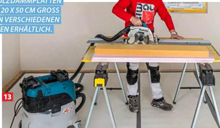
**13** Für gerade Zugschnitte von Holzfaserdämmplatten eignet sich eine Handkreissäge, am besten mit Führungsschiene.
