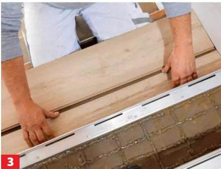
**3** **Tipp:** Das schmalere Paneel hinten in Richtung Setzstufe verkleben, das breitere nach vorne zur Trittkante.
