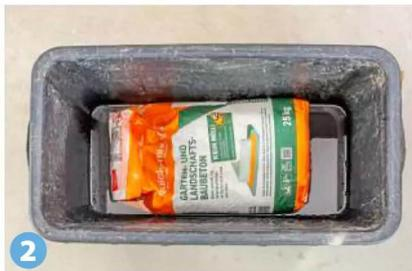
**2** ... mit Wasser benetzen (insgesamt rund 3 l Wasser) und kurz einwirken lassen.
