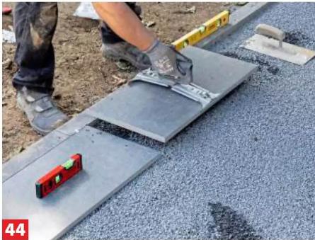
41 Steht das Verlegemuster fest (gleichmäßig/ungleichmäßig versetzt oder mit Kreuzfuge), setzen Sie die erste Platte.
