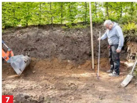
7 Der Hang muss steil abgetragen werden, unten am Fuß muss jedoch eine ebene Fläche auf Geländehöhe entstehen.
