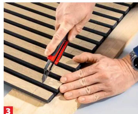
3 Schneiden Sie erst die Dekorschicht ein und dann das komplette Paneel durch.
