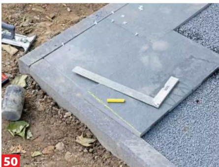
50 Nicht immer verläuft die Fläche rechtwinklig, gewölbt oder ungewölbt, und dann sind schmalere Zuschnitte fällig.
