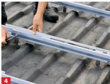
4 ... Modul – verschraubt man daran die Alumontageschienen, die man parallel zueinander ausrichtet. Sie sind in ...
