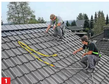
1 Anhand der Modulgröße die Montagepunkte der zur Eindeckung passenden Dachhaken im Sparrenverlauf markieren.
