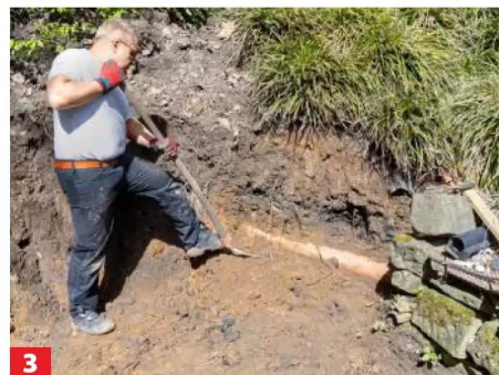
3 Vorsicht auch bei Leitungen, die noch in Betrieb sind – hier ggf. mit dem Spaten händisch Erde abtragen.
