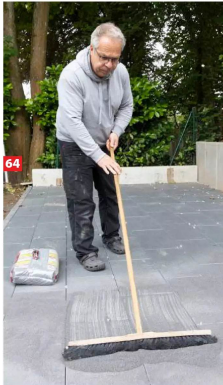
64 DIE PLATTEN KEINESFALLS ABRÜTTELN, SONDERN DIE FUGEN NACH EINIGEN TAGEN MEHRMALS NACHFÜLLEN.
