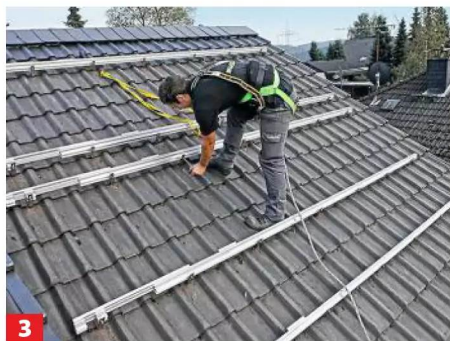
3 ... die Pfannen so ausschneiden, dass man sie wieder platzieren kann. Sind die Haken befestigt – ca. drei bis vier pro ...
