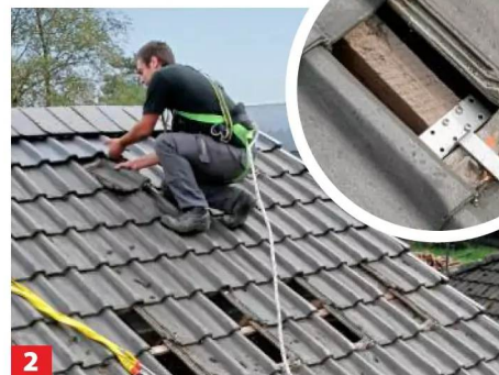
2 An diesen Stellen die Pfannen aufnehmen, die Haken an die Sparren schrauben und mit einer Diamantscheibe ...
