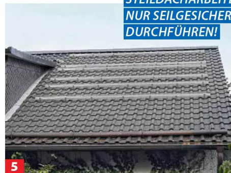
5 ... verschiedenen Längen erhältlich, können aber gekürzt oder mit Verbindern verlängert werden. Die DC-Solarkabel ...
