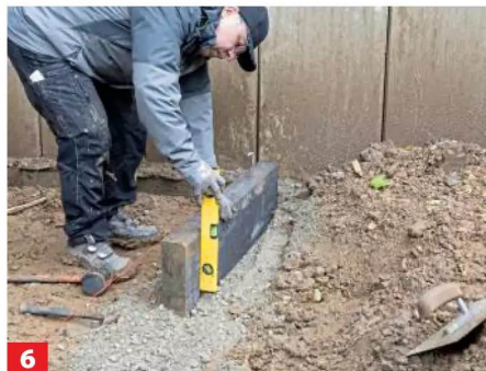
6 Einen Randstein in den Mörtel setzen und entsprechend der Fluchtschnur ausrichten. Unsere Randsteine haben ...
