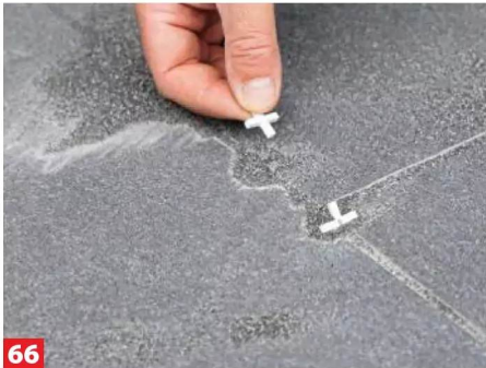
66 Fugenkreuze oder andere Abstandhalter im Laufe des Verlegens entfernen.
