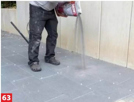
63 Empfohlen wird Edelsplitt in 1-3 oder 2-5 mm und kein Quarzsand, da er unten wegrieselt und Kratzer verursacht.
