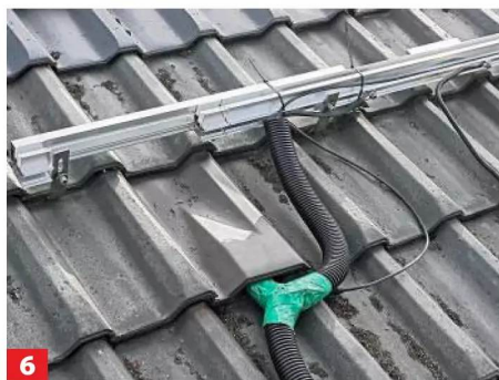
6 ... in die untere Nut der Schiene drücken und mit Kabelbindern fixieren. Dann an geeigneter Stelle über ein Leerrohr ...
