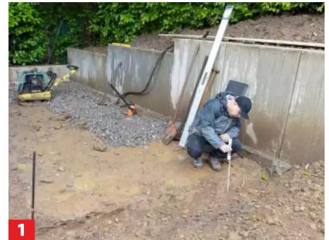
1 Das hier schon 30 bis 45 cm tief ausgekofferte Gelände abstecken und dabei auch die Oberkante der Belagshöhe festlegen.
