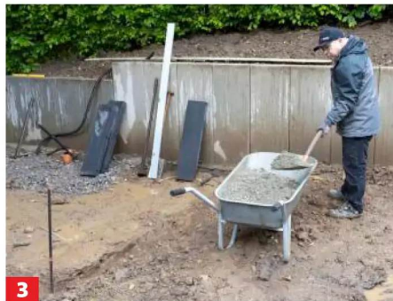
3 Hier wurden erst Randsteine verlegt, wofür Mörtel angerührt werden muss.
