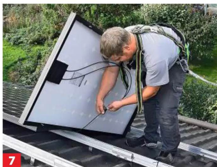
7 ... durchs Dach führen. Die Solarkabel an der Modulrückseite mit MC4-Steckern anschließen und alle Module verbinden.
