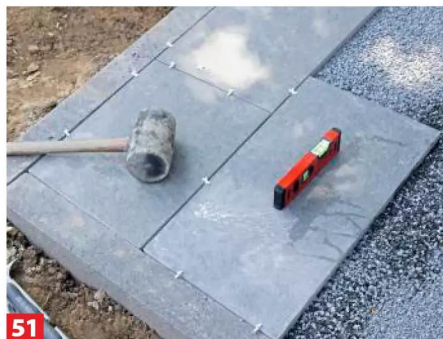
51 Die zugeschnittene Platte mit Abstandhalter auflegen und ausrichten. Hier beträgt der Plattenversatz etwa ein ...
