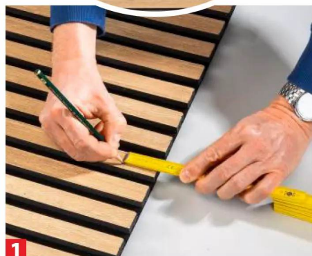
1 Muss man die Paneele kürzen, in gleichmäßigem Abstand entsprechende ...
