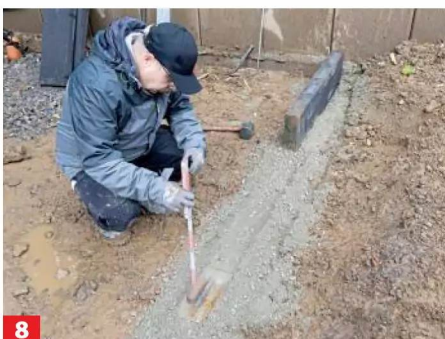
8 Mit einer Kelle kann man den Mörtelstreifen dort etwas eindücken und glatt ziehen, wo der Randstein gesetzt wird.
