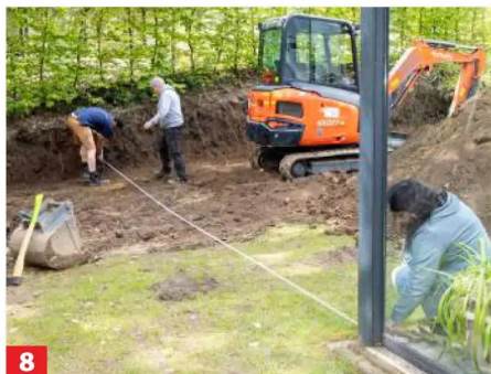
8 Mit Messungen vom Haus aus halten Sie die Grundstücksgrenze im Blick. Wichtig: Mehr als 1 m hohe Mauer-scheiben ...
