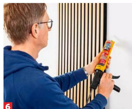
6 Alternativ kann man die Paneele mit Montagekleber auf Polymerbasis befestigen.
