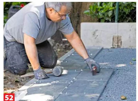
52 ... Drittel der Steinlänge – darauf ist dann im Folgenden stets zu achten, wenn der Versatz gleichmäßig ausfallen soll.
