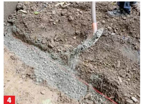
4 Heben Sie am Rand etwas Erde aus und legen Mörtelstreifen an.
