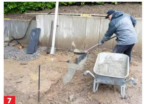
7 ... die Maße 8 x 25 x 100 cm. Weiteren Mörtel im Randbereich auftragen.
