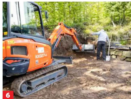
6 Mitunter ist es hilfreich, dem Baggerfahrer vorne an der Schaufel zu assistieren.
