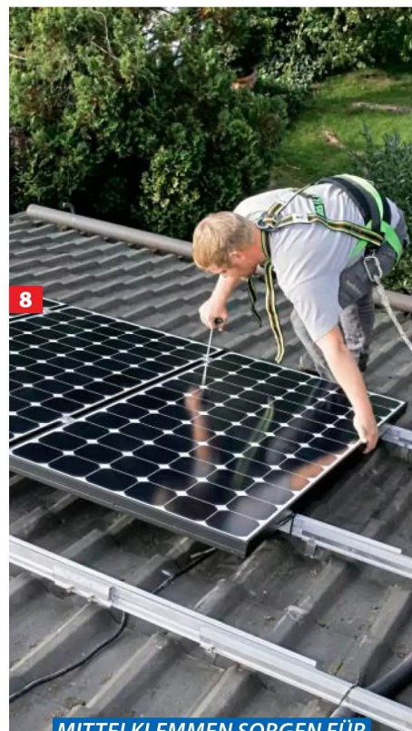
5 ... verschiedenen Längen erhältlich, können aber gekürzt oder mit Verbindern verlängert werden. Die DC-Solarkabel ...
