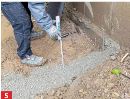
5 Dabei die Höhe der Randsteine bzw. der Terrasse berücksichtigen und die Mörtelhöhe an der Fluchtschnur kontrollieren.
