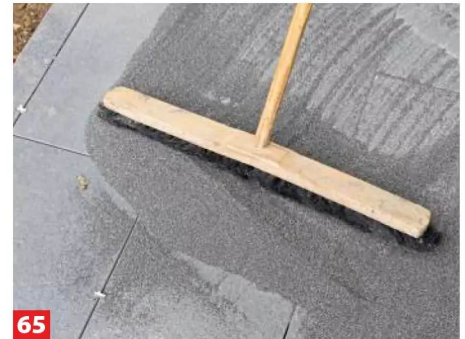
65 Fegen Sie den Edelsplitt diagonal und gerade in die Fuge ein und säubern die Oberfläche mit einem weichen Besen.
