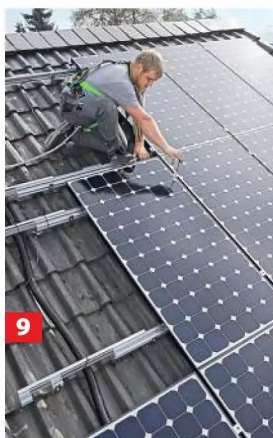
6 ... in die untere Nut der Schiene drücken und mit Kabelbindern fixieren. Dann an geeigneter Stelle über ein Leerrohr ...
