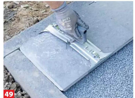
46 ... Platten dürfen nicht auf Stoß verlegt werden! Beim Messen von Restflächen diese Fugenabstände berücksichtigen.
