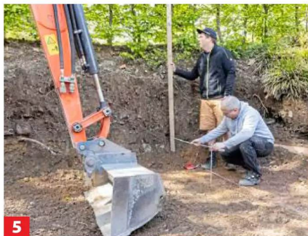
5 ... dafür Freiflächen und Wegstrecken ein. Während der Baggerarbeiten die Abtragung und Hangneigung kontrollieren.
