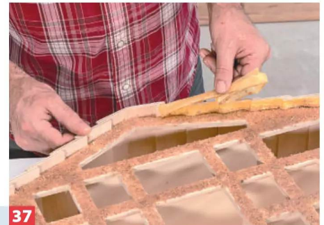
37 Das Klebeband möglichst zügig abziehen. Hier sehen Sie, wie der Holzleim bereits farblos (statt zuvor milchig) aufgetrocknet.
