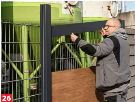
26 Wir haben neben Profilen in Holzoptik auch drei Reihen in Anthrazit eingebaut.
