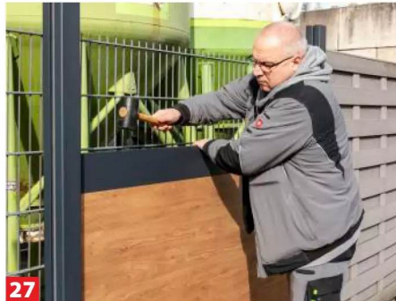
27 Die Füllprofile werden von Reihe zu Reihe auf die Verbinder gesteckt, ggf. nimmt man zum Einfügen einen ...
