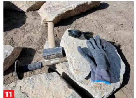
11 Mit Bossierhammer und Meißel die Steine spalten, mit dem Vorschlaghammer große Steine zu kleineren zerschlagen.
