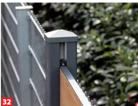
32 Als Pfostenabschluss stehen Deckel bereit, die man mit leichten Hammerschlägen fixiert.
