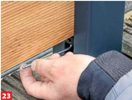
23 Sind Höhenkorrekturen nötig, lassen sich die Auflagennutensteine noch problemlos etwas nach oben oder unten setzen.
