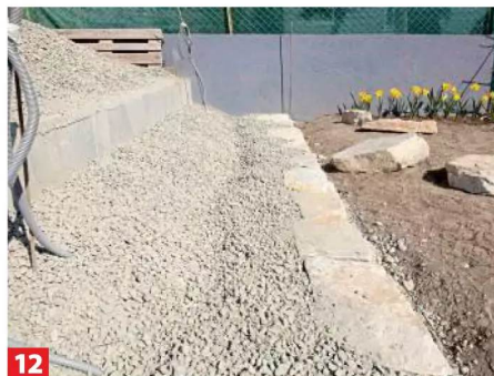
12 Beim Spalten eine Schutzbrille tragen! Nach der ersten Reihe weiter hinterfüllen, erst dann folgt die zweite Lage.
