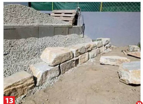
13 Die Steine mit mindestens 10, besser 20 Prozent Versatz zur ersten Lage setzen, um einen guten Verbund zu erzielen.
