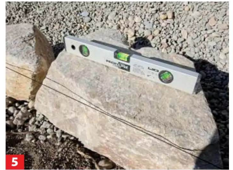
5 ... Steinreihe. Die Oberseite sollte exakt waagrecht verlaufen, da eine Höhenkorrektur in der nächsten Lage schwer ist.
