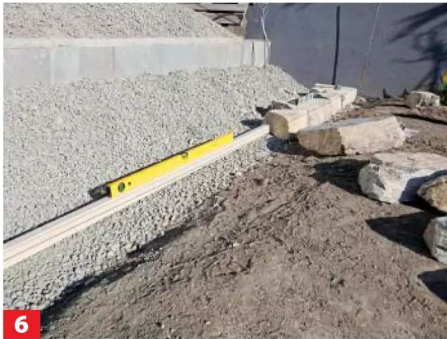
6 Eine Fluchtschnur spannen, die die Höhe und den Mauerverlauf abbildet, und alles mit der Wasserwaage kontrollieren!
