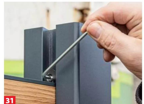
31 Um die Füllung zu fixieren, Spannnutensteine setzen und gegen Pfostennut und Füllung verschrauben.
