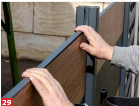
29 Die Abdeckung aufstecken. Sie dichtet die Nut des obersten Füllprofils ab.
