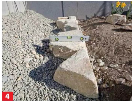
4 Unter der Mauer ein 30 cm tiefes Streifenfundament mit Schotter (Körnung 16-32 mm) anlegen. Es folgt die erste ...
