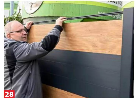
28 ... Gummihammer zur Hilfe. Das oberste Füllprofil schließt man mit einem Abdeckprofil.
