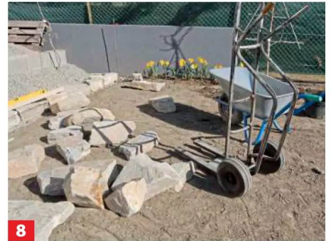
8 Beim Steintransport helfen Sack- und Schubkarre. Es gibt auch spezielle Steinkarren mit Gitter statt Wanne/Mulde.
