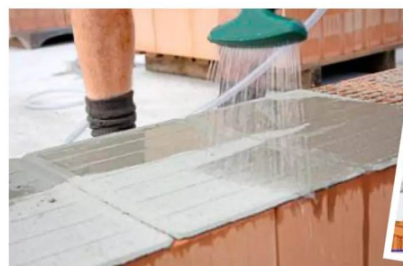
Zur Aktivierung der Mörtelpads gießt man einfach etwas Wasser darüber.
