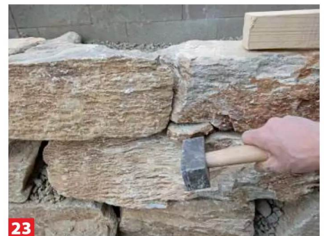
23 Dafür von großen Steinen dünne Plättchen absplitten, mit dem Bossierhammer anpassen und in die Lücken klopfen.
