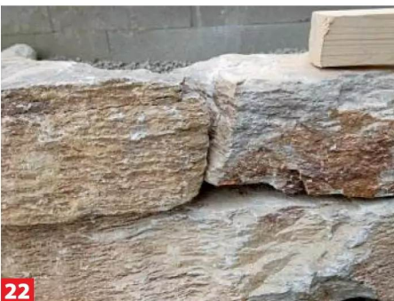
22 Damit die Steinlage stabil liegt, müssen auch kleine Lücken in der Mauer mit Steinplättchen geschlossen werden.
