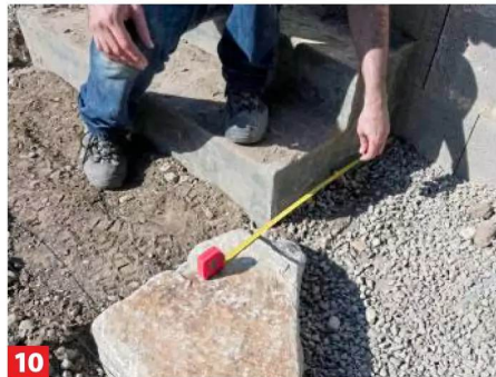
10 Lücken, hier vom Eckstein Richtung Terrasse, werden ausgemessen und die passenden Steine danach ausgesucht.
