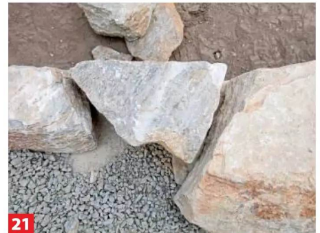
18 Auch beim Setzen des nächsten Ecksteins auf den hier nötigen Versatz von rund 20 Prozent der Steinlänge achten.
