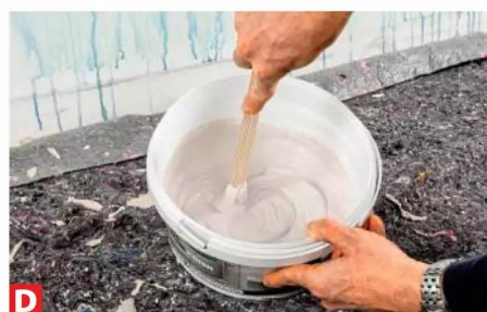
B Zunächst das gebrauchsfertige Basis-Gebinde mit dem Rührquirl etwas durchmischen.
