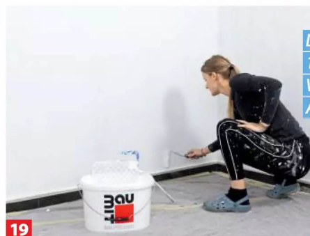
19 ... Trocknungszeiten von ca. 12 Stunden, bevor Sie erneut streichen.
