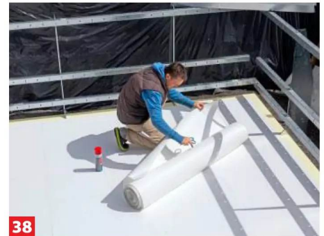
35 Fläche und Querträger abfegen, dann die Vinylplatten verlegen. Zunächst die Schutzfolie abziehen. Die Vinylplatten ...
