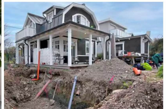
Pool: Schon beim Ausschachten selbst spätere Begrenzungssteine einplanen.
