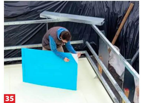
35 Fläche und Querträger abfegen, dann die Vinylplatten verlegen. Zunächst die Schutzfolie abziehen. Die Vinylplatten ...
