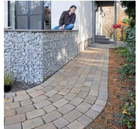
Anschluss: Die Breite eventueller Terrassenbegrenzungen muss bereits bei den Pflasterarbeiten eingeplant werden.
