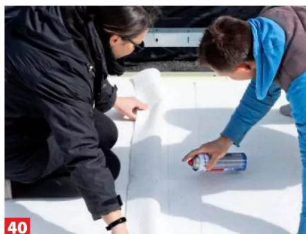
40 Es reicht aus, nur die Stoßstellen und den Rand zu verkleben. Sind Boden- und Vinylplatten sowie das Vlies darüber ...
