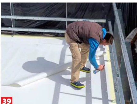
39 Das Vlies passend zuschneiden und mit Sprühkleber verkleben. Vorher schauen, dass keine Steine darunter liegen.
