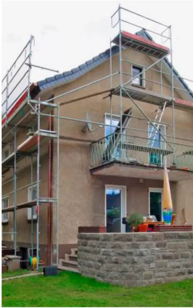
Anstrich: Gerüstbau beauftragen, Mietdauer kalkulieren, Anbauteile abnehmen.
