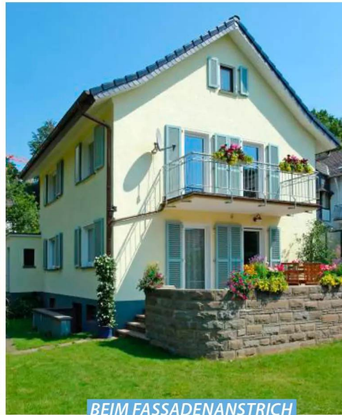
BEIM FASSADENANSTRICH GGF. LACKE UND SCHLEIFMITTEL FÜR DIE RENOVIERUNG VON KAPPLÄDEN EINPLANEN.
