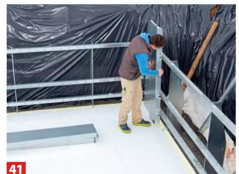
41 ... vollflächig verlegt, werden an den Seiten U-Bleche eingehängt, in die dann Dämmung eingeschoben wird.
