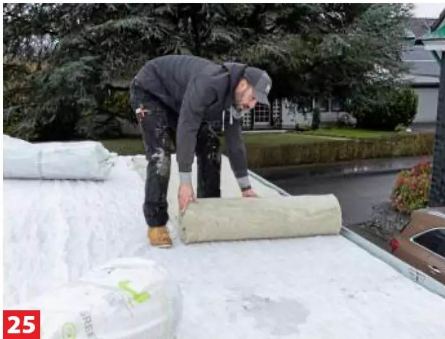
25 Auf die erneute Schutzschicht folgt jetzt die Green-Roll-Wachstumsmatte. Die einzelnen Bahnen dichtgestoßen ausrollen.
