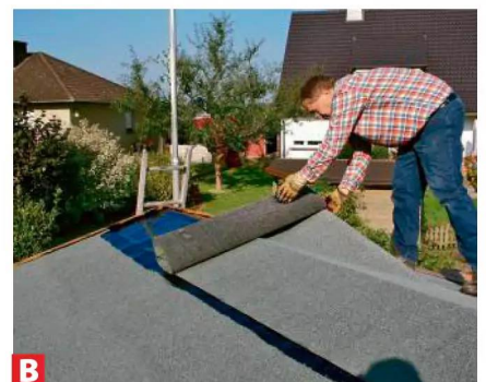
B Die neuen Dachbahnen luftblasenfrei in den Kleber einrollen.
