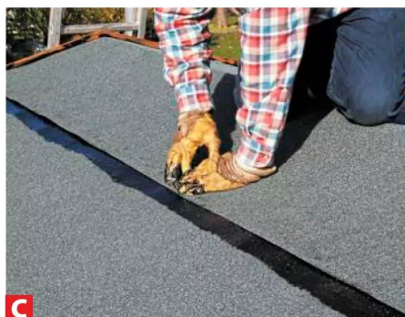
A Dach fegen, mit Bitumenvoranstrich grundieren, dann Bitumenkaltkleber auftragen.
