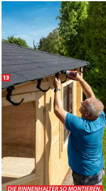
12 Es folgt das Rinnensystem. Die Montagepunkte der Rinnenhalter alle 50-70 cm am Stirnbrett des Hauses markieren.
