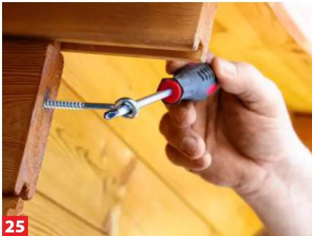
25 Die Ringschraube misst 6,0 x 70 mm und lässt sich weit eindrehen. Gut geht das mit einem Schraubendreher.
