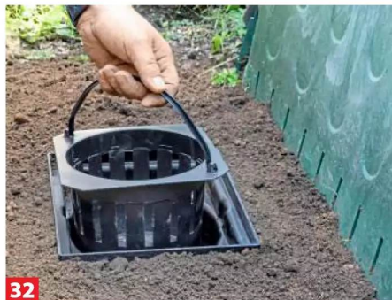
32 ... mit Kies und Schotter ausfüllen. Den in der Lieferung enthaltenen Schlamm-eimer später regelmäßig entleeren!
