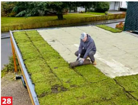
25 Auf die erneute Schutzschicht folgt jetzt die Green-Roll-Wachstumsmatte. Die einzelnen Bahnen dichtgestoßen ausrollen.
