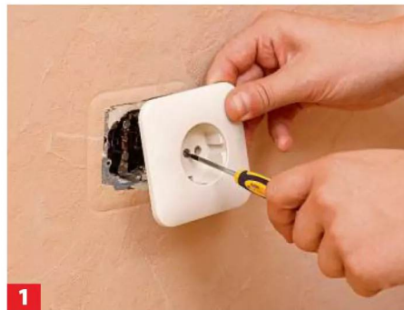
1 Schalter- und Steckdosenabdeckungen am besten demontieren. Dazu vorher die entsprechende Sicherung ausschalten!
