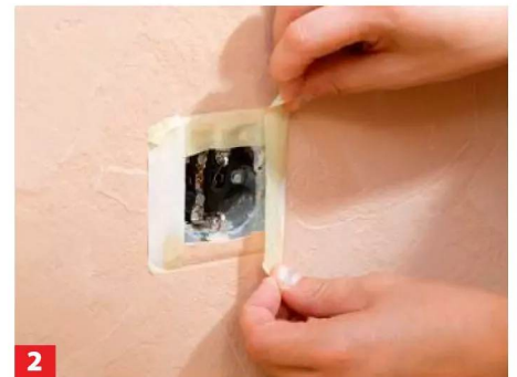
2 Anschließend kann man den Bereich gut abkleben und bis dicht heran den Putz auftragen.
