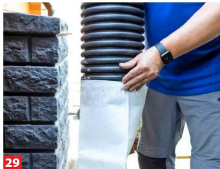
29 Den 58,5 cm hohen ACO-Sickerschacht mit Vlies umhüllen und die Grube ggf. ebenfalls mit Filtervlies auslegen.
