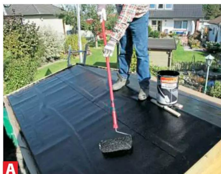
A Dach fegen, mit Bitumenvoranstrich grundieren, dann Bitumenkaltkleber auftragen.
