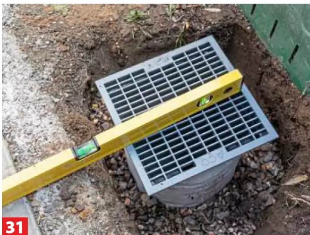
31 Den Schacht in der Grube positionieren und inkl. Abdeckung so ausrichten, dass anfallendes Wasser abfließt. Die Grube ...
