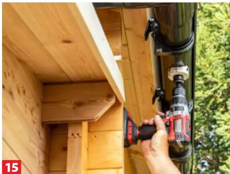
12 Es folgt das Rinnensystem. Die Montagepunkte der Rinnenhalter alle 50-70 cm am Stirnbrett des Hauses markieren.
