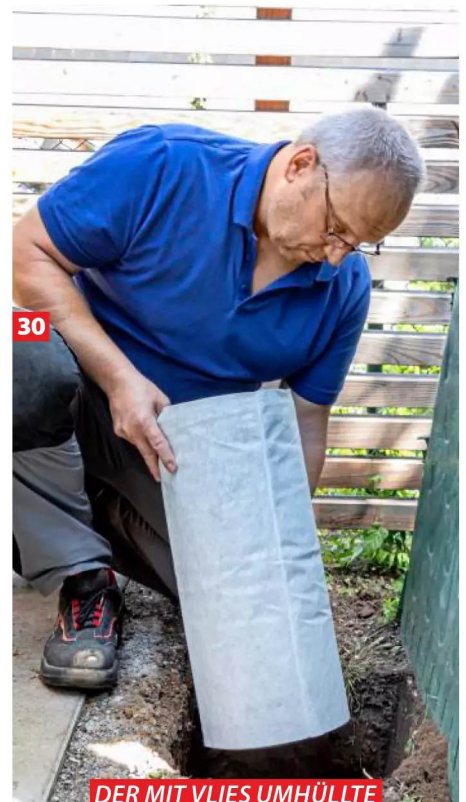
30 DER MIT VLIES UMHÜLLTE SCHACHT WIRD IN DIE CA. 70 CM TIEFE GRUBE GESETZT.
