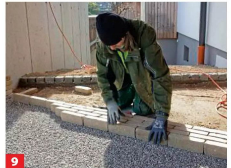
9 Beginnen Sie nun mit dem Verlegen der Klinker im Läuferverband. Die Steine werden hier hochkant verlegt.
