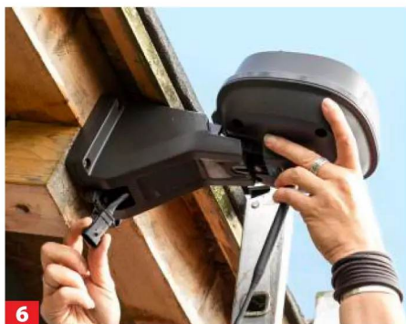
6 Verbindungskabel durch den Halter fädeln und Empfänger in Position bringen.
