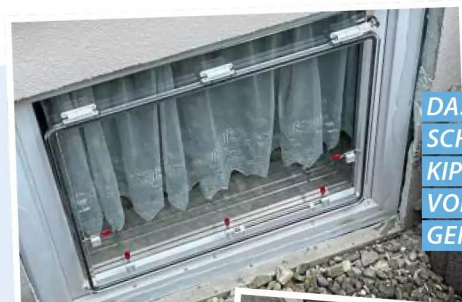
DAS ALTE FENSTER BLEIBT KOMPLETT ERHALTEN.
