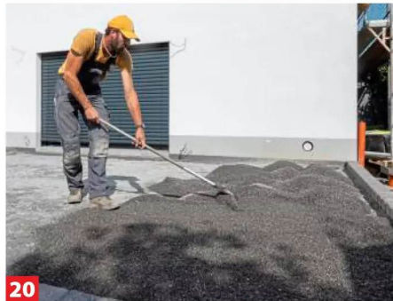
18 ... ausgebracht. Überprüfen Sie hier noch einmal mit dem Laser, ob die Endhöhe der Terrasse eingehalten wird.
