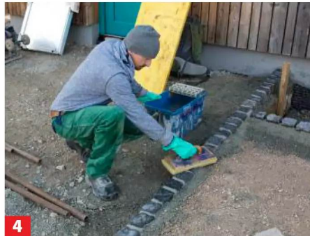
4 Die Steine lassen sich anschließend mit einem Fliesenlegerschwamm säubern.
