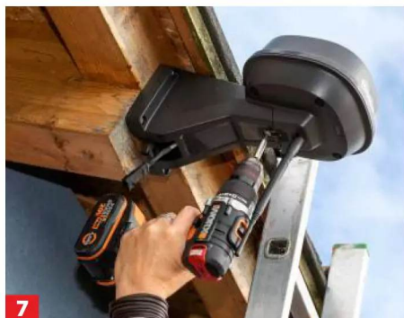
7 Mit einer Schraube wird das Modul im Halter fixiert – nicht zu fest anziehen!
