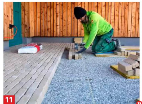
11 Alle vier Reihen ist die Fluchtschnur neu zu spannen, damit die Steinreihen schön gerade verlaufen.
