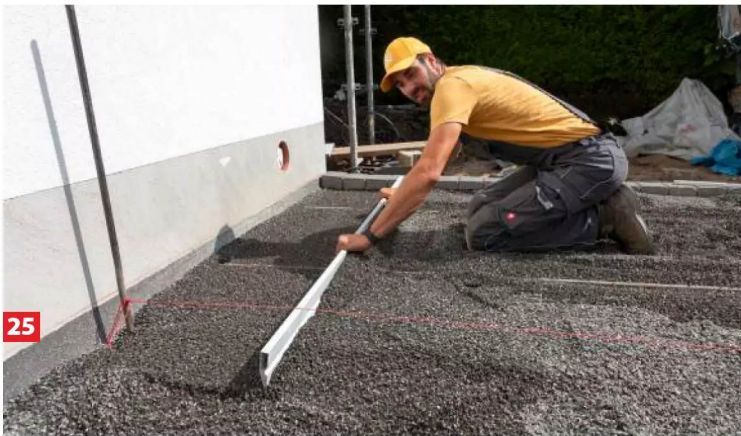
22 Das andere Schnurende wird an den Eisenpflock an der Hauswand gebunden. Anhand der gespannten Schnur ...
