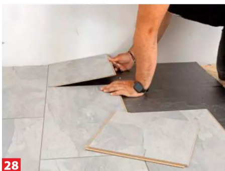
28 Die Paneele längs in die liegenden einschwenken, stirnseitig ans vorherige Panel schieben und herunterdrücken.
