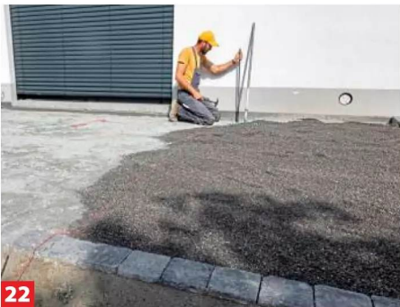
22 Das andere Schnurende wird an den Eisenpflock an der Hauswand gebunden. Anhand der gespannten Schnur ...
