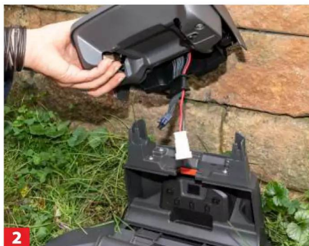
2 Stromkabel in die Station einfädeln, Lademodul mit der Grundplatte verbinden.
