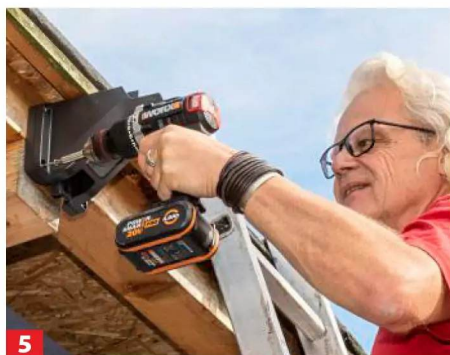
5 Der stationäre Satellitenempfänger wird an erhöhter Stelle montiert.
