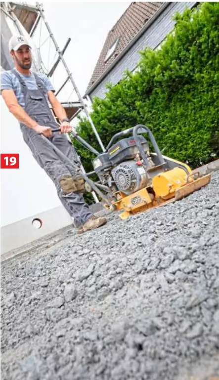
19 DER SCHOTTER WIRD ANSCHLIESSEND MIT EINER RÜTTELPLATTE VERDICHET. EINEN SOLCHEN RÜTTLER KANN MAN SICH IM BAUMARKT LEIHEN.
