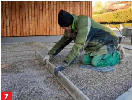
7 ... mit einer Richtlatte über die ausgelegten Wasserrohre glatt abgezogen.
