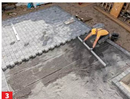
3 Arbeiten Sie sich Stück für Stück über die Fläche vor. Bevor die nächsten Steine gesetzt werden, ist das Splittbett ...
