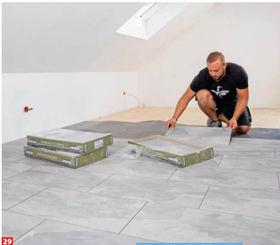
29 AUCH WENN ER NICHT GLEICHMÄSSIG AUSFALLEN SOLL - ACHTEN SIE AUF EINEN PANEELVERSATZ VON MINDESTENS 30 CM.
