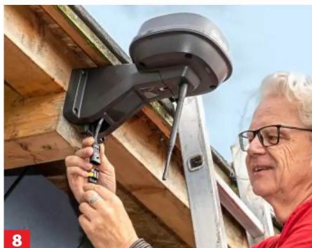
8 Schließlich die elektrische Verbindung zum Trafo herstellen.
