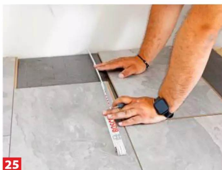
23 Möchten Sie einen gleichmäßigen Fugenversatz erhalten, schauen Sie direkt, wie die Paneele am Reihenende ...
