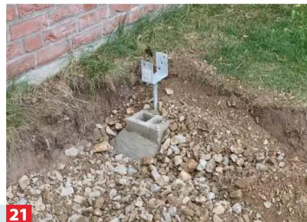
21 Die Fundamentsteine werden komplett eingegraben. Bei einer Steinhöhe von 8 cm wird eine Tragschicht von ...
