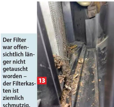
14 Vor dem Einsetzen des neuen Lamellenfilters den Filterkasten und den Wärmetauscher mit einem Sauger reinigen.
