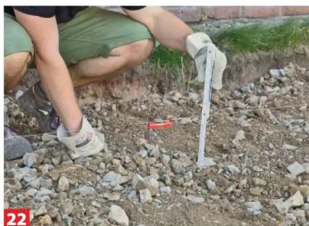
22 ... 15 bis 25 cm benötigt. Nachdem die Fläche nochmals abgerüttelt wurde, überprüfen Sie, ob das Höhenniveau der Terrasse ...
