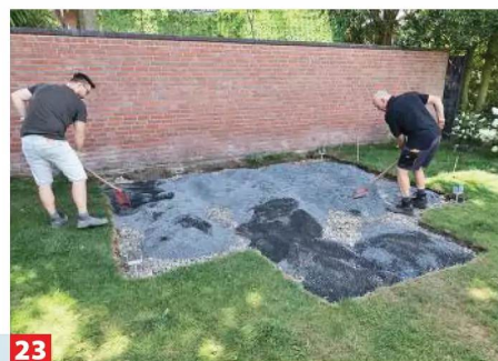
23 ... noch stimmt. Auf die Tragschicht kommt dann noch eine 4 cm hohe Splittschicht, z. B. aus Basaltsplitt 0-8 mm.
