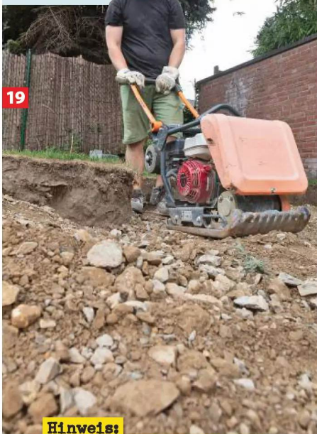
20 ... Rüttelplatte verdichtet. Nun wird die nächste Ladung des Kies-/Schotter-Gemisches auf der Fläche abgeladen.
