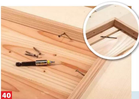
40 Zum Befestigen der Füllungsleisten am Türflügel wird vorgebohrt, anschließend werden die Leisten angeschraubt.
