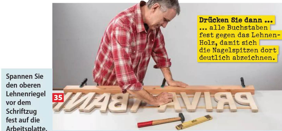
36 Anschließend den unteren Lehnriegel dagegen spannen. Nun sind alle Dübellöcher markiert.
