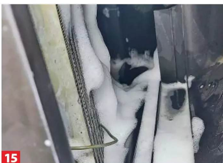
13 Der Filter war offensichtlich länger nicht getauscht worden – der Filterkasten ist ziemlich schmutzig.
