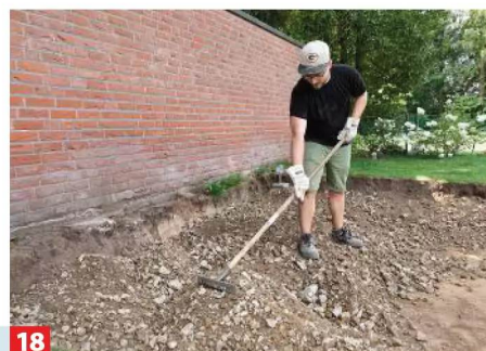
18 Mit einer Harke wird der Schotter zunächst grob auf der Fläche verteilt.
