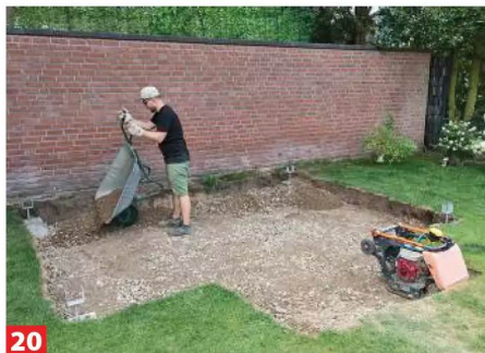
20 ... Rüttelplatte verdichtet. Nun wird die nächste Ladung des Kies-/Schotter-Gemisches auf der Fläche abgeladen.
